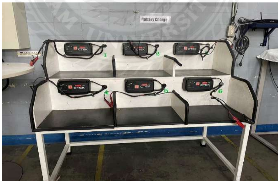
รูปภาคผนวกที่ 2 แทนติดตั้งเครื่องชาร์จแบตเตอรี่เดิม
