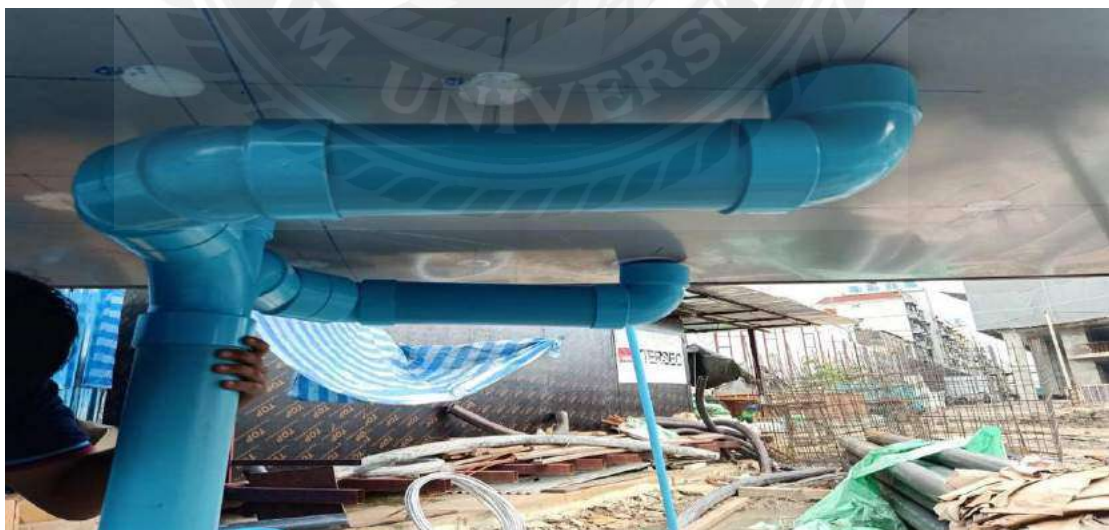
รูปที่ 4.10 การประกอบท่อไฮโดรคทที่ต่อจากท่อเมนหลัก ห้องคู่ (A,B,D)
