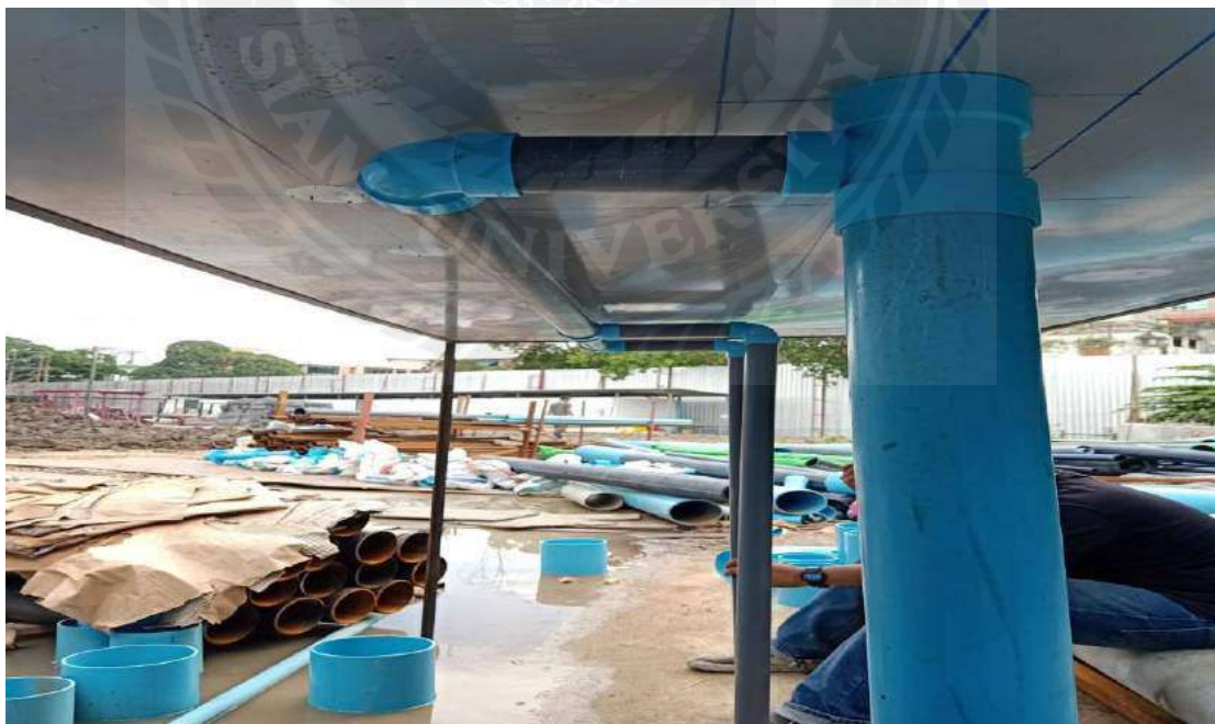
รูปที่ 4.12 การประกอบท่ออากาศที่ต่อจากท่อเมนหลัก ห้องคู่ (A,B,D)
