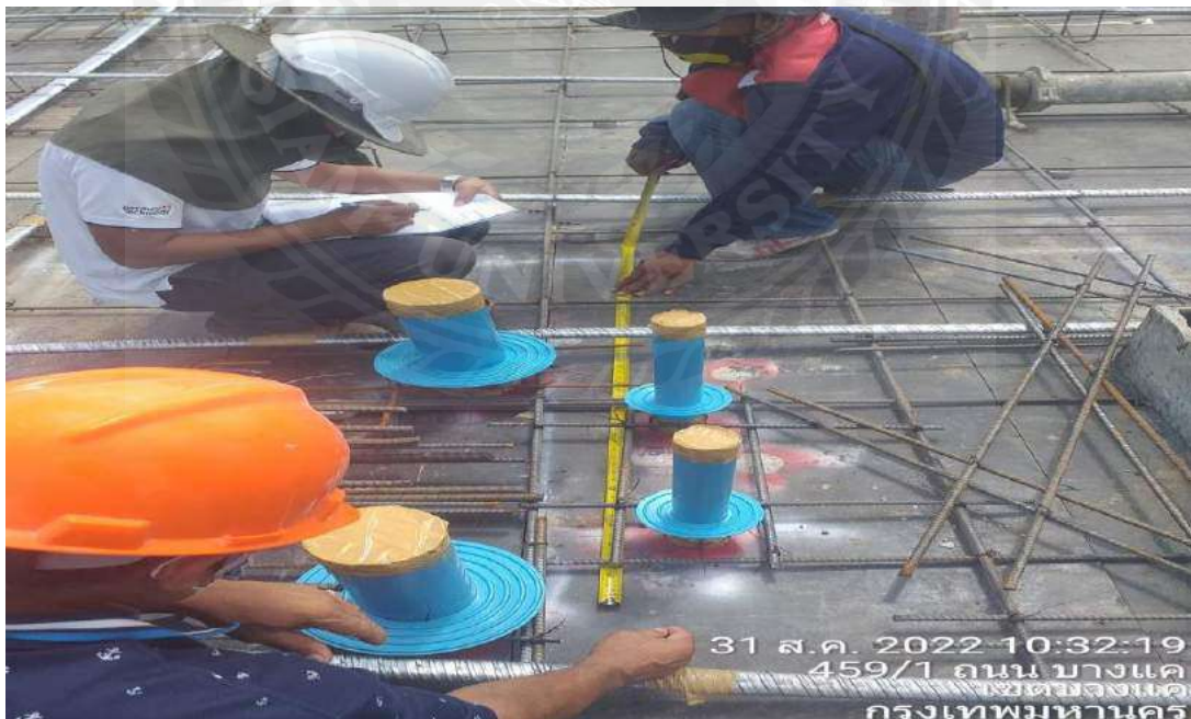
รูปที่ ก.2 ส่งงานระยะการวางท่อสลีฟก่อนเทคอนกรีต
