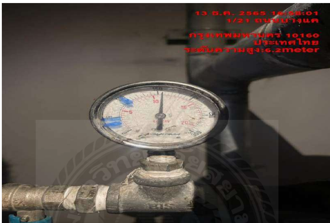
รูปที่ ก.3 การทดสอบน้ำท่อ Upfeed
