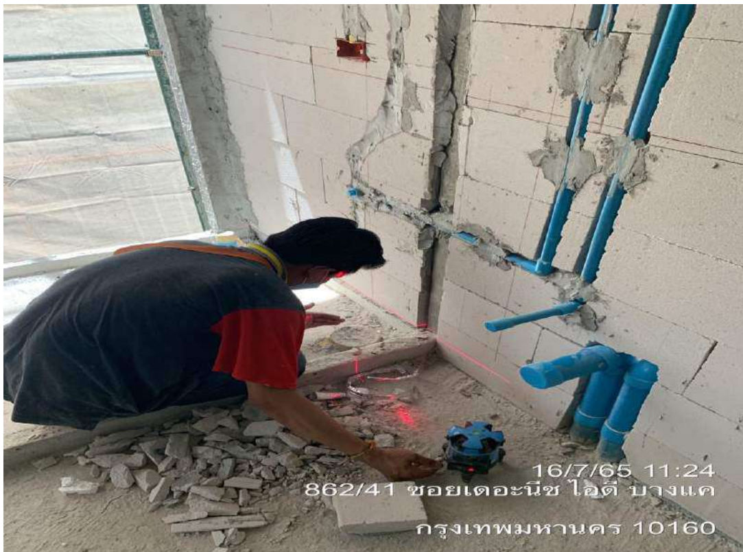
รูปที่ ก.5 ส่งงานวัดระยะและระดับของการติดตั้งหัวกระจายน้ำ
