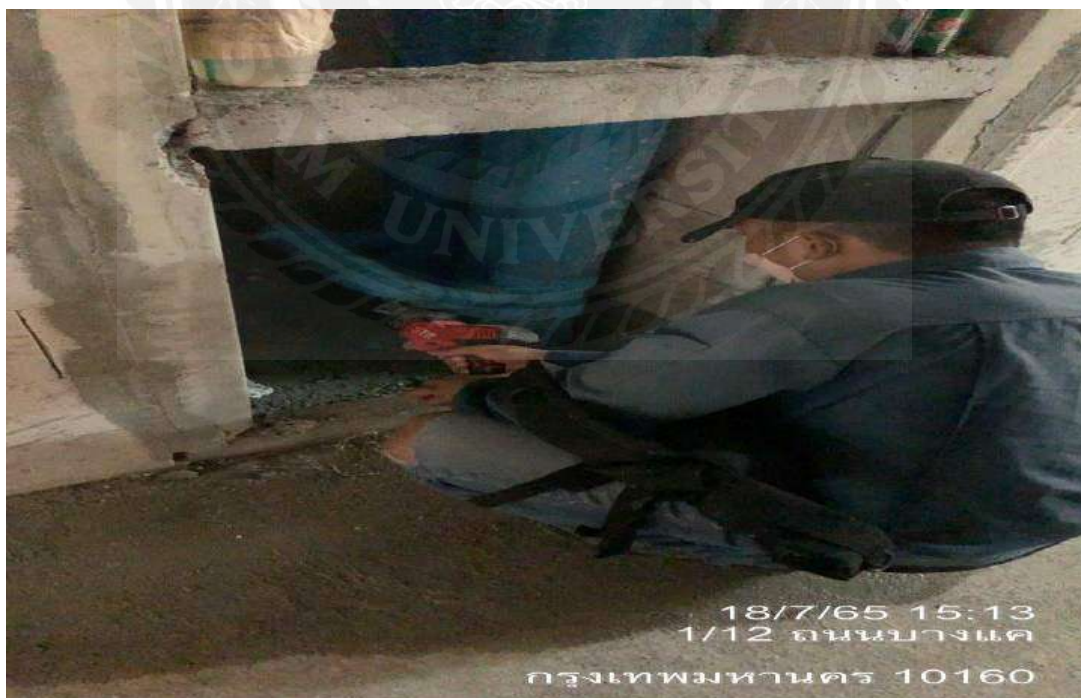
รูปที่ ก.4 นักศึกษาควบคุมงานการติดตั้งระบบท่อไฮโดรค ท่ออากาศและท่อน้ำทิ้งภายในอาคาร
