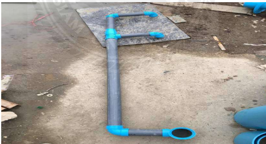
รูปที่ 4.14 ลักษณะการประกอบท่ออากาศตามแบบนวัตกรรม ห้องคู่ (A,B,D)
