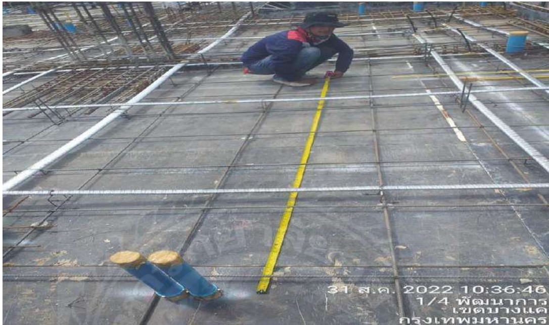
รูปที่ ก.1 การวัดระยะเพื่อวางท่อสลีฟก่อนเทพื้นคอนกรีต
