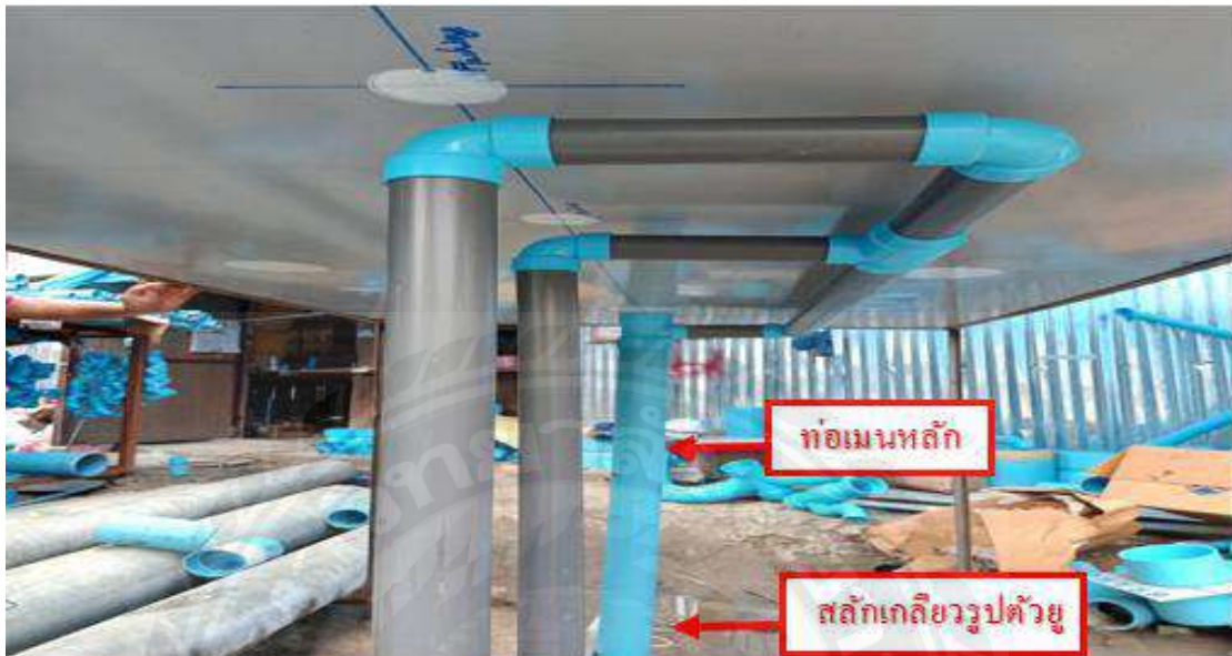
รูปที่ 4.9 การยึดท่อเมนหลักด้วยสลักเกลียวรูปตัวยู
