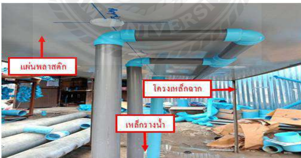
รูปที่ 4.8 การติดตั้งแผ่นพลาสติกกับโครงเหล็กฉาก และการยึดเหล็กรางน้ำ
