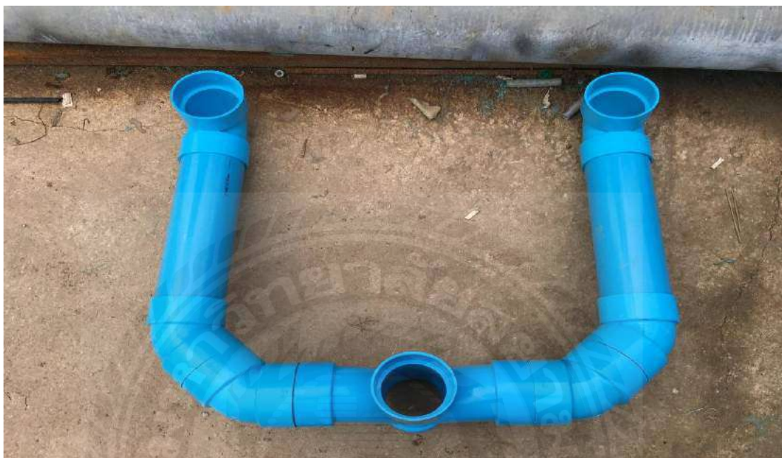
รูปที่ 4.13 ลักษณะการประกอบท่อโสโครกตามแบบนวัตกรรม ห้องคู่ (A,B,D)
