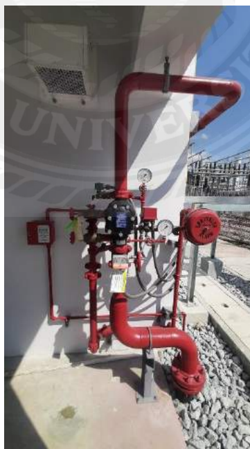
รูปที่ 3.13 Hydro Static Test
