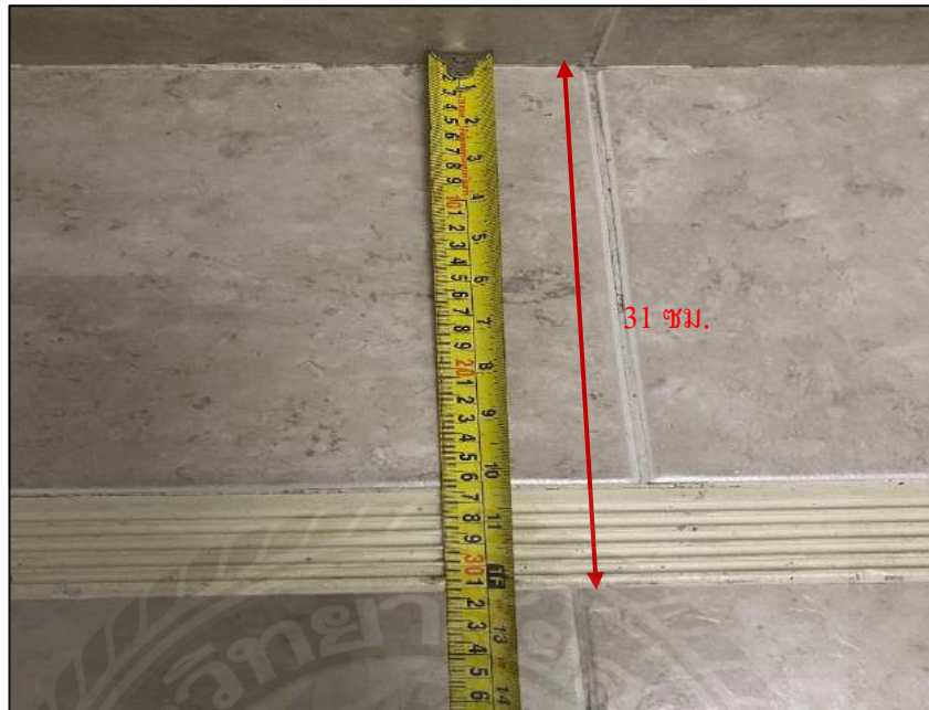
รูปที่ 3.20 ลูกนอนบันไดวัดได้ 31 ซม.
