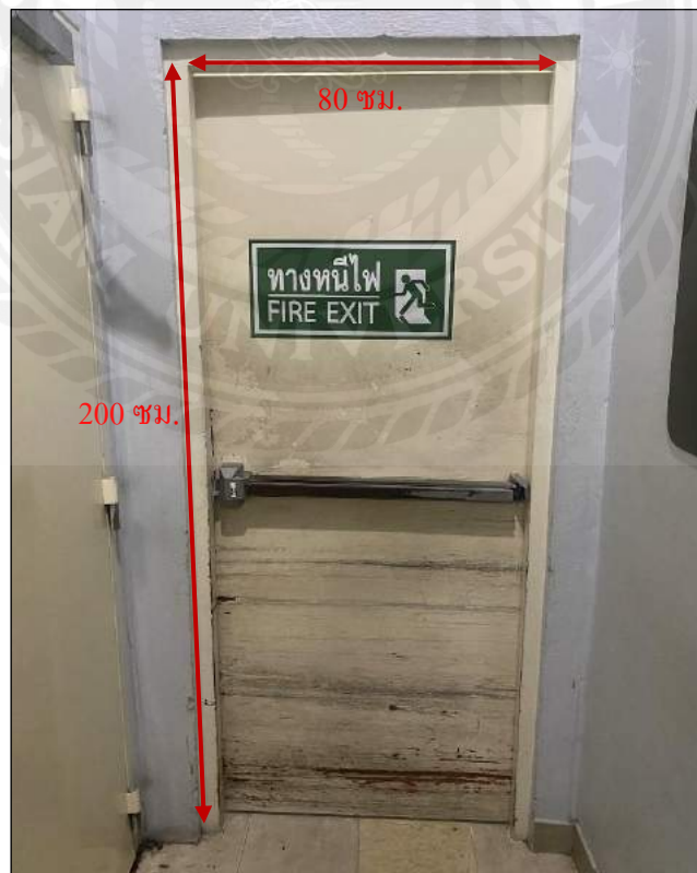
รูปที่ 3.29 ความกว้าง 80 ซม. ความสูง 200 ซม.
