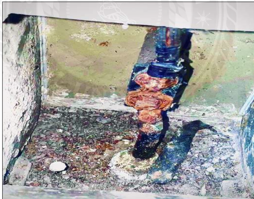
รูปที่ 3.33 จุดต่อประสานสักร้อยอยู่ในสภาพที่เก่าและมีสนิม
