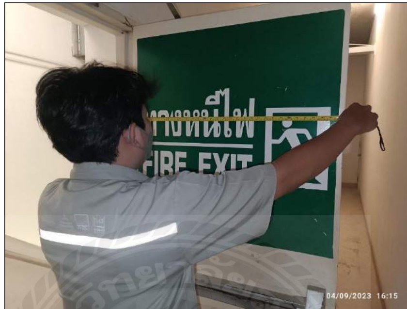
รูปที่ 3.22 วัดขนาดป้ายบอกทางหนีไฟ
