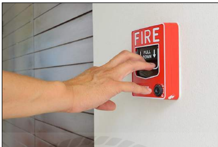
รูปที่ 2.5 อุปกรณ์แจ้งเหตุด้วยมือ
