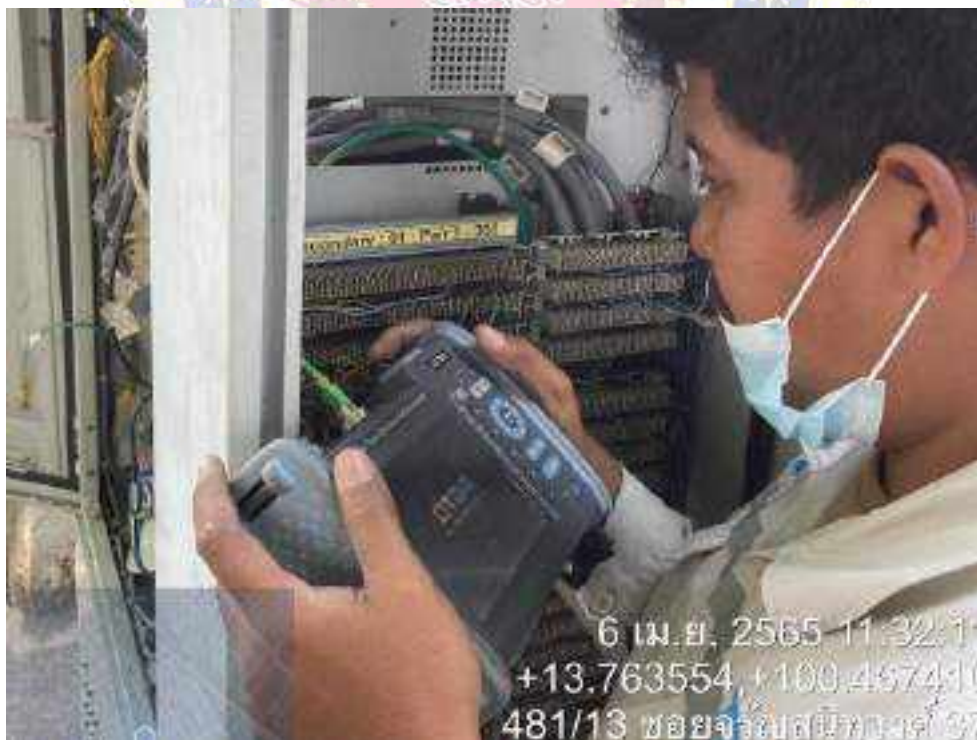
รูปที่ 3.21 วัดหาระยะสายและวิเคราะห์หาระยะของเหตุเสีย โดยใช้อุปกรณ์ OTDR
