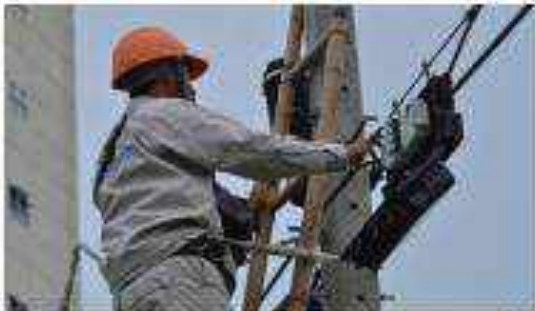
Fiber Drop Cable Installation เป็นหลักสูตรที่แนะนำสำหรับช่างที่ชำนาญการติดตั้งสายกระจายใยแก้วนำแสง เพื่อให้บริการ FTTx (TOT /BWA 2U) โดยเน้นให้มีควมรู้ ความเข้าใจ ในขั้นตอนและวิธีการติดตั้ง ให้เป็นไปตามมาตรฐานการติดตั้งบริการ TOT (BWA 2U)
