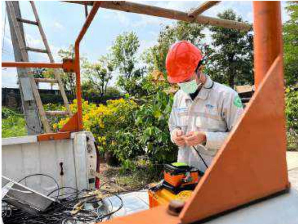
รูปที่ 3.24 เมื่อพบเหตุเสียแล้วดำเนินการ ตัดต่อสายใหม่ให้ได้คุณภาพคู่สายตามมาตรฐาน
