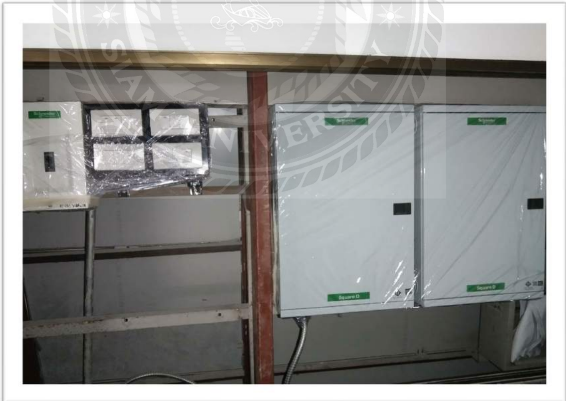
รูปที่ 4.5 การติดตั้ง Load center
