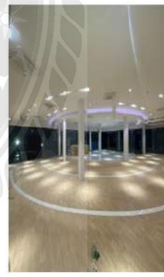
การติดตั้งไฟส่องสว่างและสวิตซ์ขั้ว
