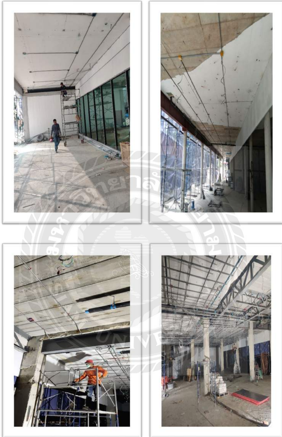
รูปที่ 4.1 การเดินท่อแบบฝังผนังและเดินลอยเหนือฝ้า
