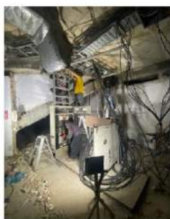
วางสายเคเบิลสายเคเบิลผู้ MOB เหนือฝ้าห้องประชุม
