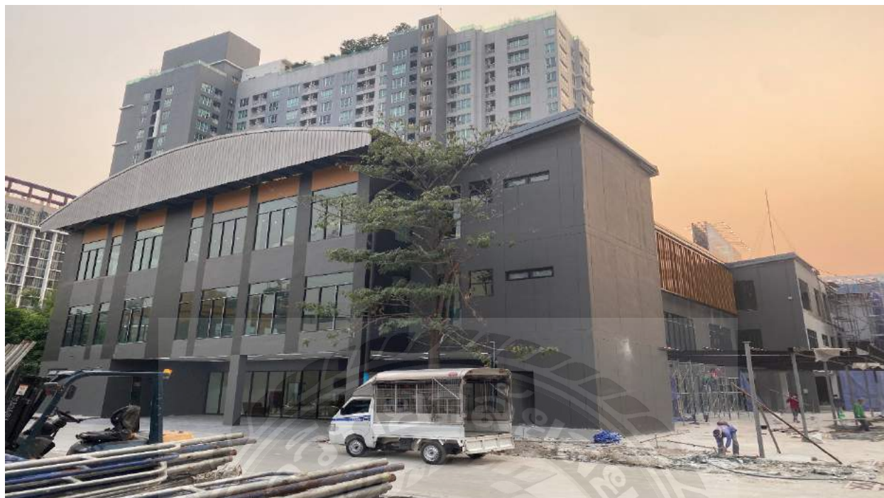
รูปที่3 ภาพระหว่างการดำเนินการก่อสร้าง
