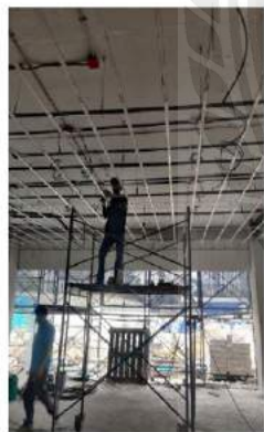
การติดตั้ง BOX และติดตั้งเพดาน
