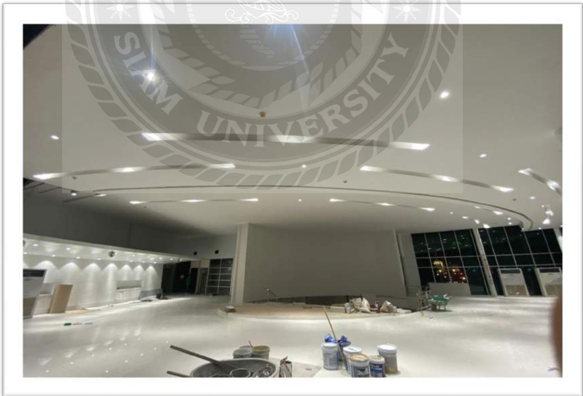
รูปที่ 4.4 การติดตั้งโคมไฟ และสวิตช์ปลั๊ก
