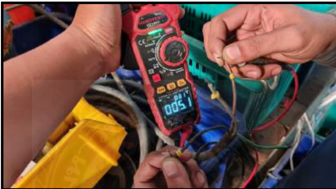
รูปที่ 4.4 การตรวจเช็คค่าความต้านทานของ U-V
