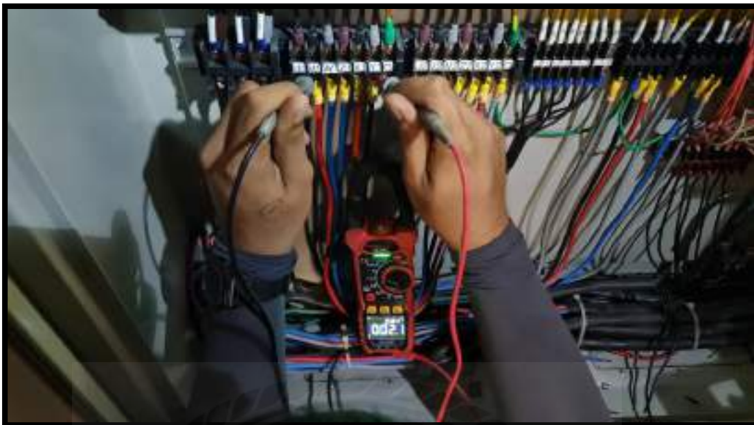
รูปที่ 4.8 การตรวจเช็คค่าความต้านทานของ V1-V2
