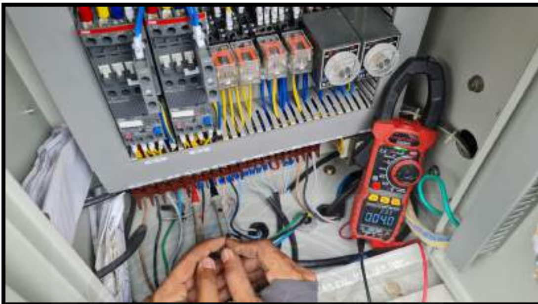
รูปที่ 4.2 การตรวจเช็คค่าความต้านทานของ U-W
