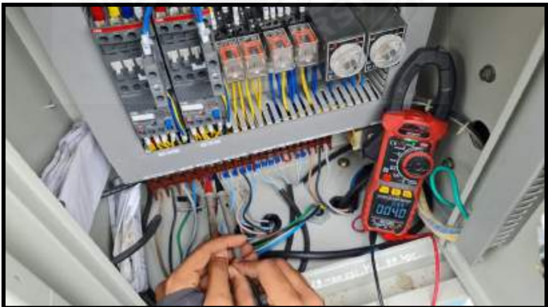
รูปที่ 4.1 การตรวจเช็คค่าความต้านทานของ U-V
