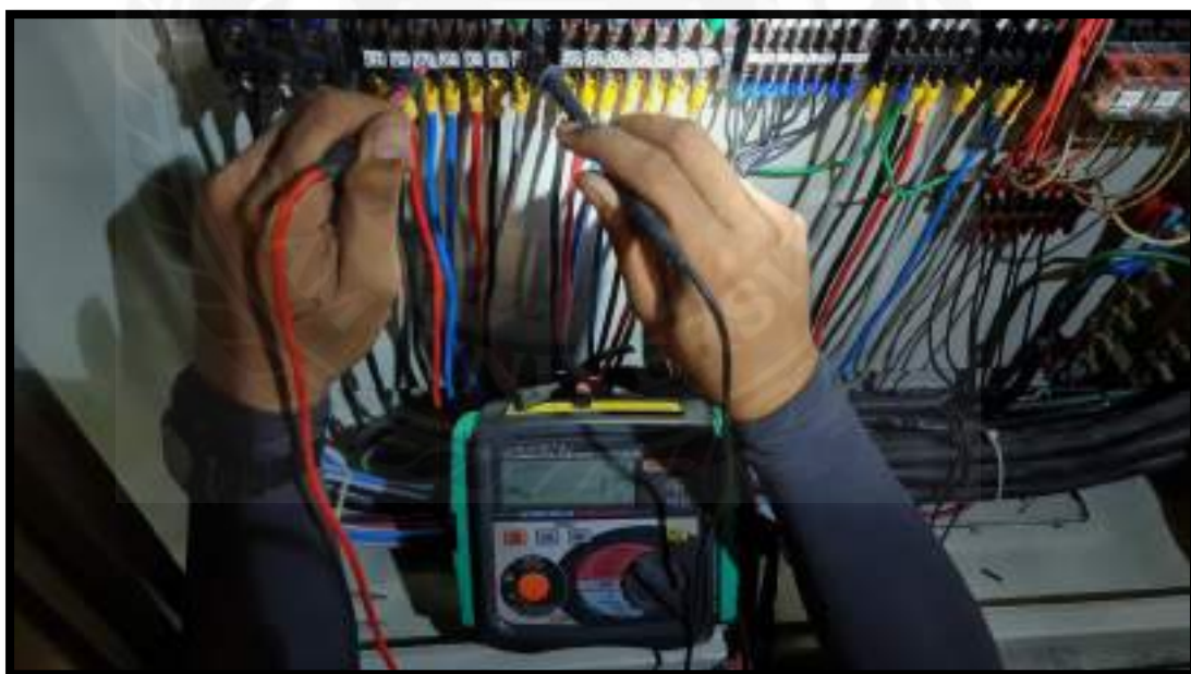
รูปที่ 4.18 ตัวอย่างการตรวจเช็คค่าความต้านทานของฉนวนของ W1-G
