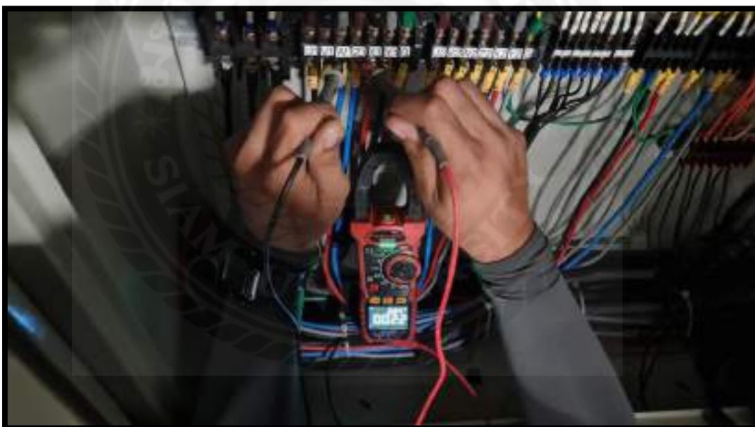
รูปที่ 4.9 การตรวจเช็คค่าความต้านทานของ W1-W2
