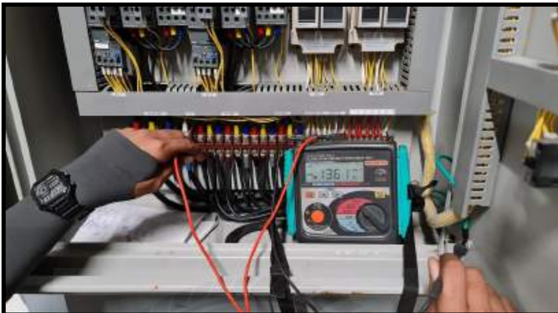
รูปที่ 4.15 ตัวอย่างการตรวจเช็คค่าความต้านทานของฉนวนของ W-G
