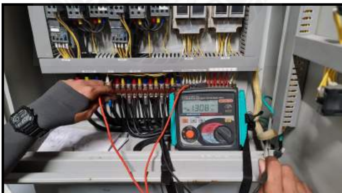
รูปที่ 4.14 ตัวอย่างการตรวจเช็คค่าความต้านทานของฉนวนของ V-G
