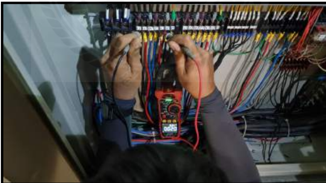
รูปที่ 4.7 การตรวจเช็คค่าความต้านทานของ U1-U2
