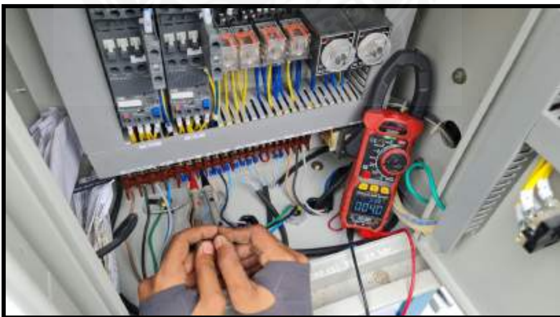
รูปที่ 4.3 การตรวจเช็คค่าความต้านทานของ V-W
