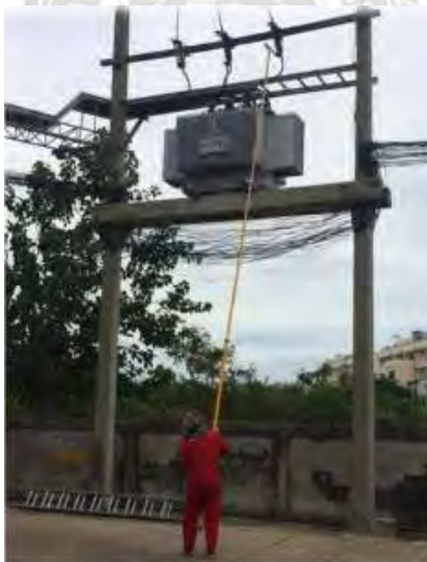
รูปที่ 4.18 การปลด Drop Out Fuse หม้อแปลงภายในของลูกค้ำ
