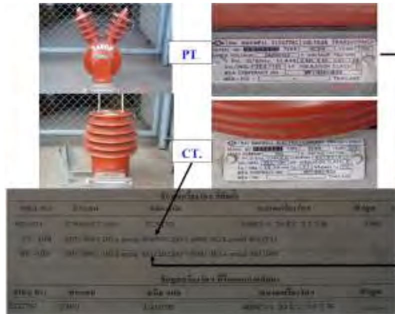
รูปที่ 4.17 ตำแหน่งหมายเลข Serial no. ของ CT และ VT
