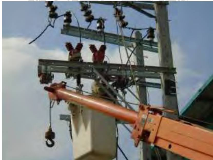
รูปที่ 5 ติดตั้ง CT, VT บนคานเหล็ก
