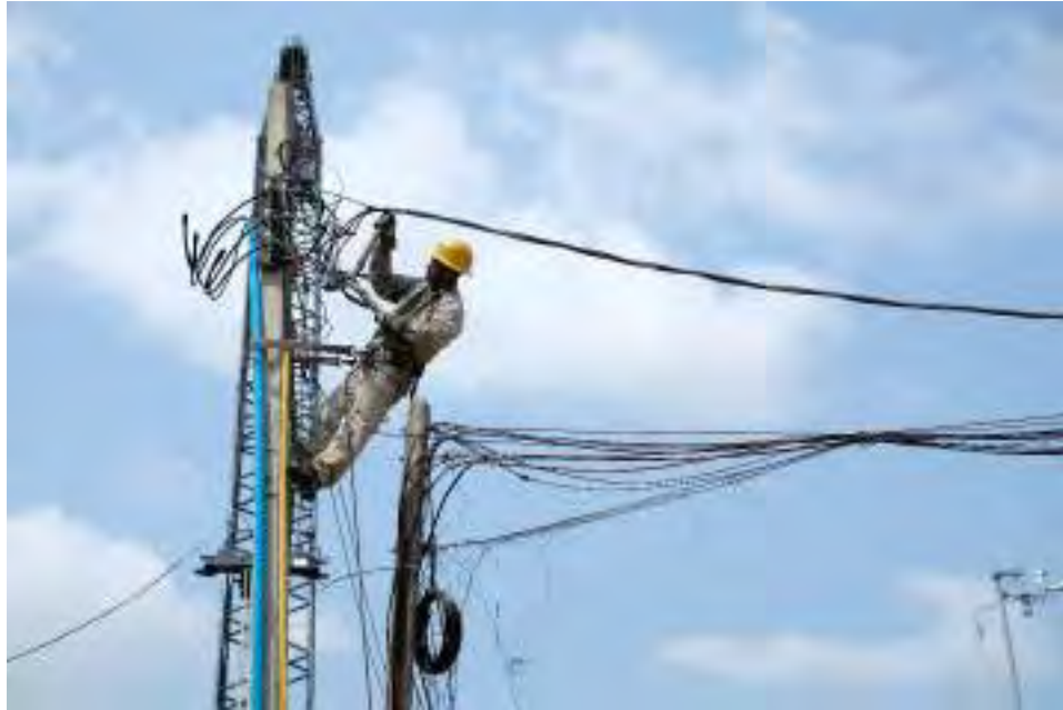
รูปที่ 12 การเชื่อมต่อสายเมน
