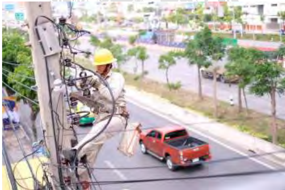
รูปที่ 13 การเชื่อมต่อสายเมน
