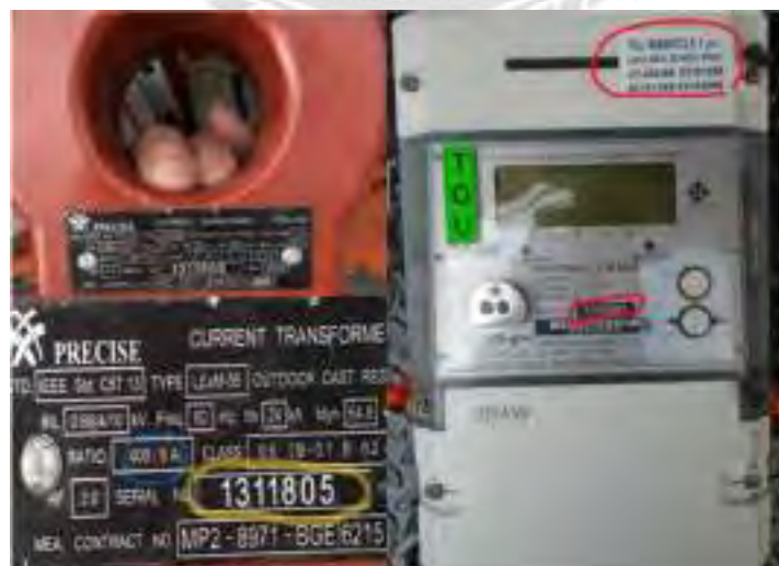
รูปที่ 4.7 ตำแหน่งหมายเลขรหัสเครื่องวัดไฟฟ้าและ Serial no.
