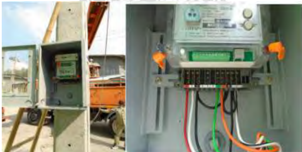
รูปที่ 4.22 การติดตั้งและการต่อสายเครื่องวัดไฟฟ้า
