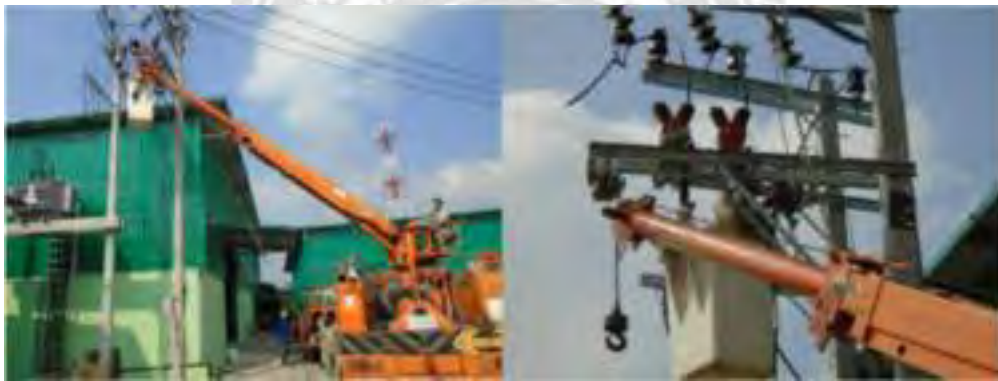
รูปที่ 4.20 การนำ CT และ VT ทั้ง 4 ลูก ขึ้นไปยึดติดไว้กับคานเหล็ก
