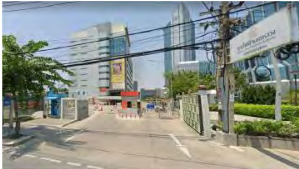
รูปที่ 3.3 การไฟฟ้านครหลวงเขตราชบุรีบูรณะ
