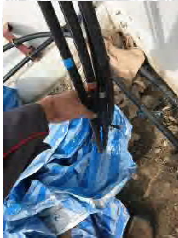
รูปที่ 4.9 ตรวจสอบการทำสัญลักษณ์บอกเฟสของสายเมนภายในของลูกค้า
