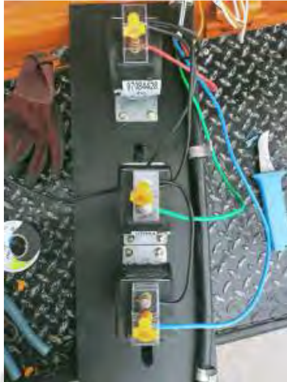
รูปที่ 2 การต่อวงจรด้านทุติยภูมิของ CT แรงดันต่ำ
