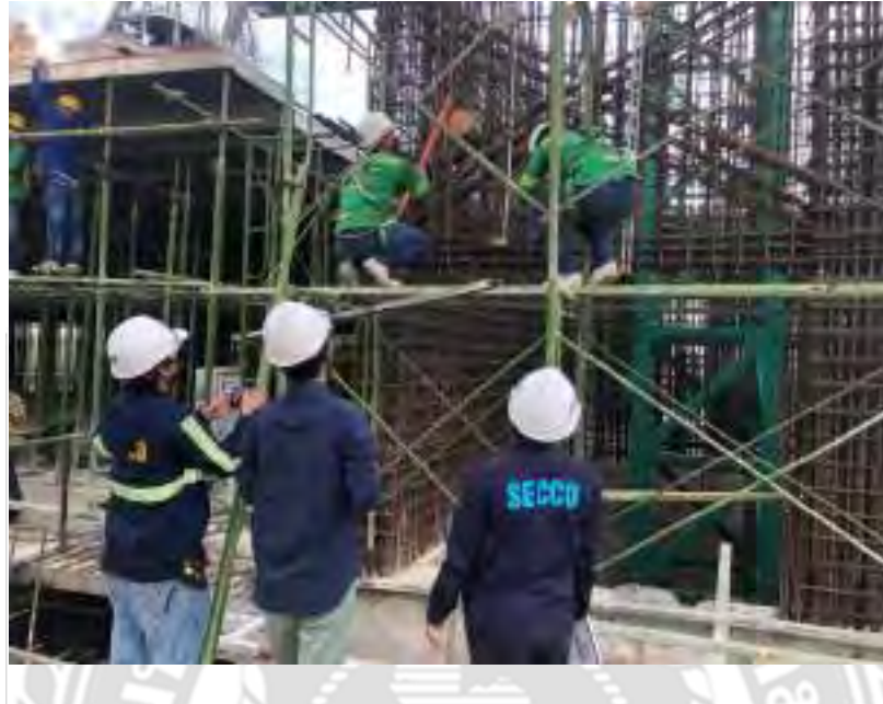
รูปที่ 4.12 ขั้นตอนการติดตั้งระบบ Galvanized Steel
