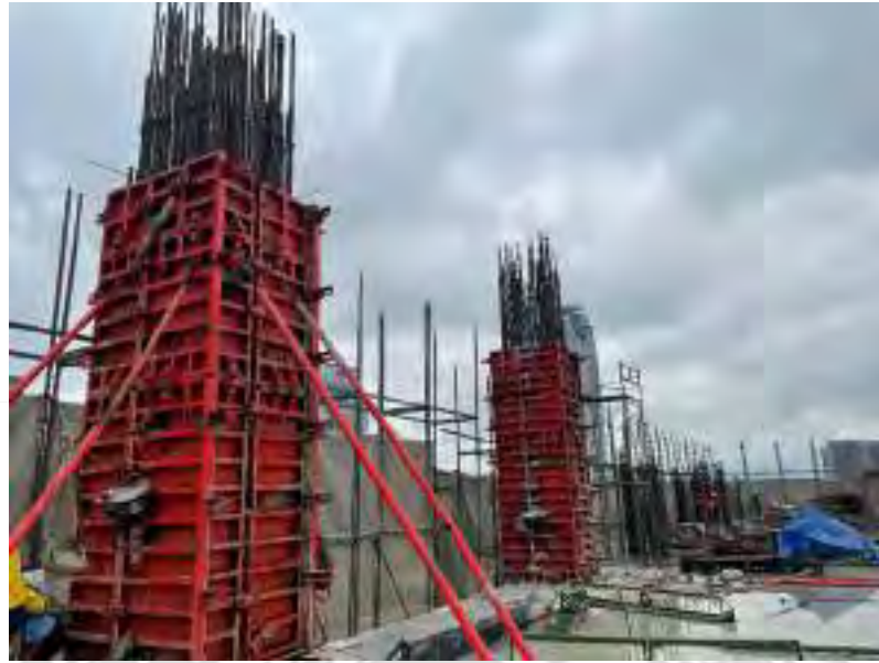
รูปที่ 4.14 ขั้นตอนการติดตั้งระบบ Galvanized Steel .
