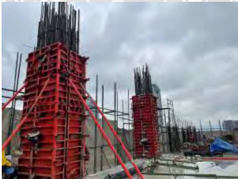
รูปที่ 4.13 ขั้นตอนการติดตั้งระบบ Galvanized Steel
