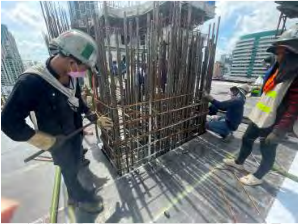
รูปที่ 4.16 ขั้นตอนการติดตั้งระบบ Galvanized Steel
