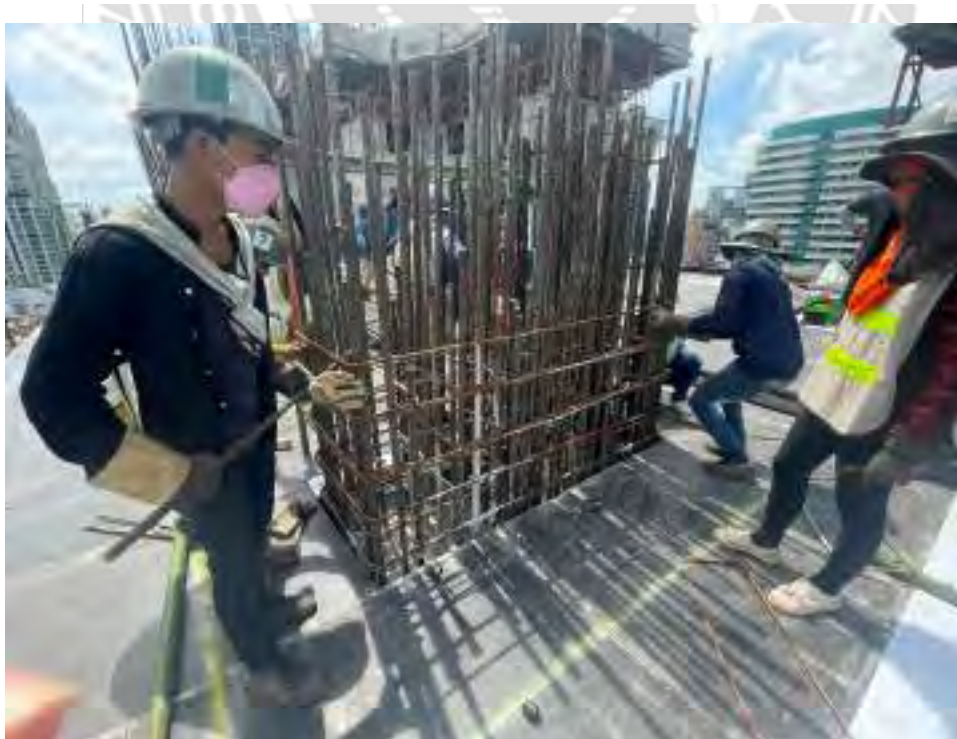
รูปที่ 4.17 ขั้นตอนการติดตั้งระบบ Galvanized Steel
