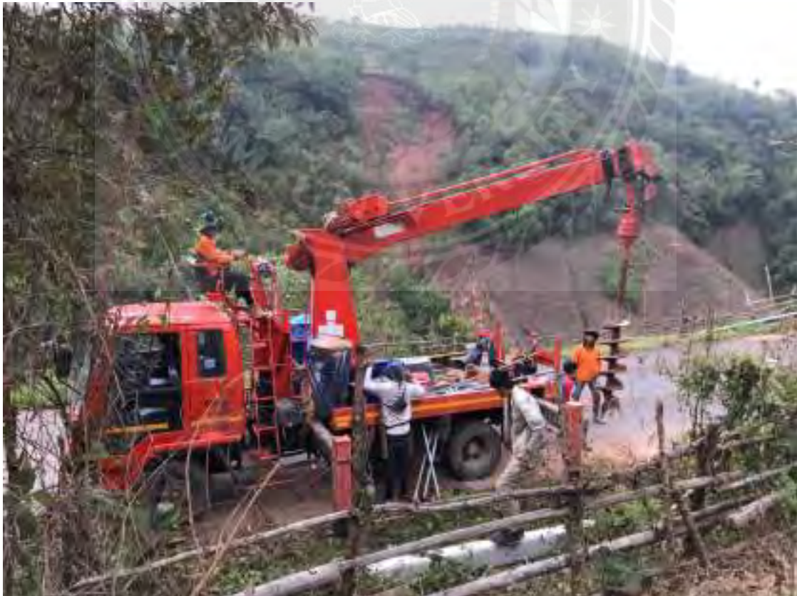
ขุดหลุมโดยรถขุด
