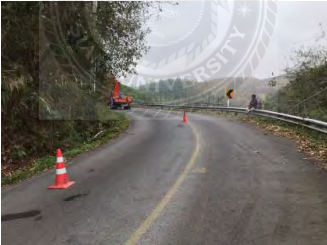
ตั้งกรวยจราจรขณะปฏิบัติงานบนไหล่ทาง
