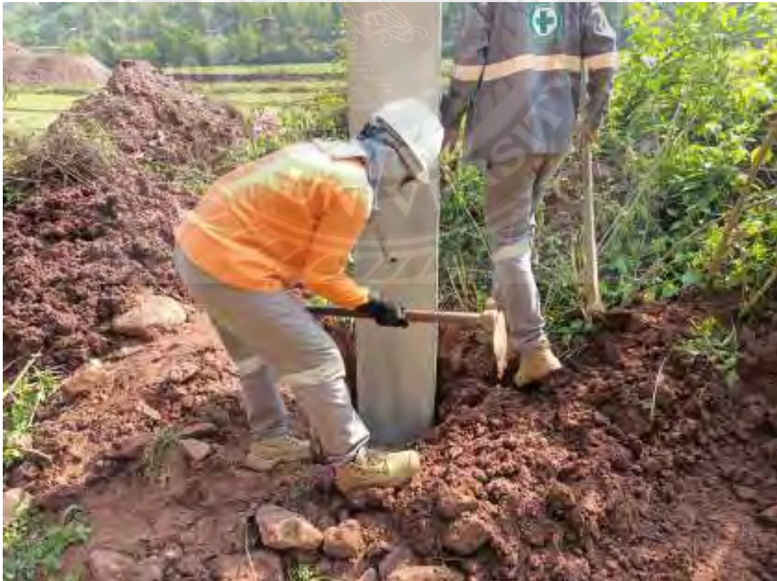
ปักเสาและทำการถมโคนเสา
