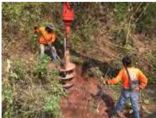
รูปที่ 4.2.3 ดำเนินการขุดเจาะหลุม
