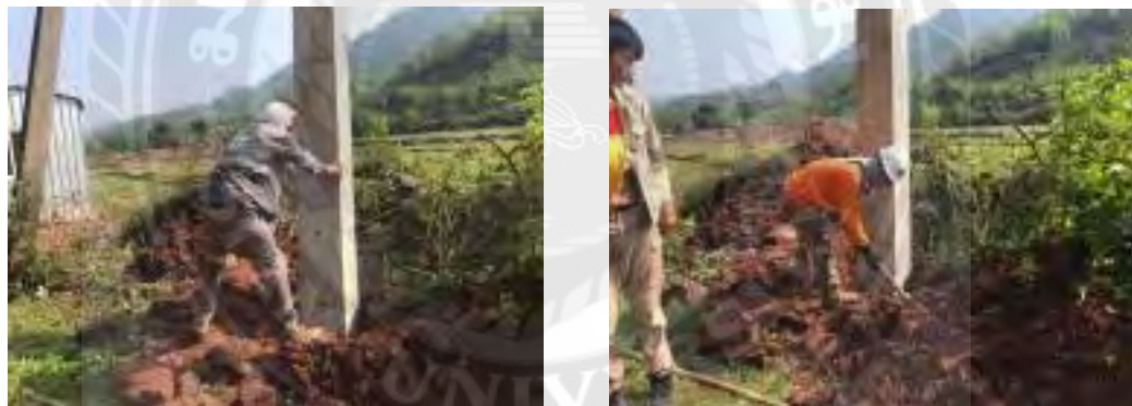
รูปที่ 4.2.4 ดำเนินการปักเสาและกลบหลุม
