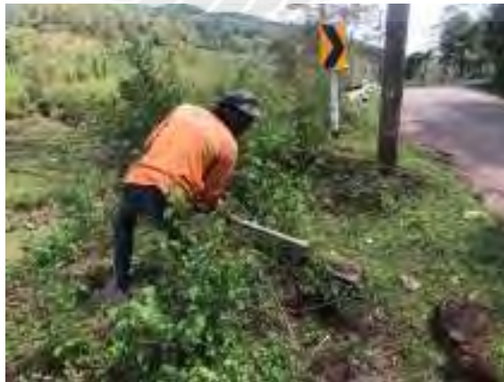
รูปที่ 4.2.2 ดำเนินการเตรียมพื้นที่ก่อนทำการชุดหลุมปักเสา
