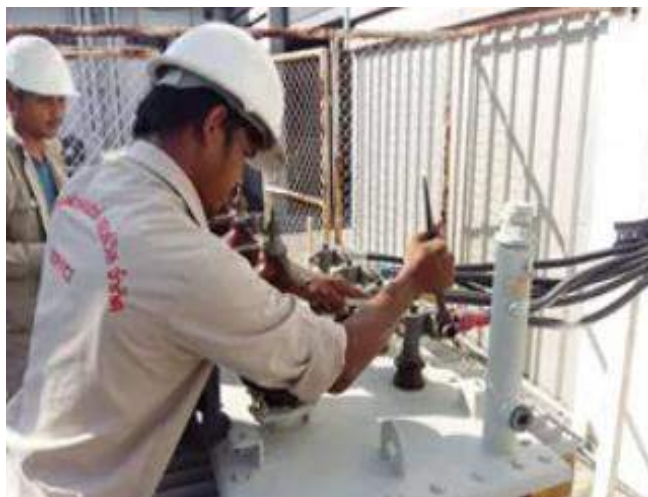
รูปที่ 4.4 ตรวจสอบ โบลต์และน๊อตของอุปกรณ์เชื่อมต่อระหว่างสายไฟด้านหนึ่งเข้ากับสายไฟ
