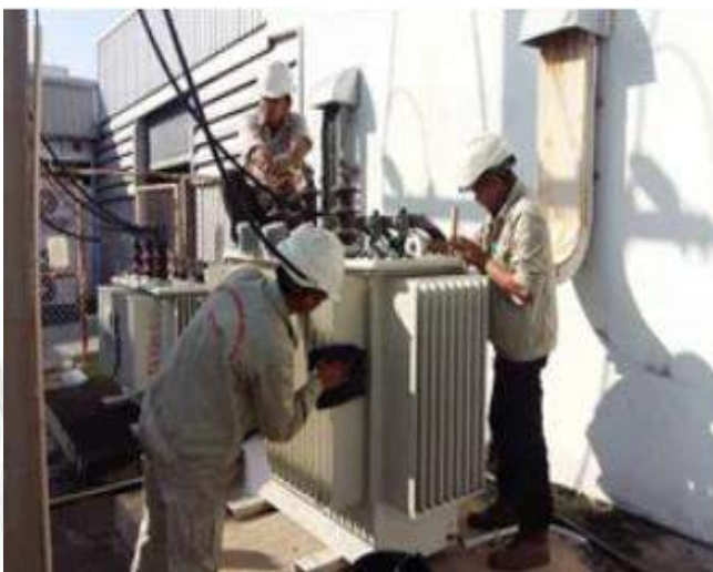
รูปที่ 4.1 การตรวจสอบหม้อแปลงไฟฟ้า
