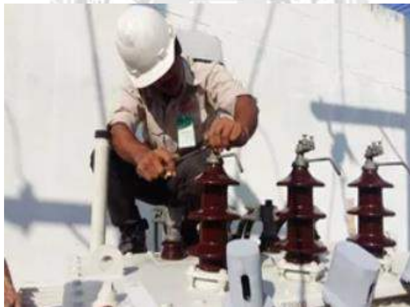
ตรวจสอบบุชชิงแรงสูง – แรงต่ำ
