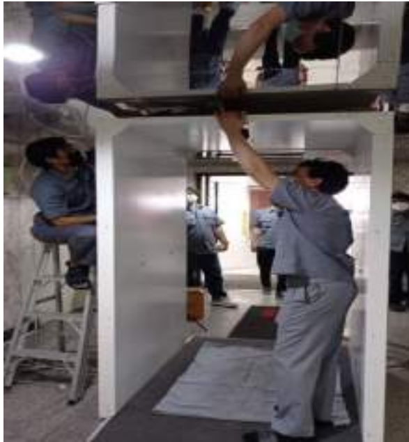
รูปที่ 4.20 ทำการวัดระยะเพื่อติดตั้งคอมไฟ
