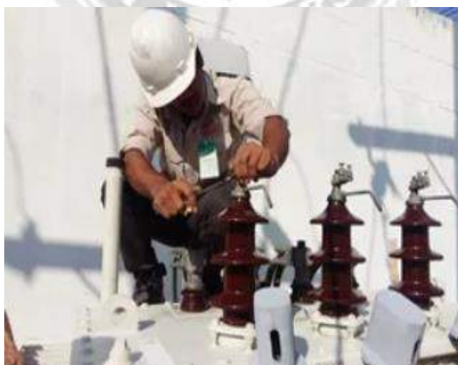
รูปที่ 4.3 ตรวจสอบบุชชิงแรงสูง – แรงต่ำ
