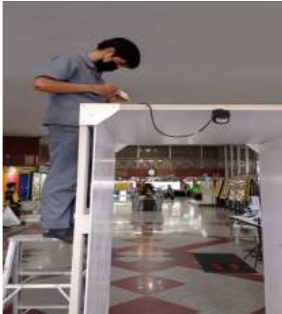
รูปที่ 4.18 ดำเนินการติดตั้งโคมไฟภายในอาคาร
