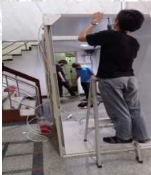
รูปที่ 4.19 ทำการเจาะรูเพื่อติดตั้งโคมไฟ
