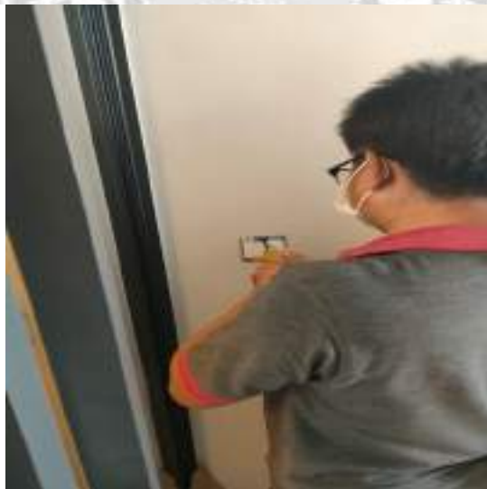
รูปที่ 4.23 การติดตั้งเต้ารับปลั๊กไฟ
