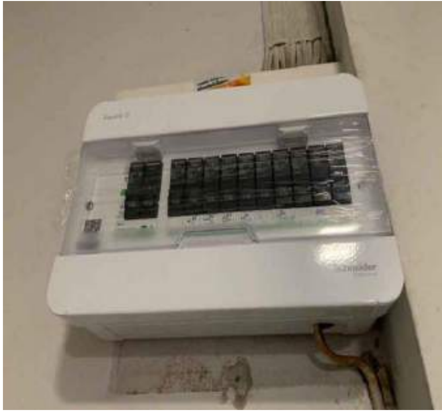
รูป 4.16 ติดตั้งตู้โหนดเซ็นเตอร์
