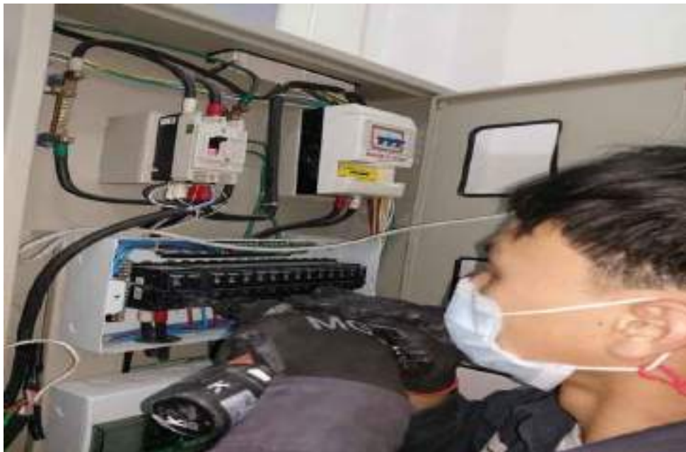
รูปที่ 4.15 การเข้าสายตู้โหนดเซ็นเตอร์
