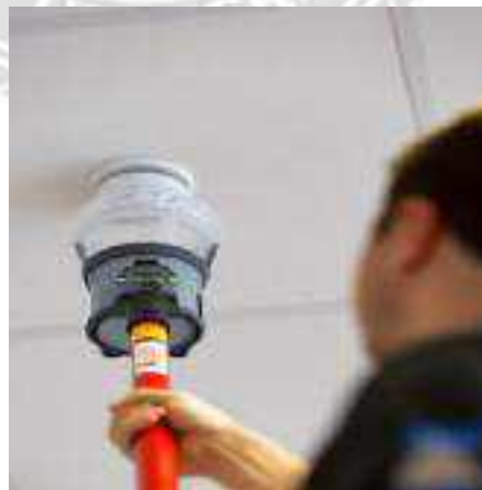
รูปที่ 4.6 ทำการ Test Smoke Detector
