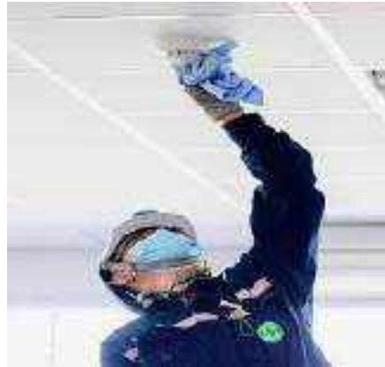
รูปที่ 4.7 ทำความสะอาด Smoke Detector และ Heat Detector
