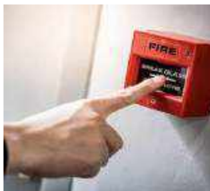
รูปที่ 4.8 ทำการ Test Manual Key และกระดิ่ง Bell
