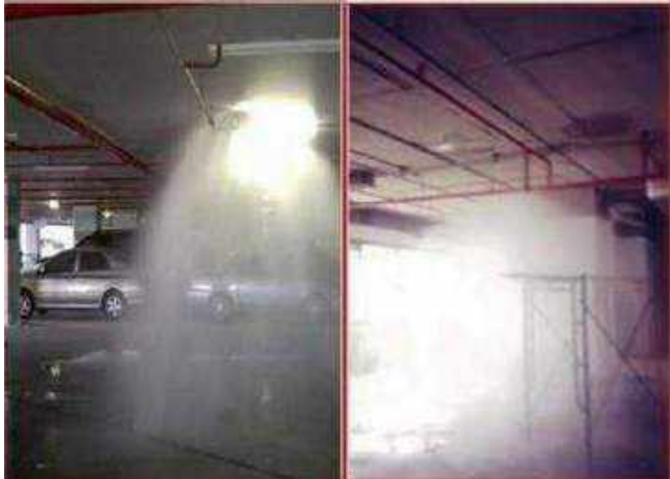
รูปที่ 4.11 การกระจายน้ำของหัวสปริงเกอร์
