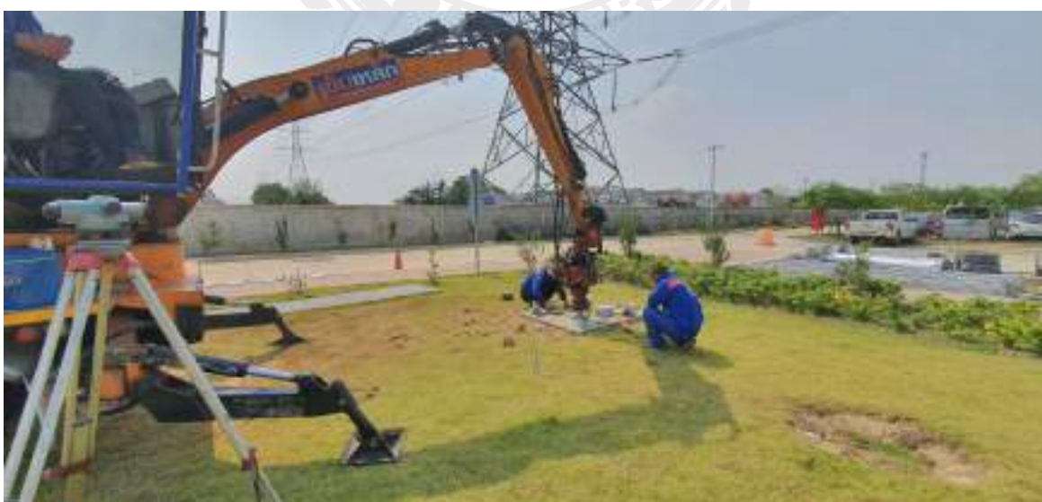
ดำเนินการลงเสาเข็มแบบสกรูพาย
