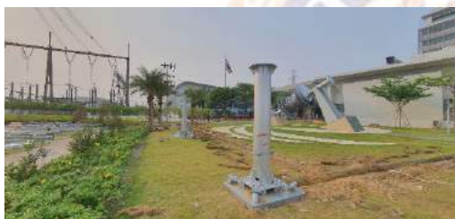
รูปที่ 4.2.4 ดำเนินการประกอบเสากับฐานราก
