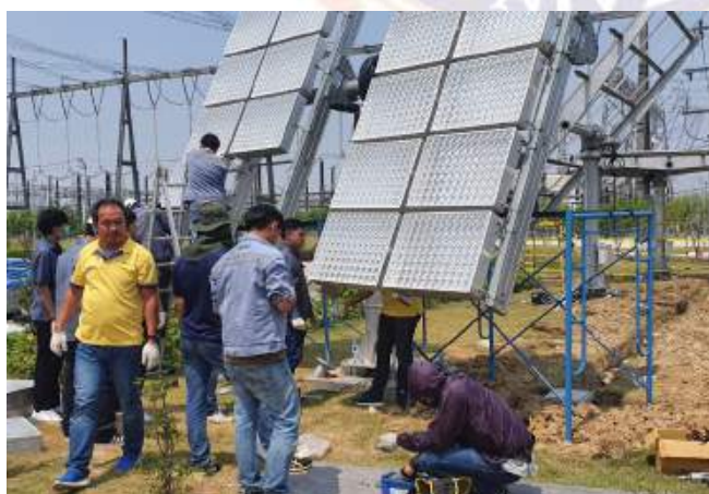
รูปที่ 4.2.5 ดำเนินการติดตั้งแผงโซลาร์เซลล์
