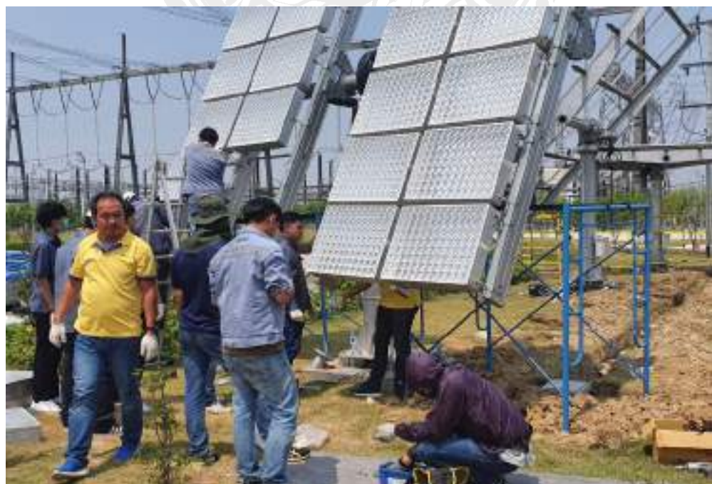
ดำเนินการติดตั้งแผงโซล่าเซลล์
