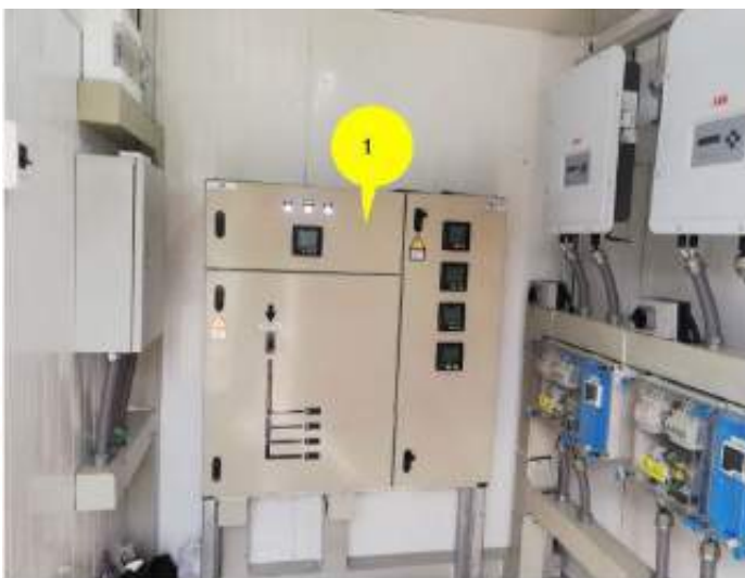
รูปที่ 4.2.7 ดำเนินการงานตรวจรับระบบไฟฟ้า
