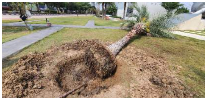
รูปที่ 4.2.2 ดำเนินการเตรียมพื้นที่ก่อนลงเสาเข็มแบบสกรูพาย
