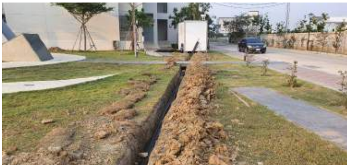
รูปที่ 4.2.6 ดำเนินการงานเดินท่อร้อยสายไฟแผงโซล่าเซลล์
