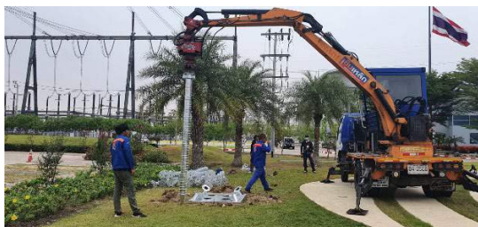
รูปที่ 4.2.3 ดำเนินการลงเสาเข็มแบบสกรูพวย
