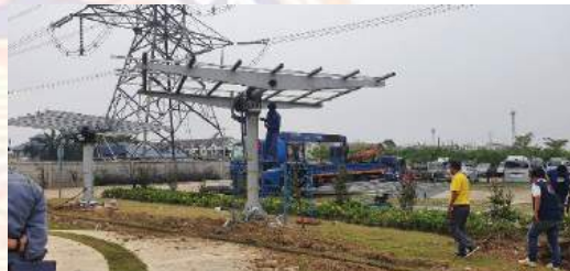
รูปที่ 4.2.4 ดำเนินการประกอบเสากับฐานราก
