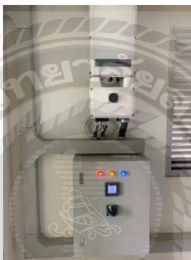
ภาพที่ 3.7 รูปภาพแสดงการอินเวอร์เตอร์และกล่องรวมสาย
