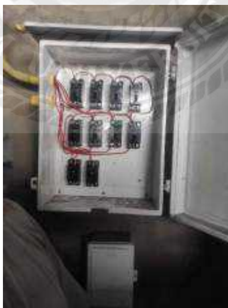
รูปที่ 2.13 เป็นการเข้าติดตั้งระบบไฟฟ้าสำหรับไฟส่องสว่างภายในโรงงาน
