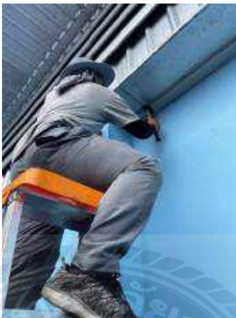
รูปที่ 2.18 เป็นการเข้าติดตั้งระบบไฟฟ้าสำหรับไฟส่องสว่างภายในโรงงาน
