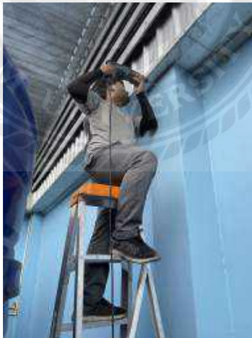
ทำการติดตั้งระบบไฟส่องสว่างภายในโรงงาน
