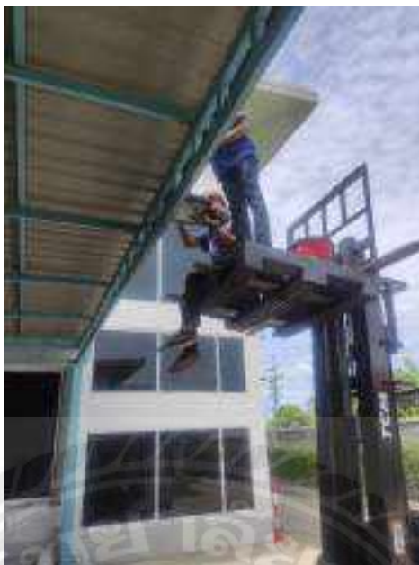
รูปที่ 2.16 เป็นการเข้าติดตั้งระบบไฟฟ้าสำหรับไฟส่องสว่างภายในโรงงาน
