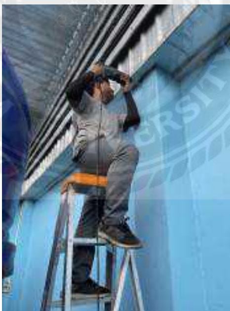
รูปที่ 2.19 เป็นการเข้าติดตั้งระบบไฟฟ้าสำหรับไฟส่องสว่างภายในโรงงาน
