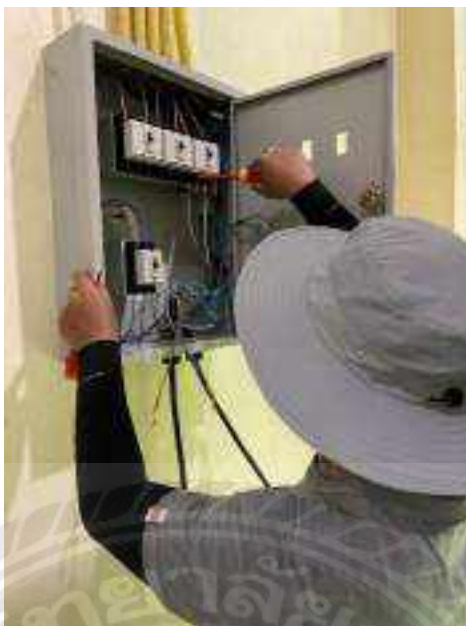
รูปที่ 2.8 เป็นการเข้าติดตั้งระบบไฟฟ้าสำหรับเครื่องผลิตน้ำจิ้มไก่แบบซอง
