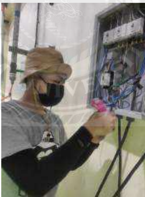
รูปที่ 2.9 เป็นการเข้าติดตั้งระบบไฟฟ้าสำหรับเครื่องผลิตน้ำจิ้มไก่แบบขวดเล็ก
