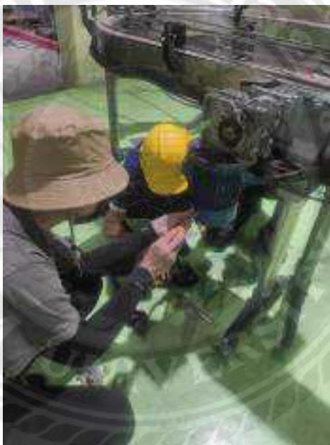
รูปที่ 2.2 เป็นการเข้าซ่อมบำรุงสายพาน
