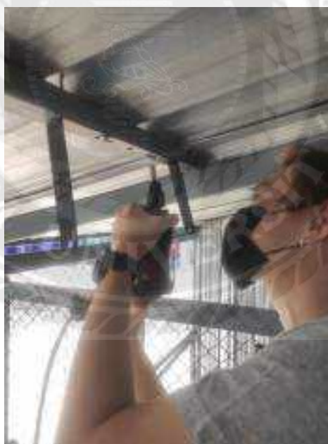
รูปที่ 2.15 เป็นการเข้าติดตั้งระบบไฟฟ้าสำหรับไฟส่องสว่างภายในโรงงาน
