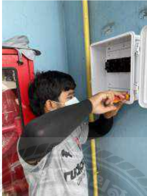
ติดตั้งระบบชาร์จรถยนต์ไฟฟ้า
