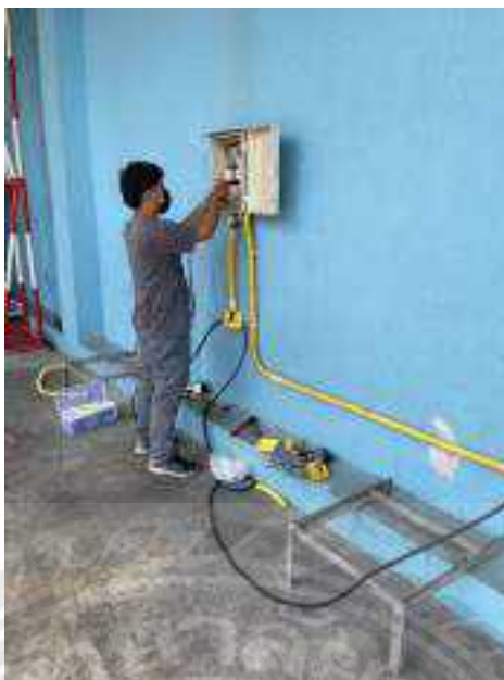
รูปที่ 2.10 เป็นการเข้าติดตั้งระบบไฟฟ้าสำหรับชาร์จรถยกชนิดรถไฟฟ้า
