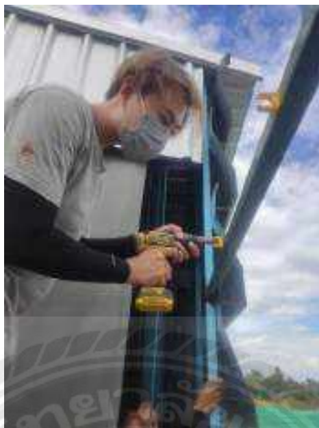
รูปที่ 2.14 เป็นการเข้าติดตั้งระบบไฟฟ้าสำหรับไฟส่องสว่างภายในโรงงาน
