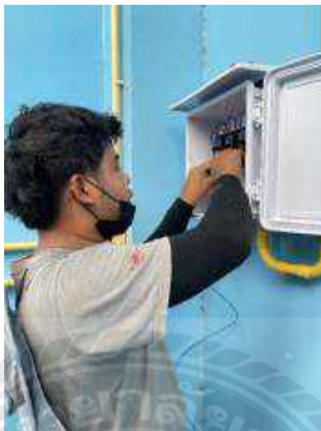
รูปที่ 2.20 เป็นการเข้าติดตั้งระบบไฟฟ้าสำหรับไฟส่องสว่างภายในโรงงาน
