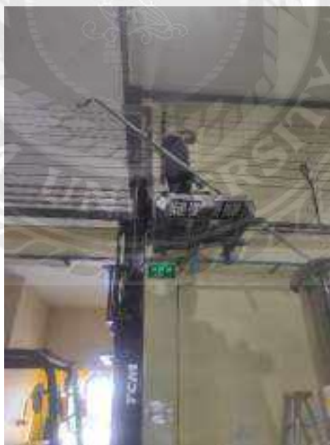
รูปที่ 2.6 เป็นการเข้าติดตั้งท่อส่งน้ำจิ้มไก่
