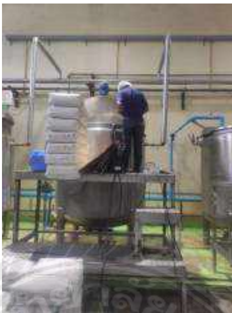
รูปที่ 2.1 เป็นการทำการตรวจสอบระบบต่างๆก่อนทำงาน
