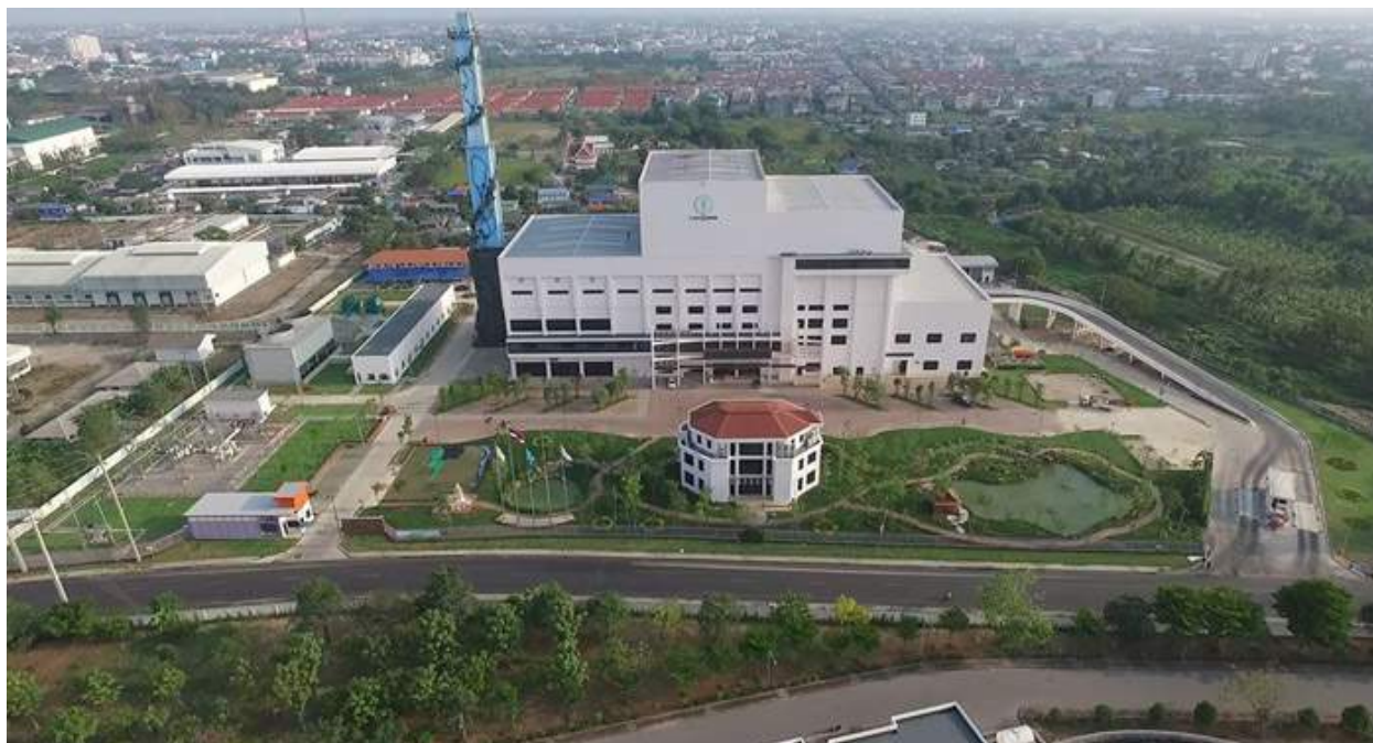
รูปที่ 2.24 โรงไฟฟ้าพลังงานขยะ
