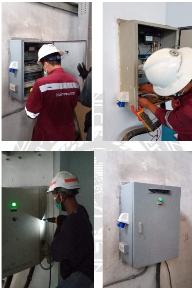
รูปที่ 4.2.13 ติดตั้ง Power Plug ที่ตู้ Control
