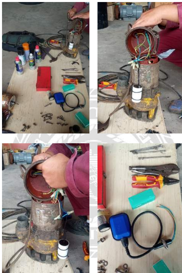
รูปที่ 4.2.14 เปลี่ยน Cap และลูกลอยปั้มน้ำ
