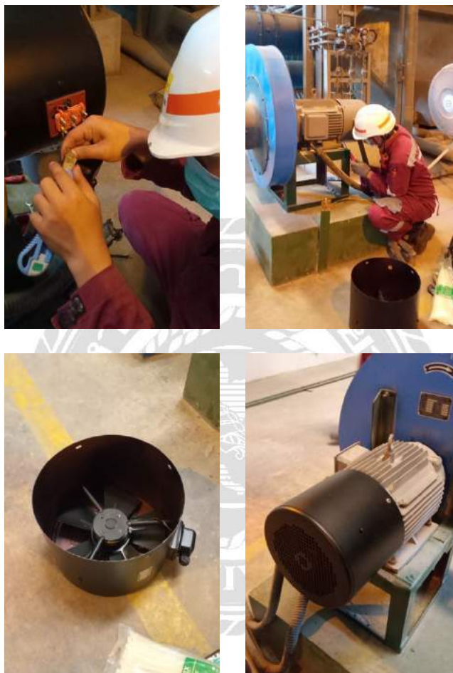
รูปที่ 4.2.5 เปลี่ยน SA Fan Boiler 2
