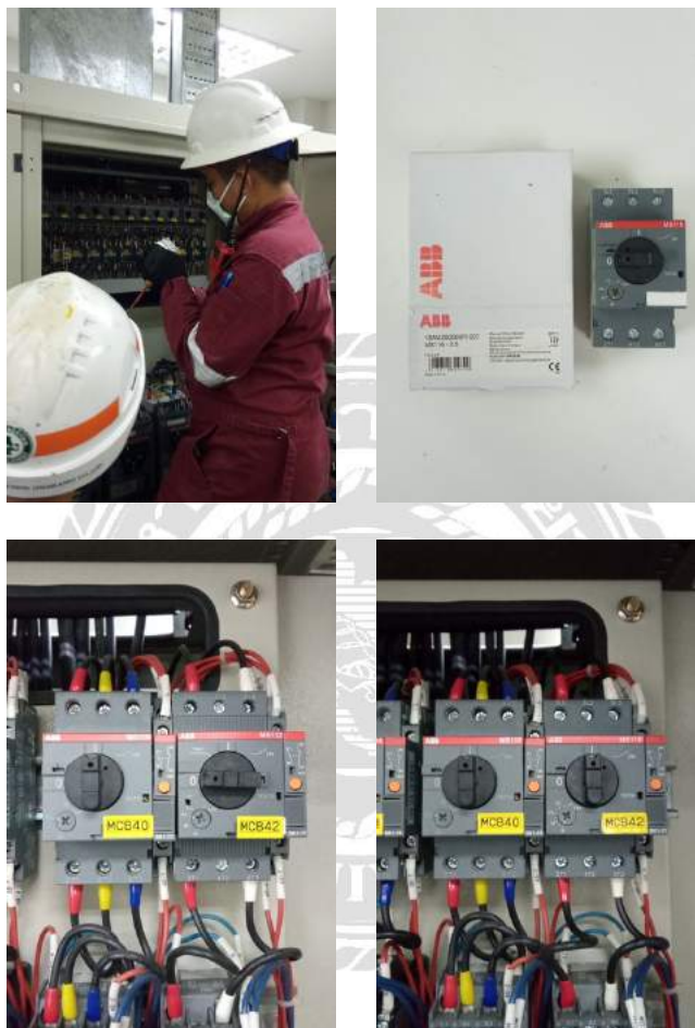
รูปที่ 4.2.11 เปลี่ยน Breaker Zone Waste Water
