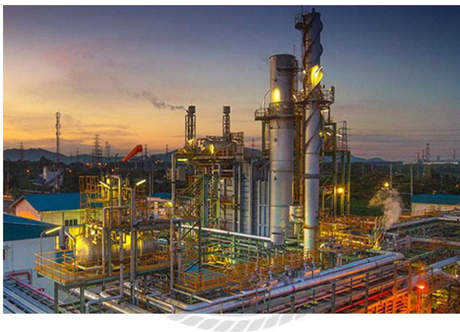
รูปที่ 2.19 โรงไฟฟ้าพลังงานความร้อน
