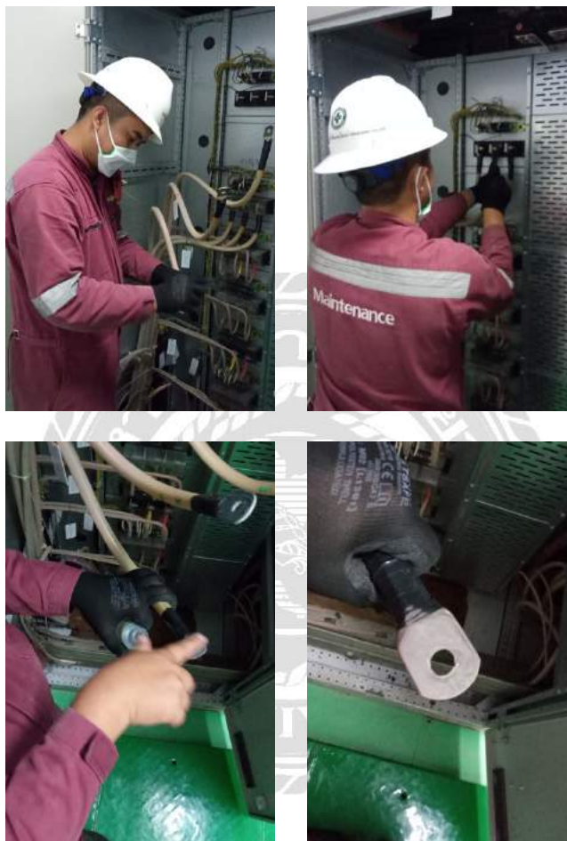
รูปที่ 4.2.12 เปลี่ยน Breaker Zone Waste Water
