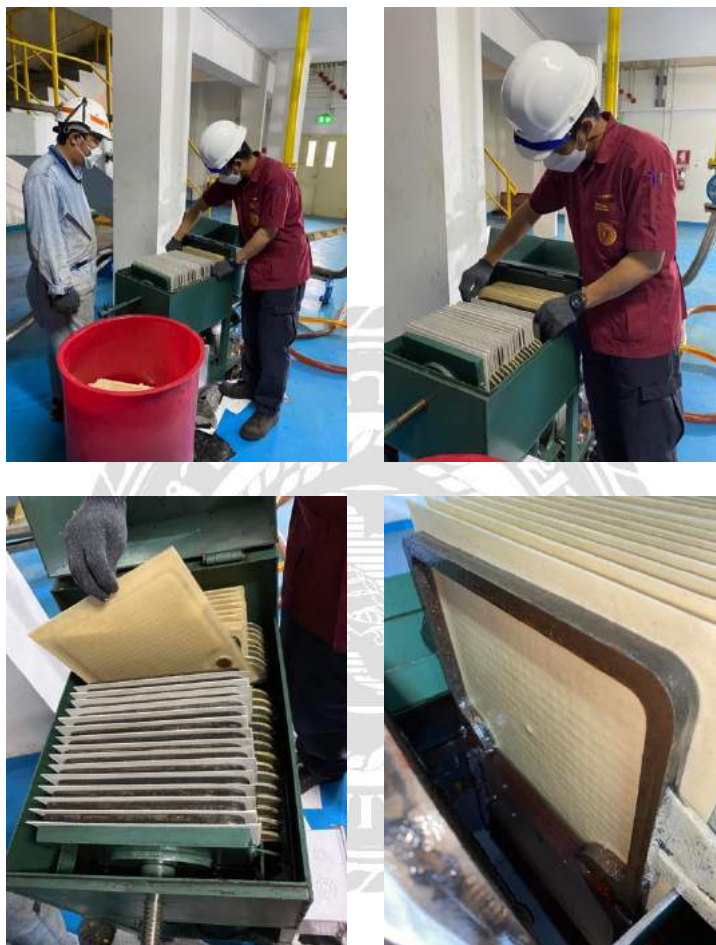
รูปที่ 4.1.18 PM Zone Turbine
