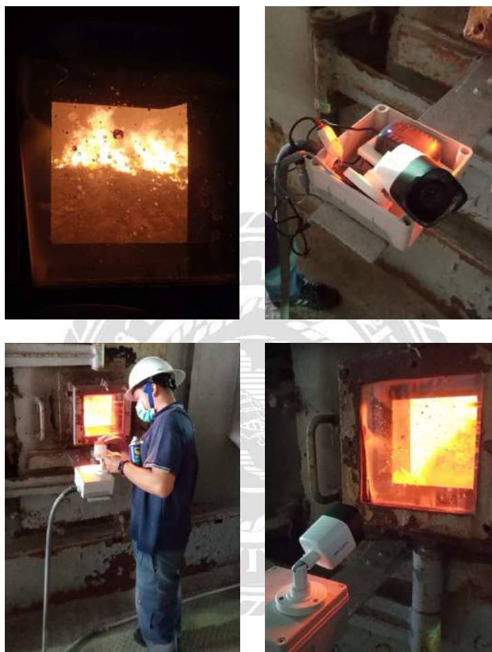
รูปที่ 4.2.3 เปลี่ยนกล้องส่องเตา Boiler 2
