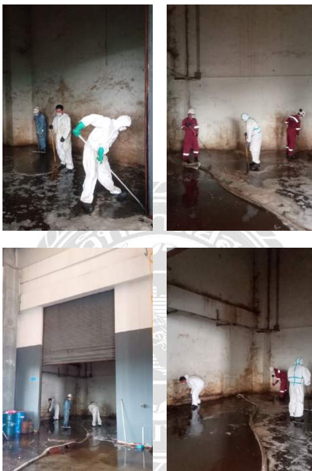
รูปที่ 4.2.15 ทำความสะอาดห้อง Service
