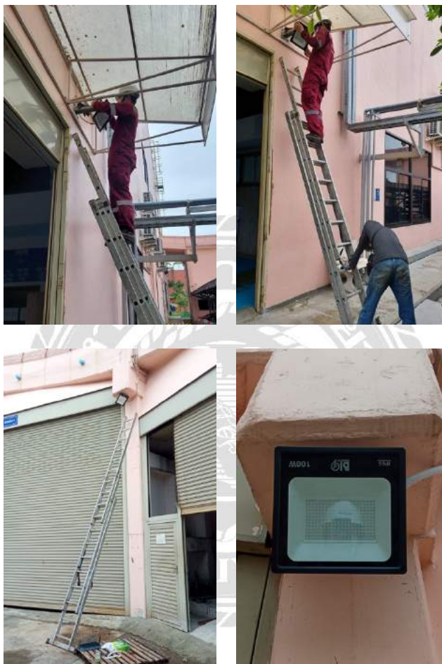
รูปที่ 4.2.7 ติดตั้ง เปลี่ยนโคมไฟ LED หน้าห้อง Maintenance และ Store
