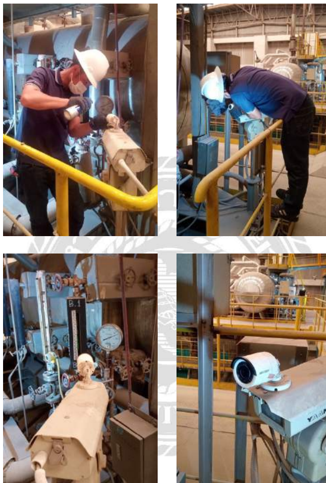
รูปที่ 4.2.9 เปลี่ยนกล้องส่อง Level Steam Drum
