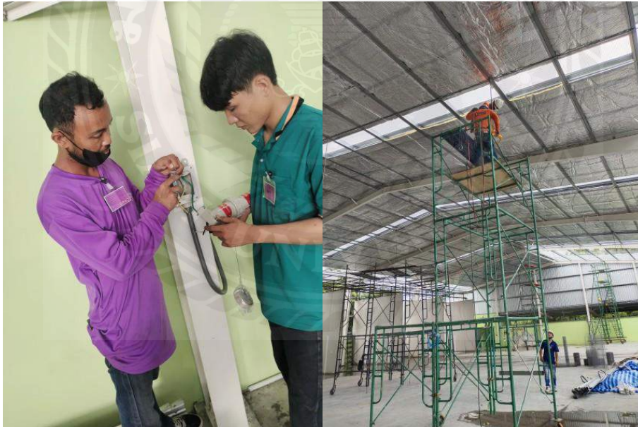
รูปที่ 4.8 ติดตั้ง Receptacle และ Lighting
