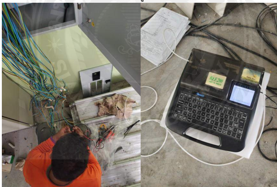
รูปที่ 4.10 การใช้คริปแอมป์เช็คสายและพิมพ์ลอกสายไฟ
