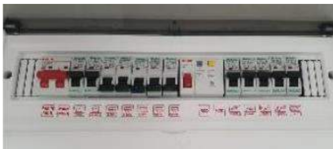
รูปที่ 2.45 คอนซูมเมอร์ยูนิต (Consumer Unit)
