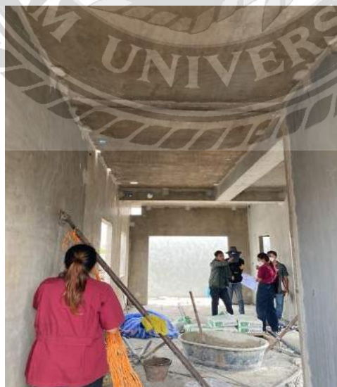
รูปที่ 4.4 ตรวจงานก่อนวางท่อ
