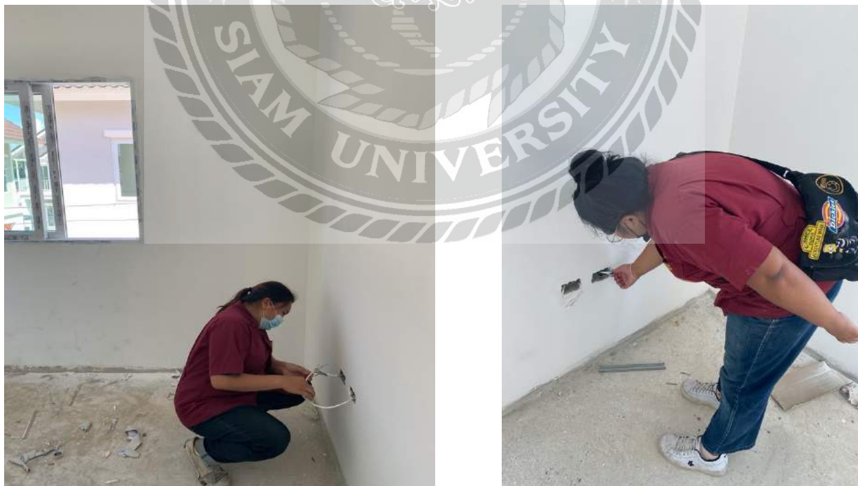
รูปที่ 4.9 ตรวจเช็คบล็อกไฟหลังจากลงแผ่น Precast
