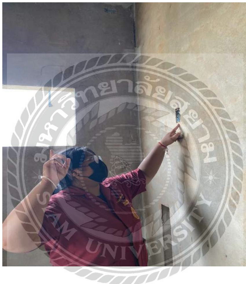
รูปที่ 4.10 การเช็คบล็อกเครื่องทำน้ำอุ่น
