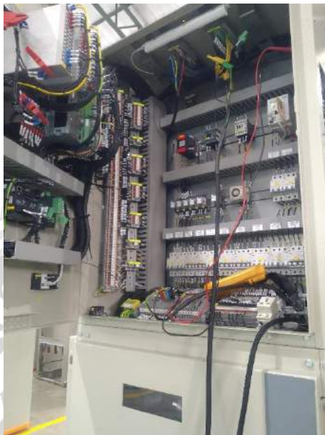
รูปที่ 4.2.2 การเช็ควงจรไฟฟ้าภายในตู้ไฟฟ้า
