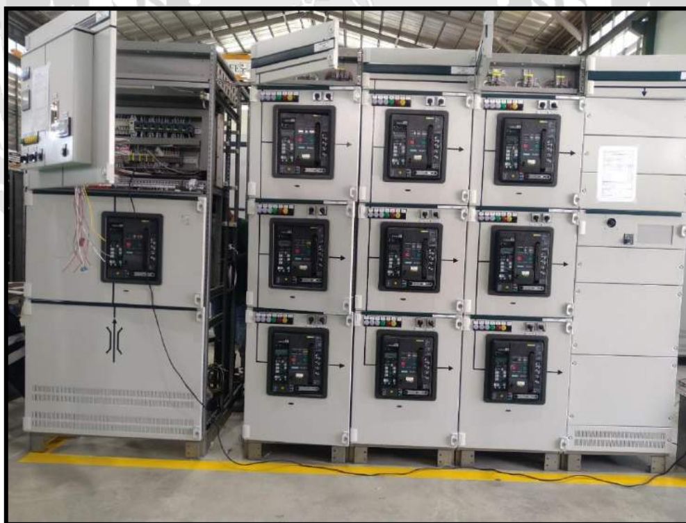
การทดสอบการใช้งาน ACB
