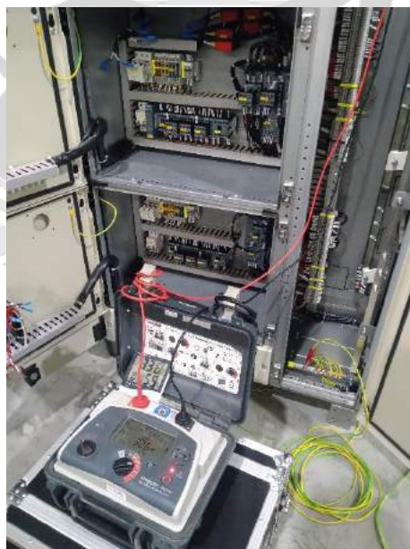
รูปที่ 4.2.3 ทำการวัดค่าความเป็นฉนวนทางไฟฟ้า
