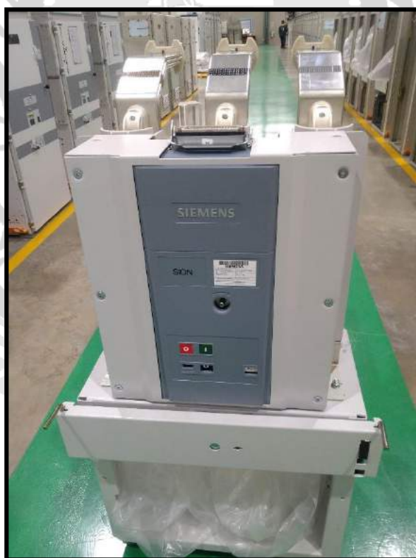
การตรวจเช็ค VCB
