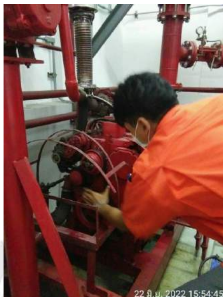
รูปที่ 4.2.4 ตรวจเช็คสภาพสายพานและตรวจเช็คน้ำกลั่นแบตเตอรี่
