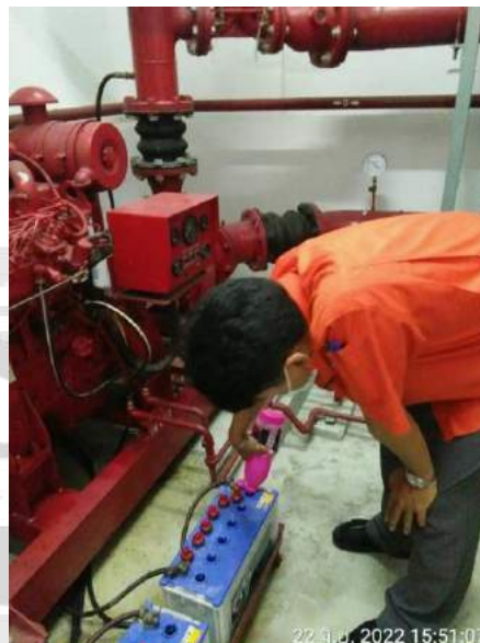
รูปที่ 4.2.4 ตรวจเช็คสภาพสายพานและตรวจเช็คน้ำกลั่นแบตเตอรี่
