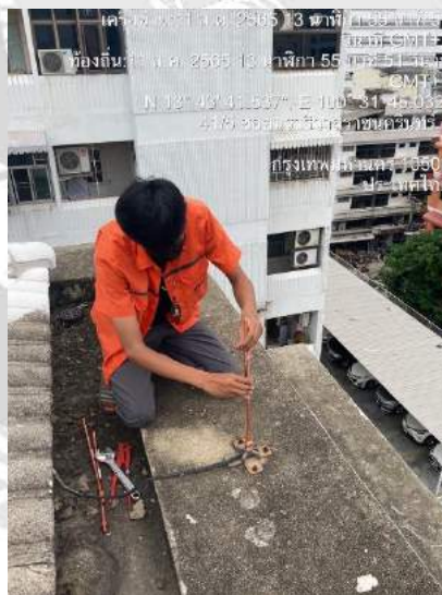
รูปที่ 2.7 รูปการณ์ติดตั้งเสาต่อฟ้าบนดาดฟ้าอาคารชุด
