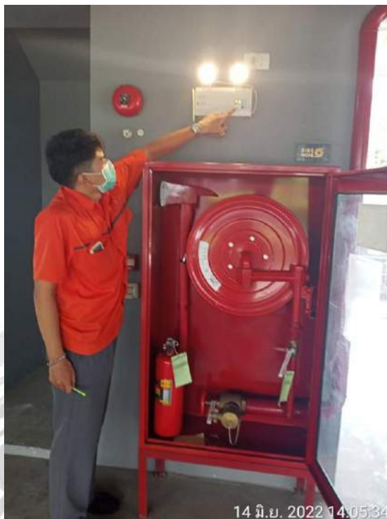
บำรุงรักษาเชิงป้องกันระบบไฟฉุกเฉินและตู้ดับเพลิง (ประจำเดือน)
