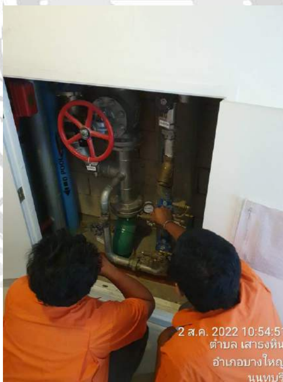
ตรวจเช็คระบบควบคุมแรงดัน (งานร้องขอจากโครงการอื่น)
