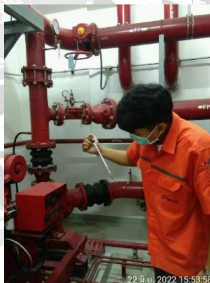
รูปที่ 4.2.3 ดำเนินการตรวจเช็คน้ำมันเครื่องของระบบปั้มน้ำดับเพลิง
