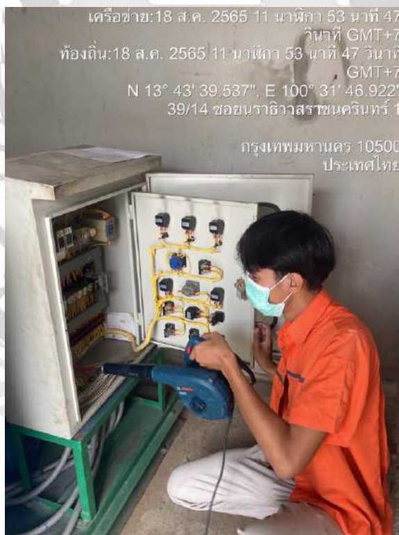
ทำความสะอาดภายในตู้คอนโทรล
