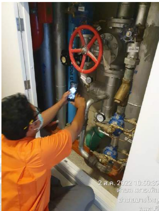
ตรวจเช็คระบบควบคุมแรงดัน (งานร้องขอจากโครงการอื่น)
