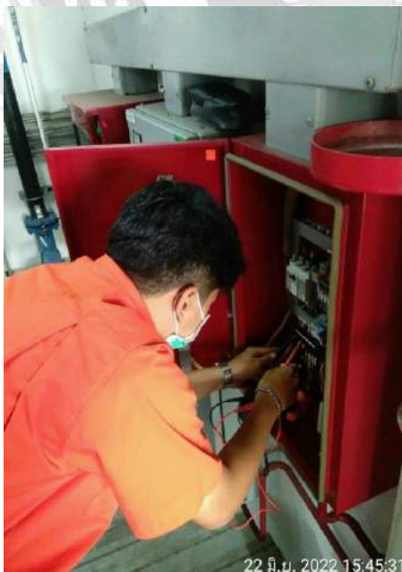
รูปที่ 4.2.5 วัดค่าความต้านทานและวัดกระแสไฟฟ้า
