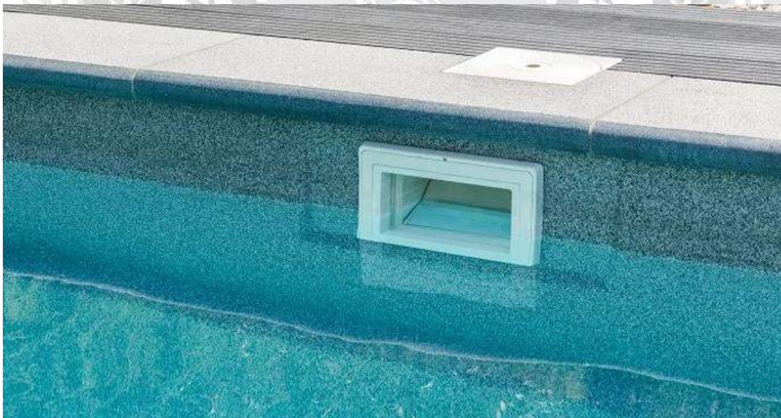
รูปที่ 2.9 รูปแสดงตัว Skimmer ที่ต้องติดตั้งที่ขอบผิวหน้าของสระระบบสกินเมอร์ เพื่อดูดเศษผงที่ผิวหน้าของน้ำในสระว่ายน้ำ
