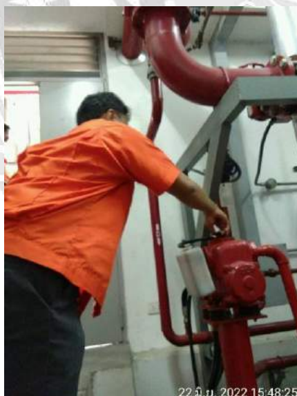
รูปที่ 4.2.3 ดำเนินการตรวจเช็คน้ำมันเครื่องของระบบปั้มน้ำดับเพลิง
