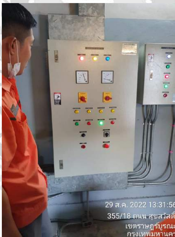
ทดสอบการทำงานของระบบปั้มน้ำดี
