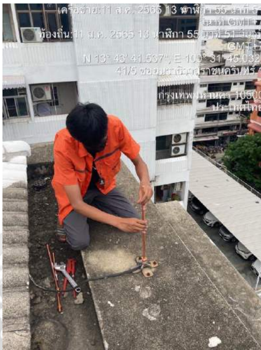
บำรุงรักษาเชิงป้องกันระบบป้องกันฟ้าผ่า (ประจำปี)
