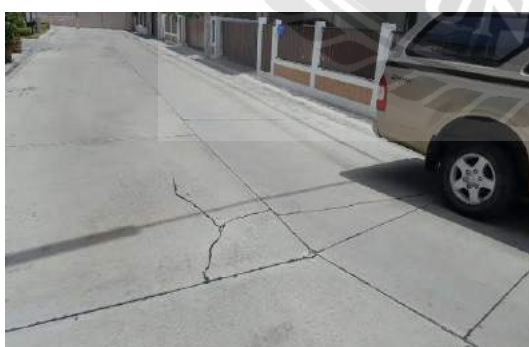
(ค) รอยแตกร้าวของงานเทคอนกรีตที่ไม่ได้มาตรฐาน
