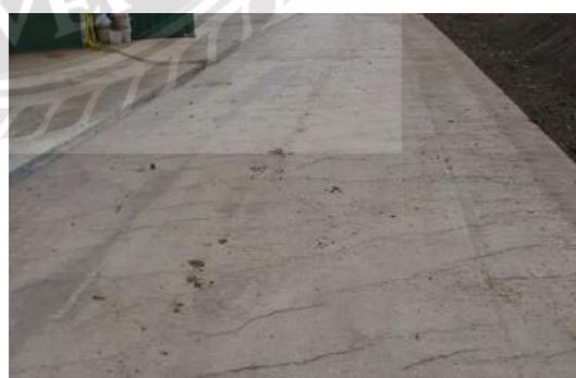
(ง) รอยแตกร้าวเป็นลายงาของงานคอนกรีตที่ไม่ได้มาตรฐาน
