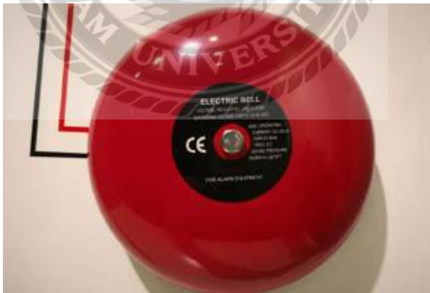
รูปที่ 4.7 เช็คตู้แจ้งเตือนแบบเสียง
