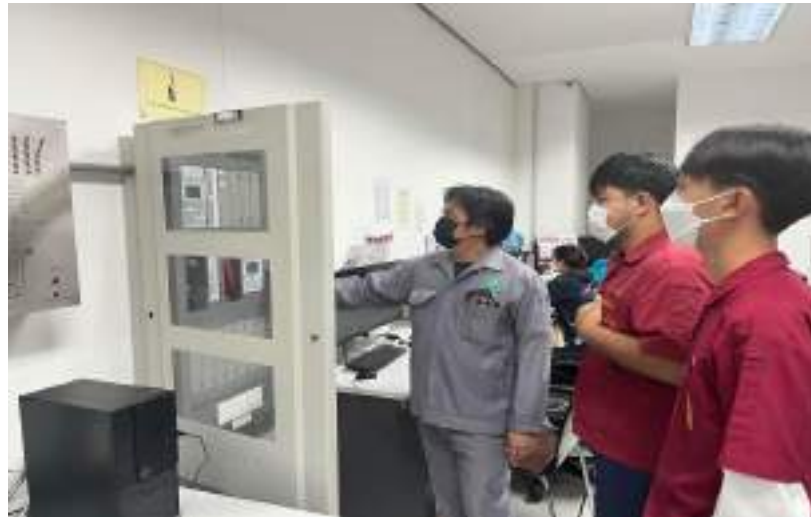
รูปที่ 4.3 ตรวจสอบเช็คตู้ให้พร้อมใช้งาน
