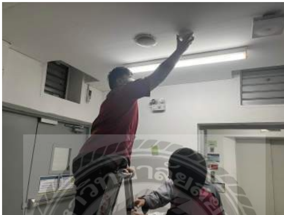
รูปที่5 ตรวจสอบSmoke Detector
