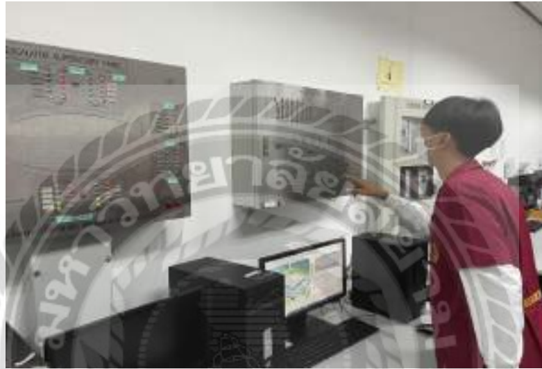
รูปที่ 4.2 เซ็คตู้แสดงสถานะแจ้งเหตุเพลิงไหม้
