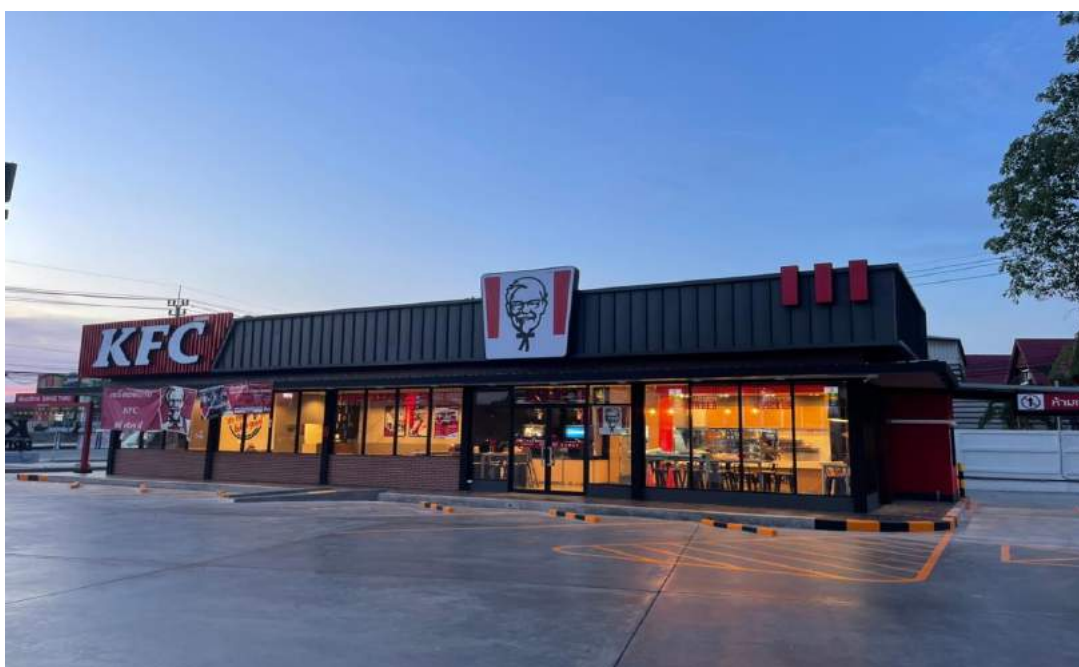
รูปที่ 4.12 รูปอาคารที่ก่อสร้างเสร็จ
