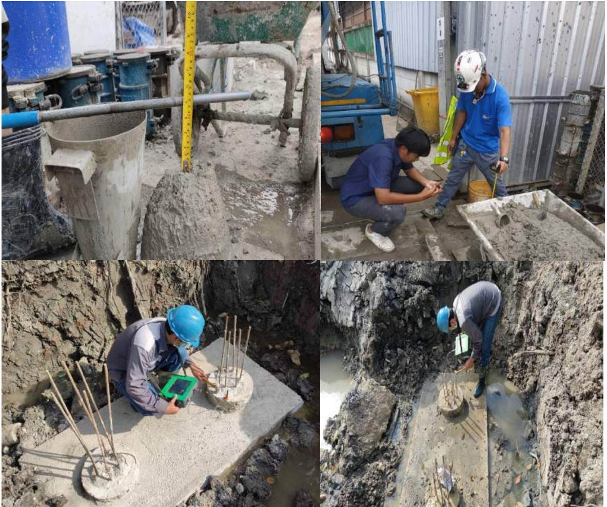
รูปที่ 4.6 การตรวจสอบควบคุมคุณภาพของคอนกรีต
