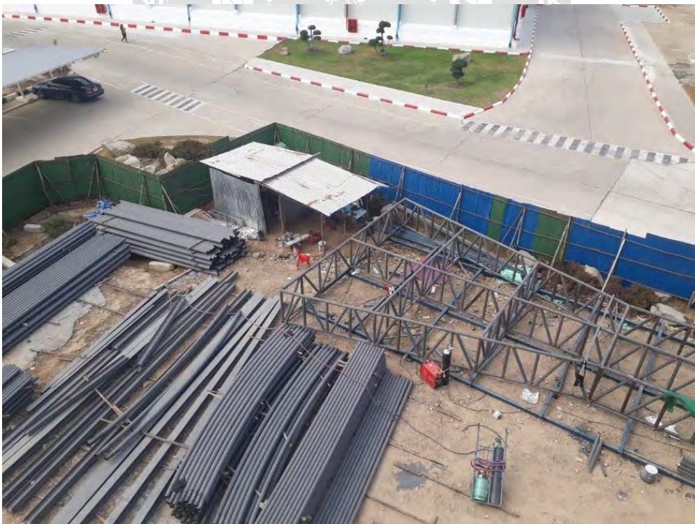
รูปที่ 4.49 งานประกอบโครงรับหลังคา
