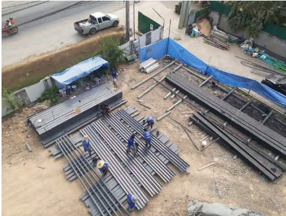
รูปที่ 4.48 การเตรียมวัสดุและทาสีกันสนิม ก่อนนำมาประกอบ
