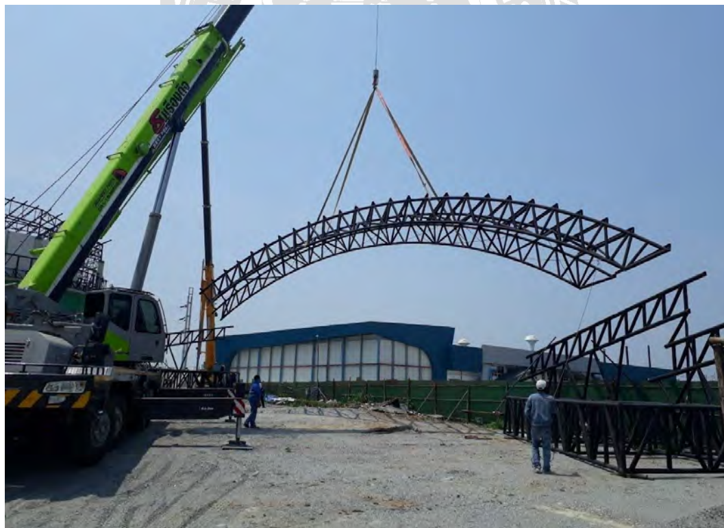
รูปที่ 4.57 การยกชิ้นงาน T-1 เพื่อติดตั้ง
