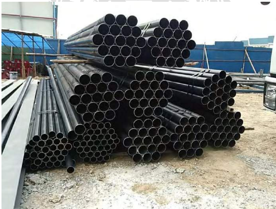
รูปที่ 4.26 การวางวัสดุเพื่อประกอบ
