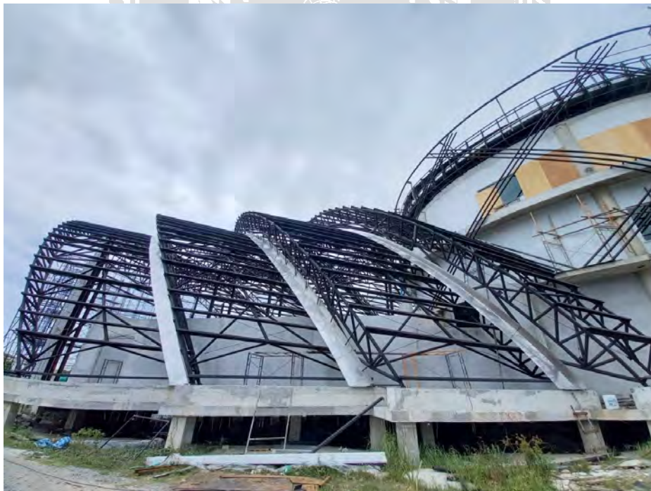
รูปที่ 4.61 ติดตั้งโครงสร้างเหล็กแล้วเสร็จ
