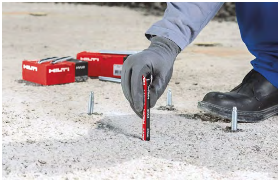
รูปที่ 4.66 ภาพการติดตั้ง Anchor rod แบบเคมี
