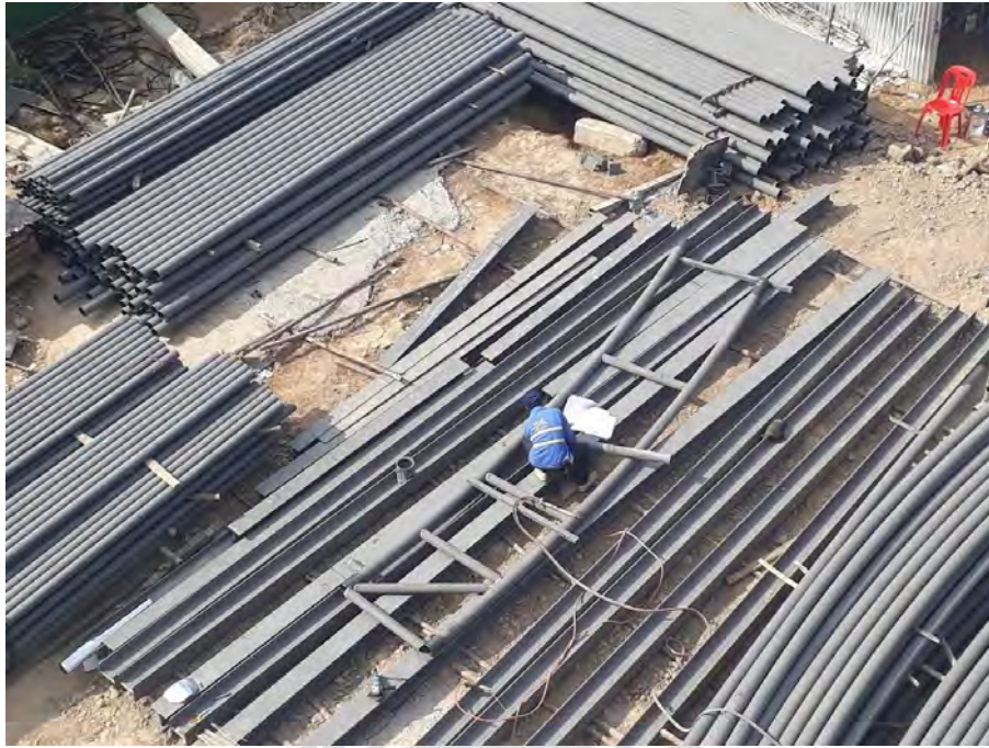
รูปที่ 4.25 การวางวัสดุเพื่อประกอบ
