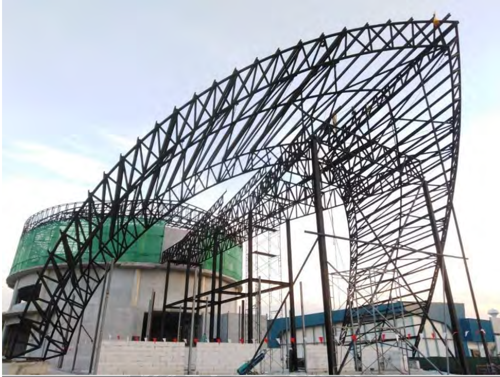
รูปที่ 4.58 ติดตั้งโครงสร้างเหล็ก
