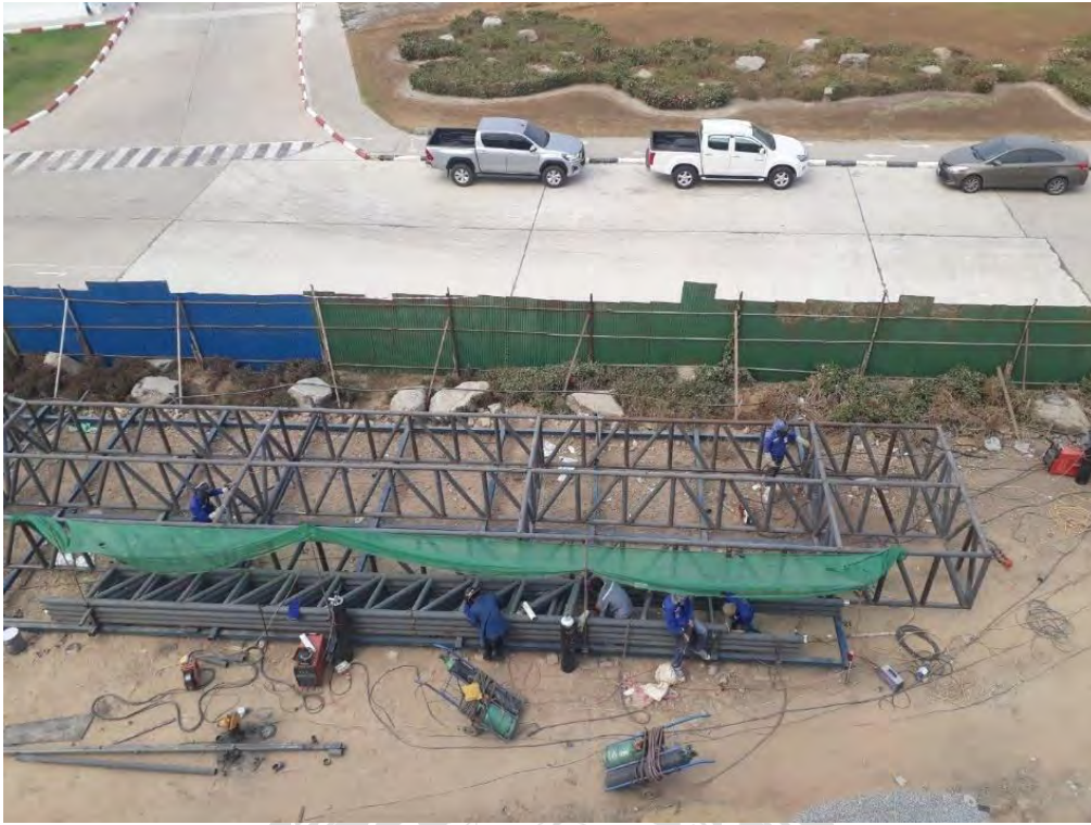
รูปที่ 4.50 งานประกอบโครงรับหลังคา
