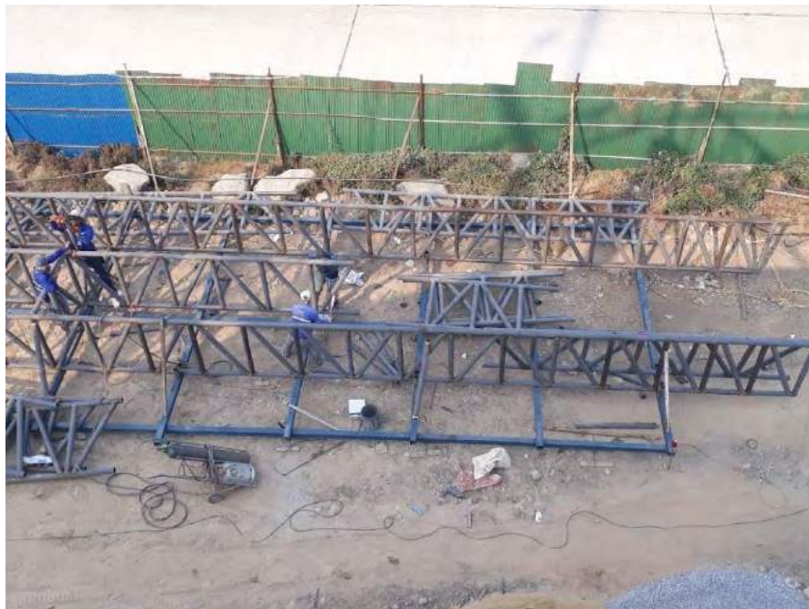
รูปที่ 4.69 ภาพแสดงการทำโครงเหล็กเพื่อทำการประกอบชิ้นส่วนหลังคา
