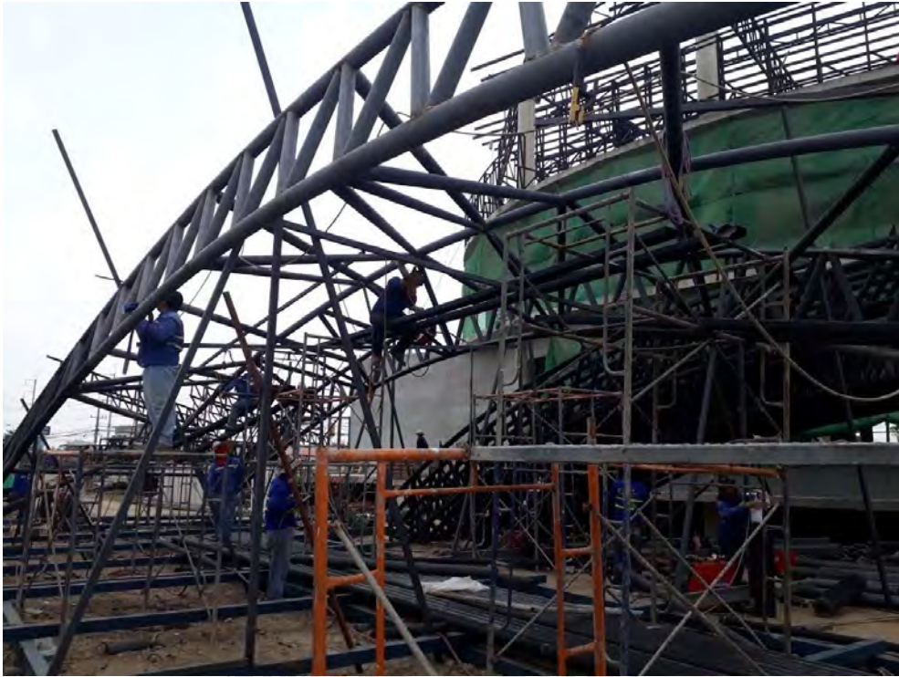
รูปที่ 4.54 ประกอบชิ้นงานโครงสร้างหลังคา T-1
