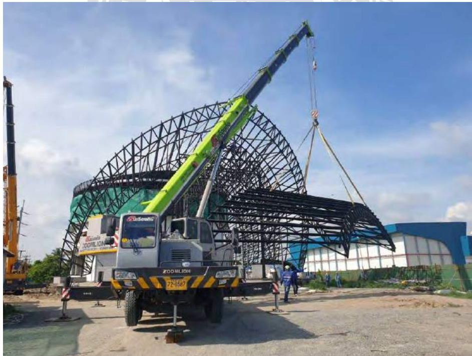
รูปที่ 4.59 ติดตั้งโครงสร้างเหล็ก
