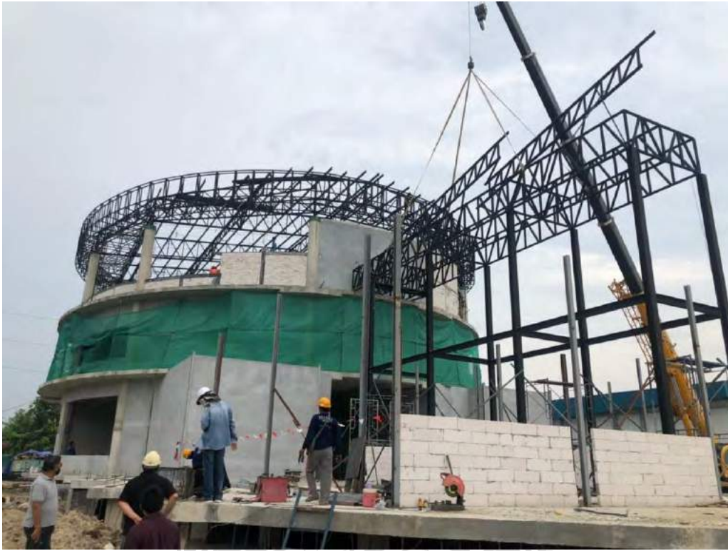
รูปที่ 4.52 ติดตั้งโครงสร้างเหล็กรับหลังคา
