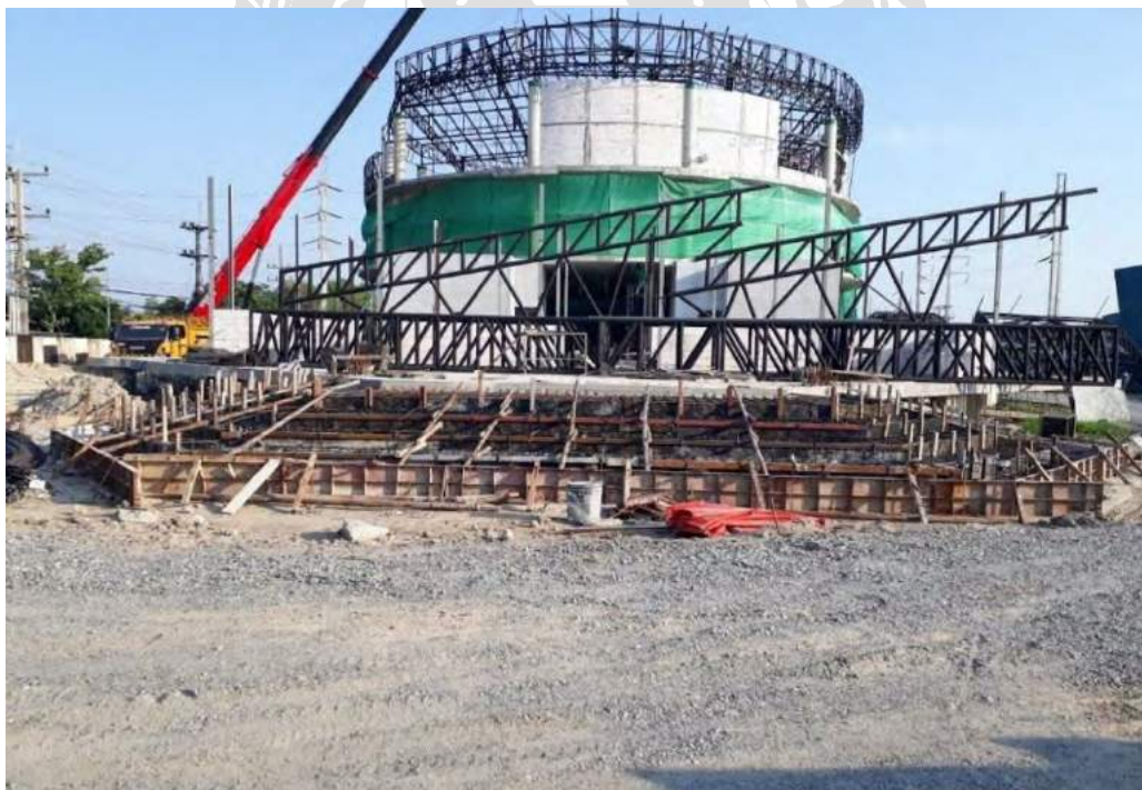
รูปที่ 4.51 การยกโครงสร้างรับหลังคาเพื่อติดตั้ง
