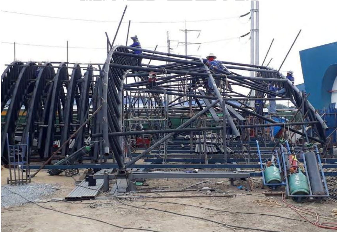
รูปที่ 4.55 ประกอบชิ้นงานโครงสร้างหลังคา T-1B
