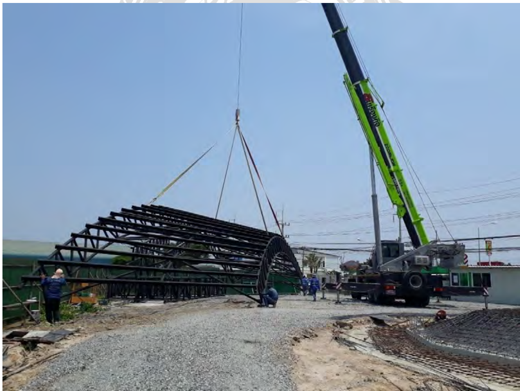
รูปที่ 4.29 การยกชิ้นงานและพักชิ้นงานก่อนการติดตั้ง
