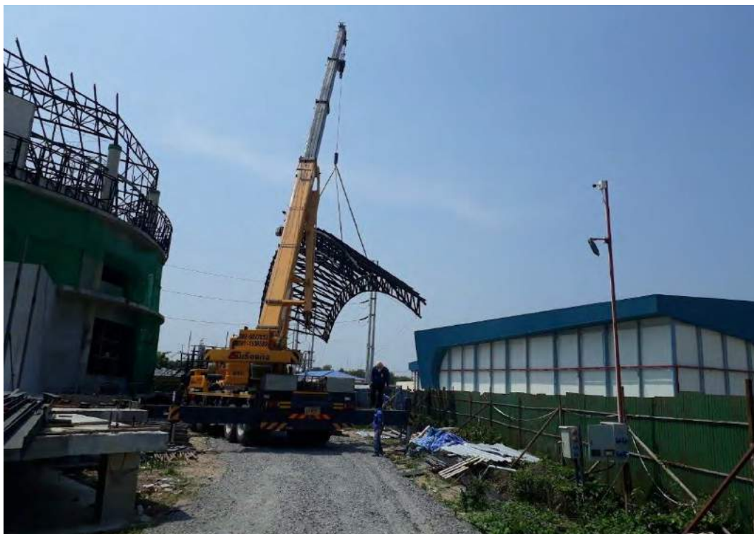
รูปที่ 4.56 การยกชิ้นงาน T-1 เพื่อติดตั้ง
