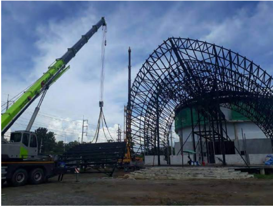
รูปที่ 4.60 ติดตั้งโครงสร้างเหล็ก
