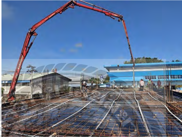
รูปที่ 4.6 ภาพประกอบการเทพื้นคอนกรีต
