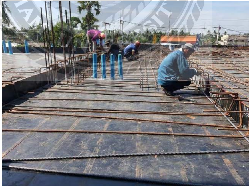
รูปที่ 4.3 รูปภาพประกอบการติดตั้งเหล็กเสริมล่าง
