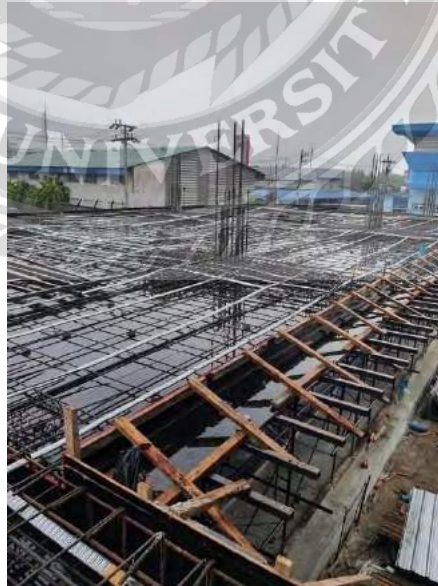
รูปที่ 4.5 รูปภาพประกอบการวางเหล็กเสริมบน
