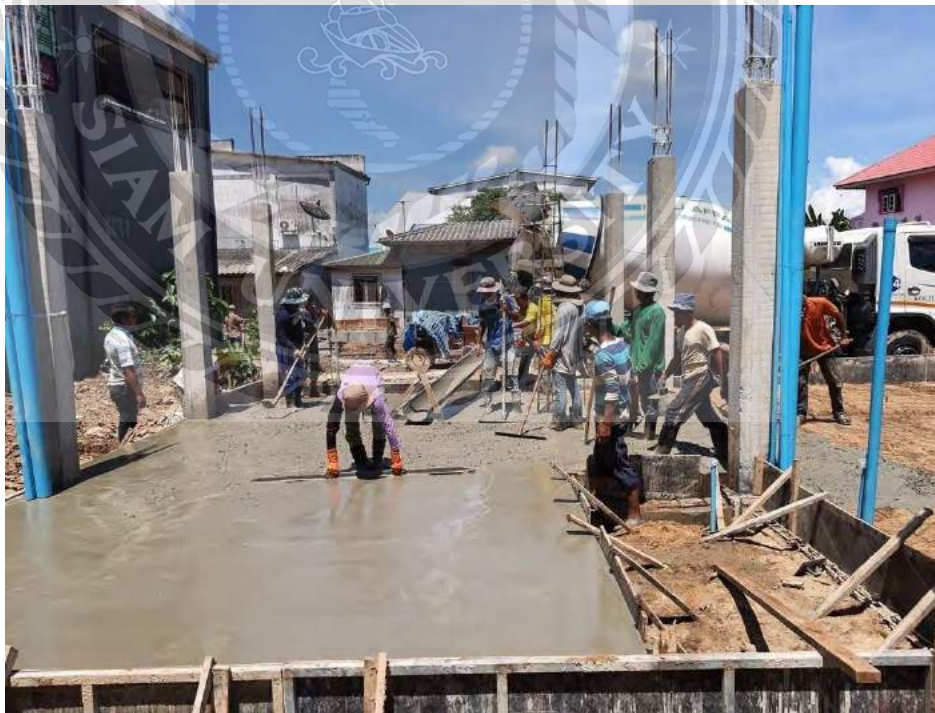
รูปที่ 4.9 ภาพประกอบการเทพื้นคอนกรีต
