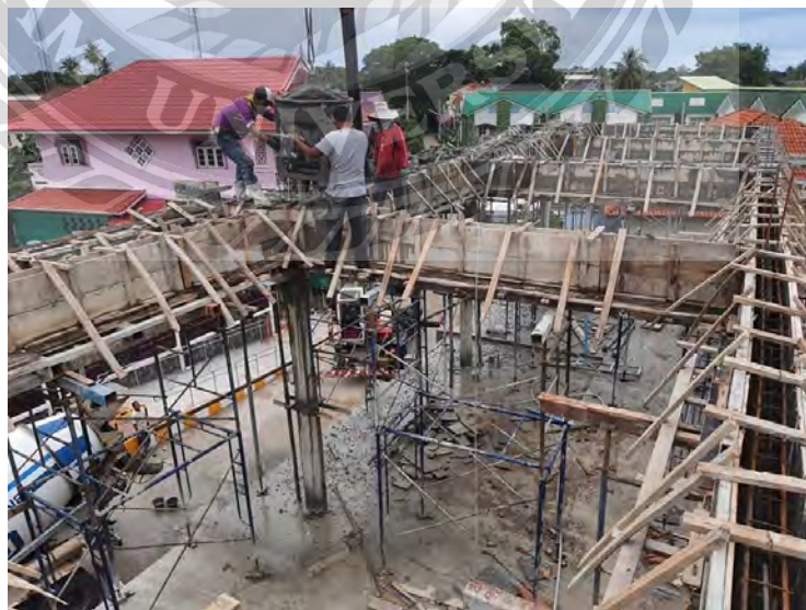
รูปที่ 4.12 ภาพประกอบการเทคานคอนกรีต
