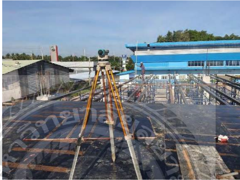
รูปที่ 4.2 รูปภาพประกอบการติดตั้งนั่งร้าน พร้อมวางแบบพื้นและแบบข้าง
