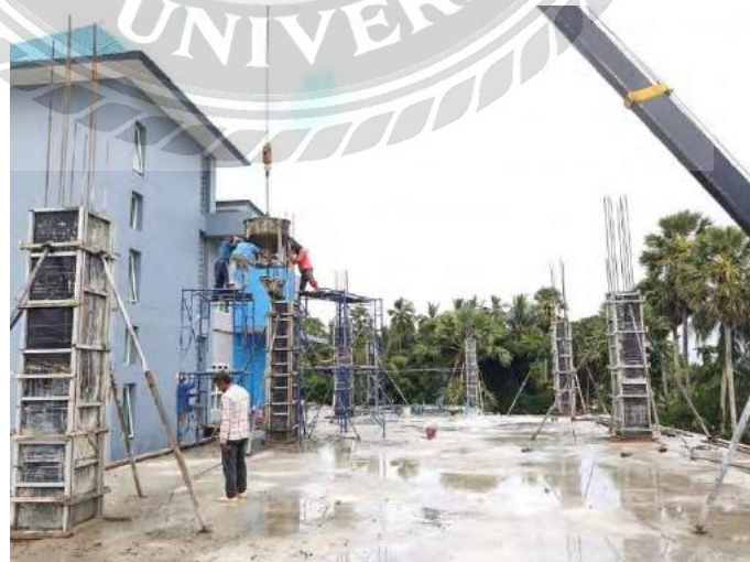
รูปที่ 4.1 รูปภาพประกอบการเทเสา
