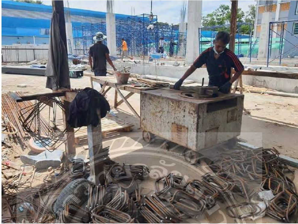
รูปภาพการตัดและตัดเหล็ก
