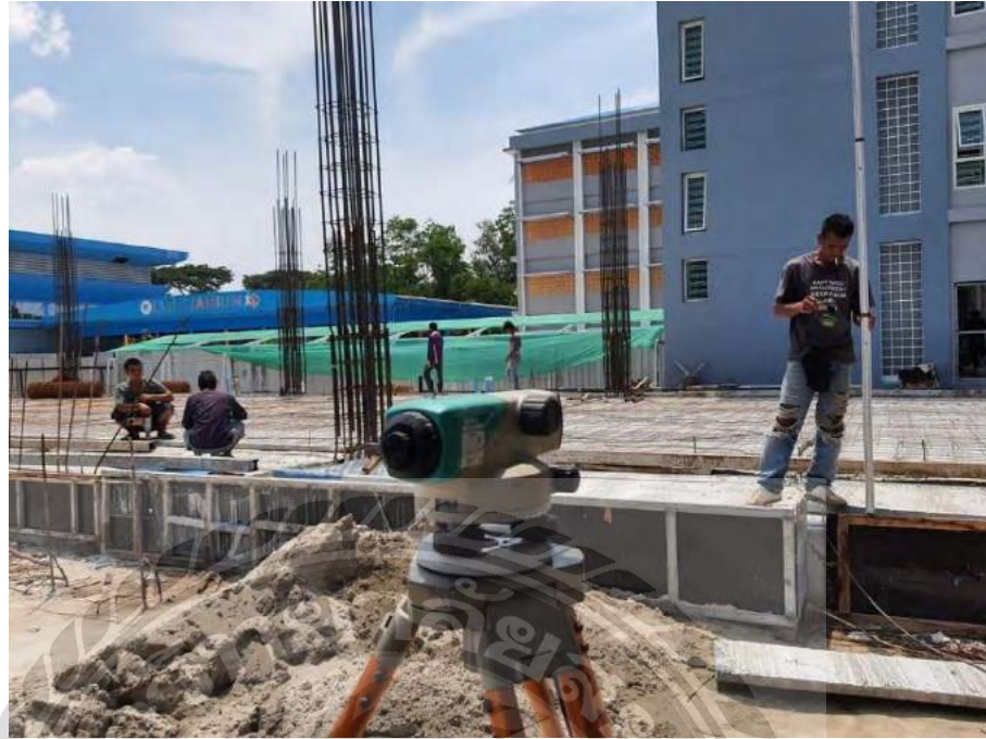
รูปที่ 4.8 ภาพประกอบก่อนการเทพื้นคอนกรีต
