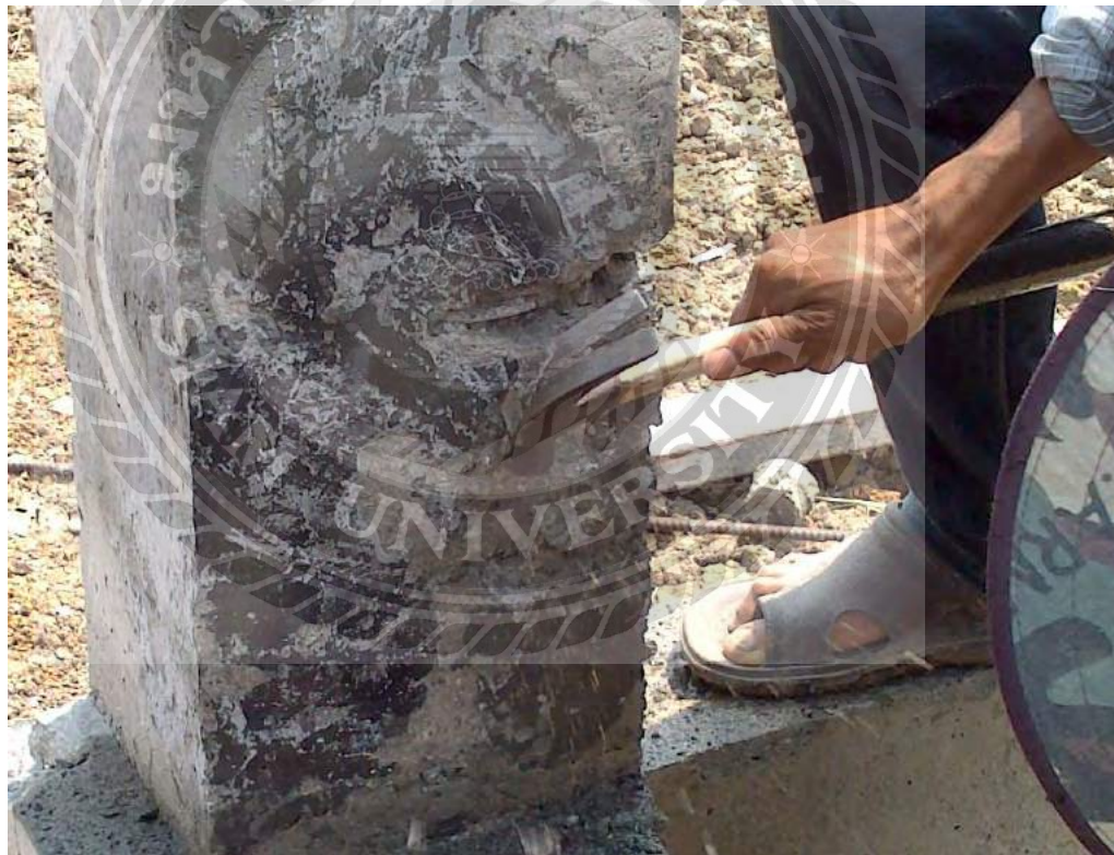
รูปที่ 4.13 ภาพประกอบปัญหาที่พบในการเทคอนกรีต
