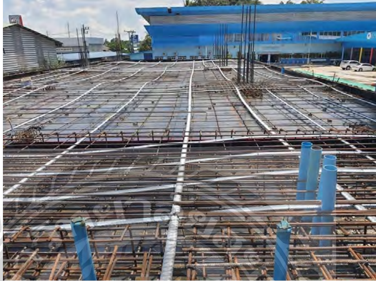
รูปที่ 4.4 รูปภาพประกอบการติดตั้งลวดอัดแรง
