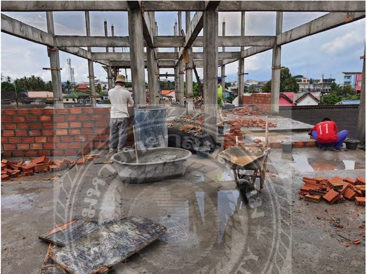
รูปที่ 2.6 รูปภาพประกอบการก่ออิฐมวลฉนวน
