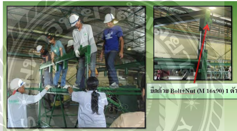
รูปที่ 3.48 ขั้นตอนที่ 5 ติดตั้ง TF-Beam 300 เข้ากับตัว TF-Inner
