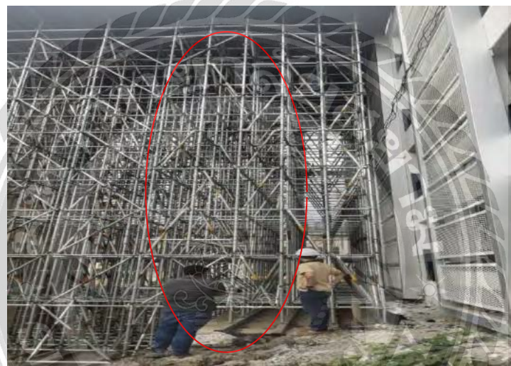
รูปที่4.22 จุดที่ต้องแก้ไขการรับน้ำหนักCross Beam 420ตัน
