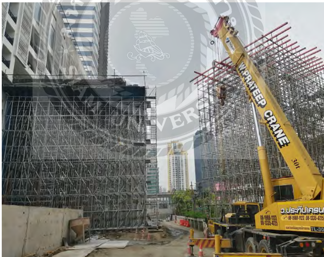
รูปที่ 4.12 Ring Lock รั้ว Cross Beam
