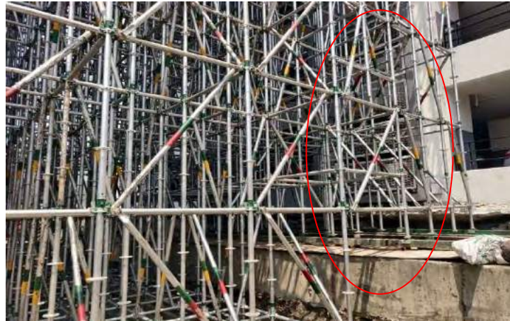
รูปที่4.21 จุดที่ต้องแก้ไขการรับน้ำหนักCross Beam 420ตัน
