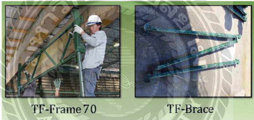
รูปที่ 3.42 ชั้นส่วน Table Form, TF-Frame70 , TF-Brace
