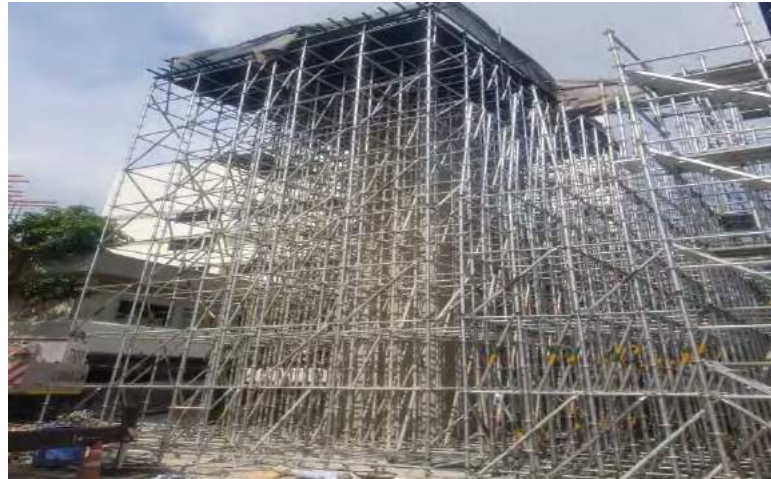
รูปที่ 4.13 Ring Lock รั้ง Cross Beam
