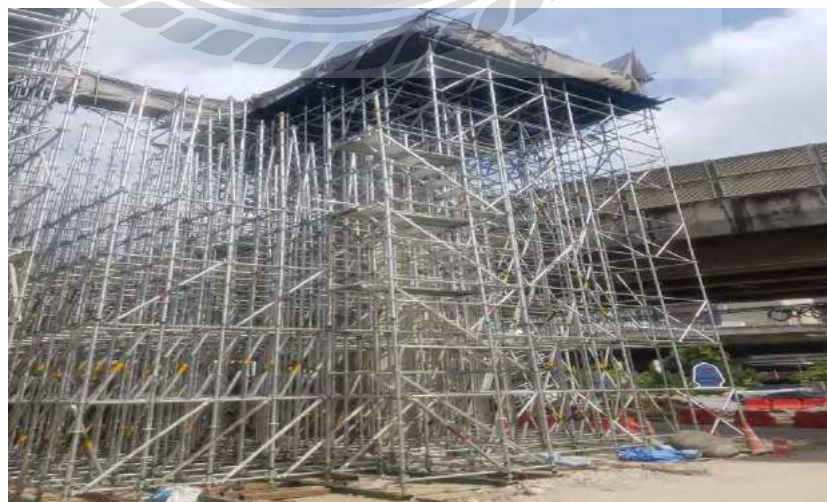
รูปที่ 4.15 Ring Lock รั้ง Cross Bea
