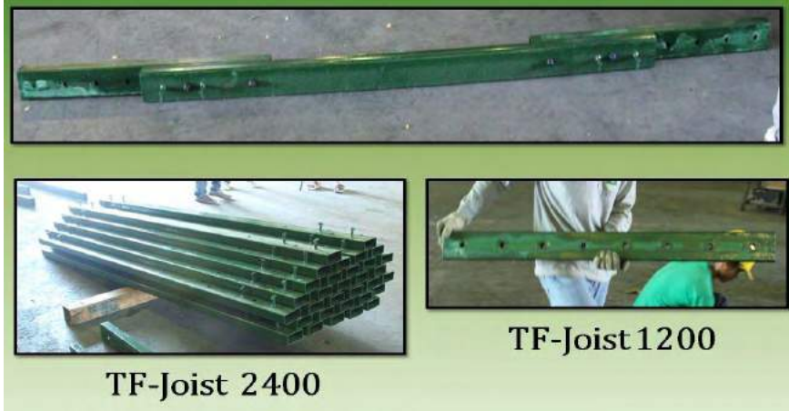
รูปที่ 3.43.1 ชิ้นส่วนTable Form, TF-Joist2400 , TF-Joist1200
