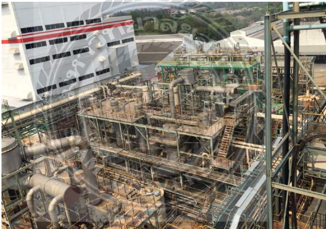
รูปที่ 4.2 ภาพอาคารที่จะทำการรื้อถอน
