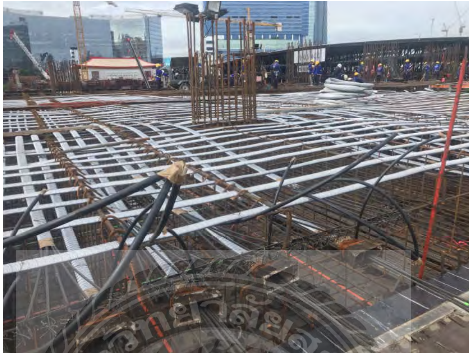
รูปแสดงการติดตั้งลวดอัดแรง
