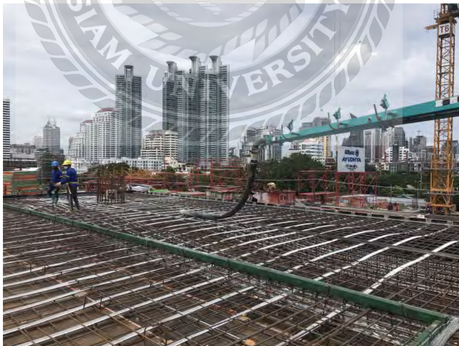
รูปแสดงการเทคอนกรีต
