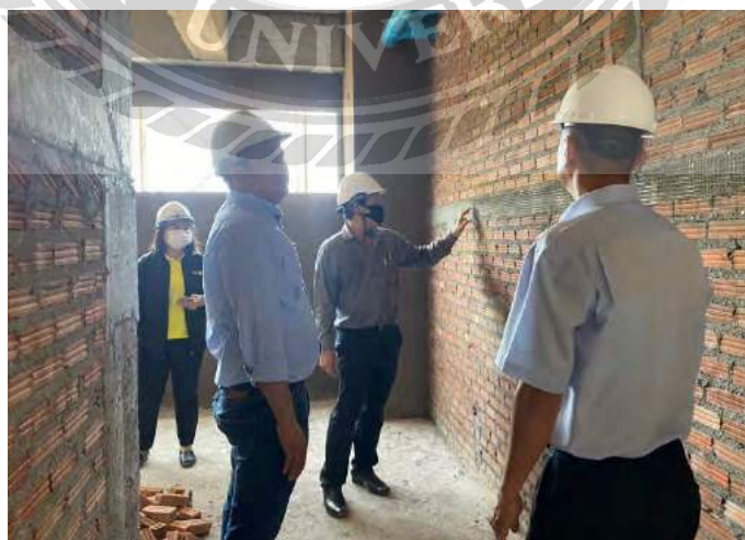
รูปที่ 4.9 งานก่อผนัง
