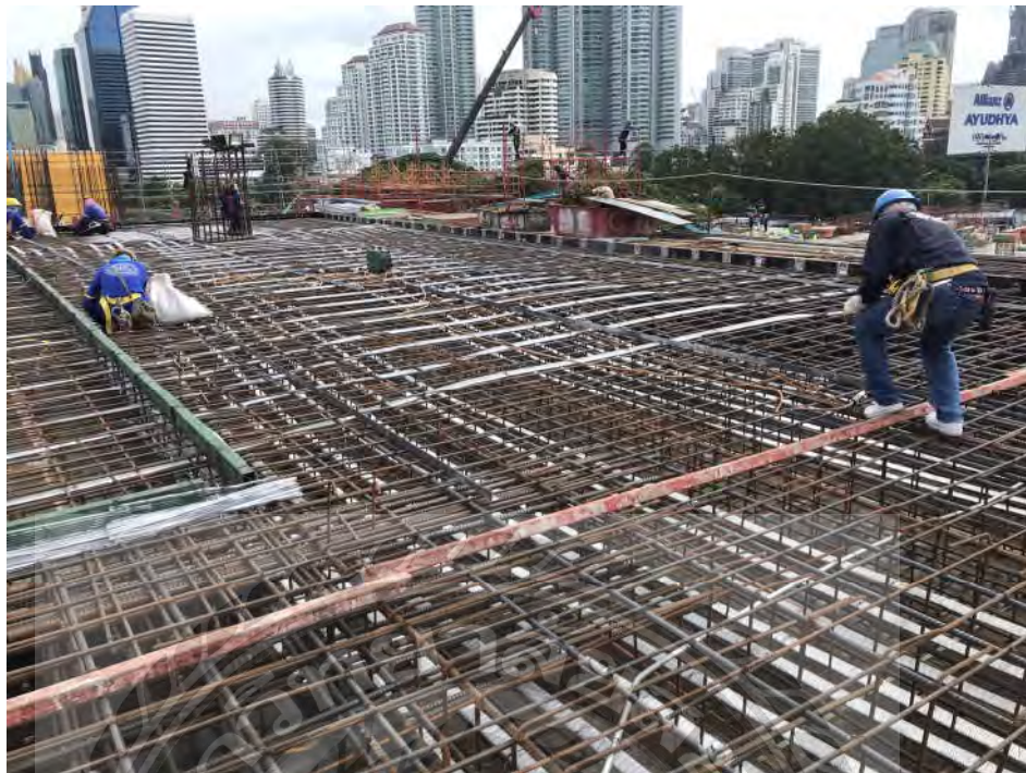
รูปแสดงการวางสารแรงอัดชั้น 2
