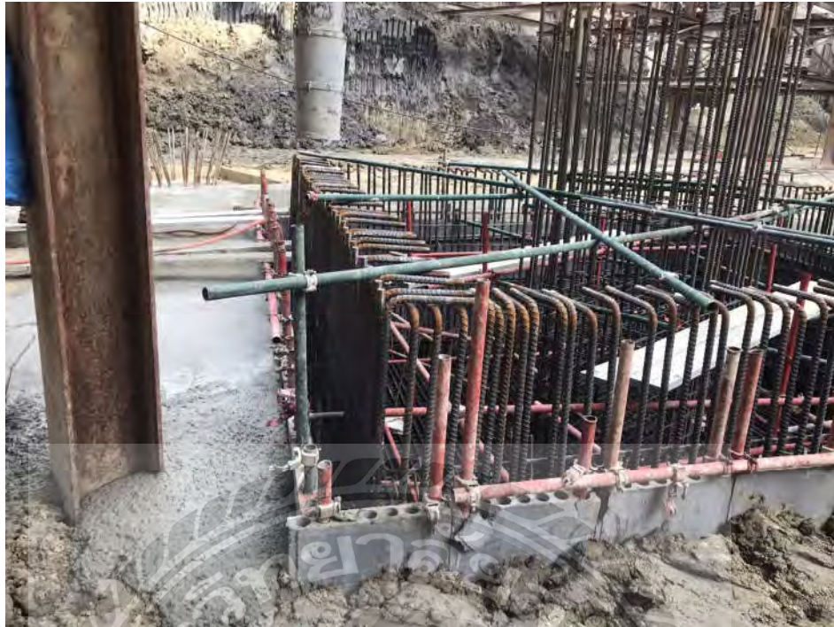
รูปแสดงการเข้าแบบเสาเข็มเตรียมเทคอนกรีต
