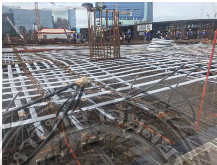
รูปที่ 4.2 การติดตั้งลวดอัดแรง
