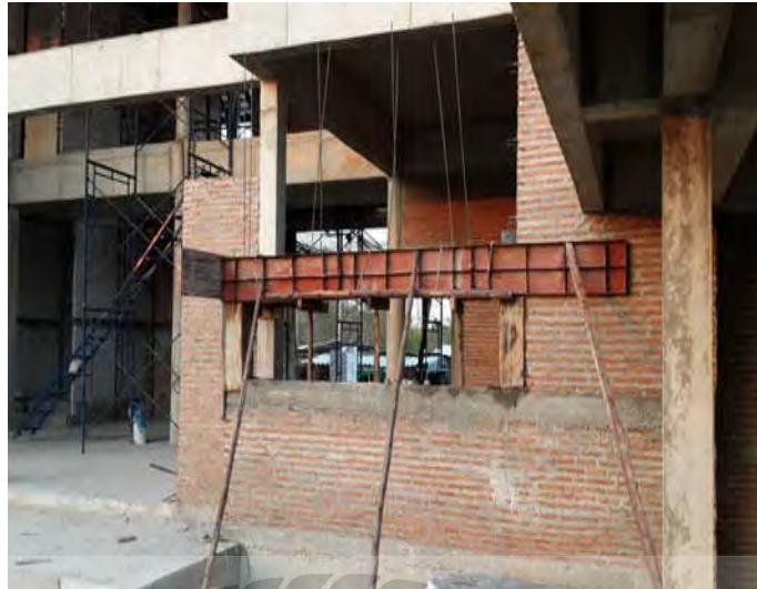
รูปที่ 4.11 งานติดตั้งวงกบ
