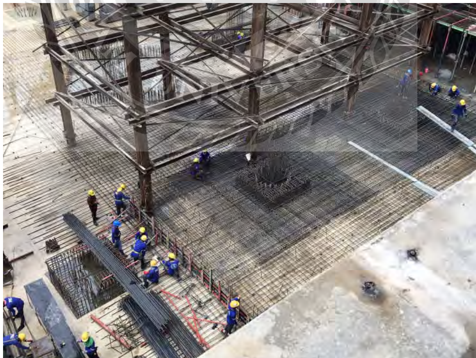
รูปแสดงภาพมุมสูงของการวางเหล็กเสา
