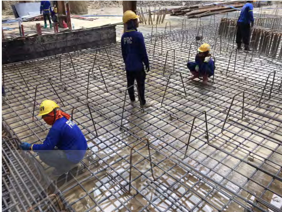
รูปแสดงการวางเหล็กพื้น
