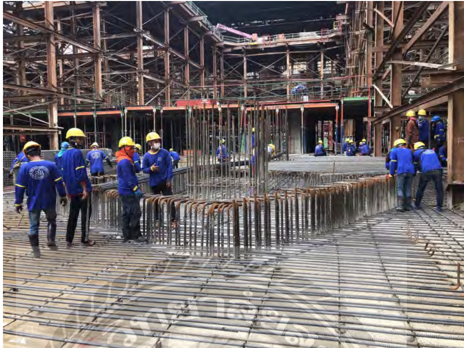
รูปแสดงการวางเหล็กเสา
