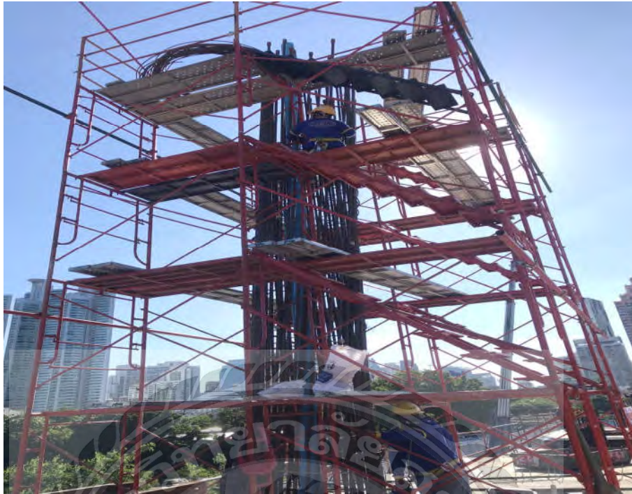
รูปแสดงการเช็คความเรียบร้อยก่อนใส่แบบเสาทรงกลม
