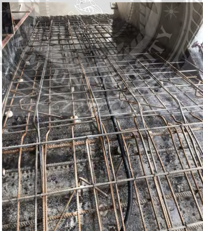
รูปแสดงการวางเหล็กกันไต
