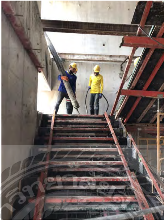
รูปที่ 4.7 งานเข้าแบบเสริมเหล็กบันได
