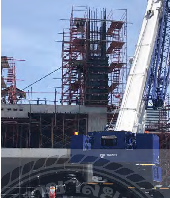
รูปที่ 4.6 งานเสาตอมคอนกรีต
