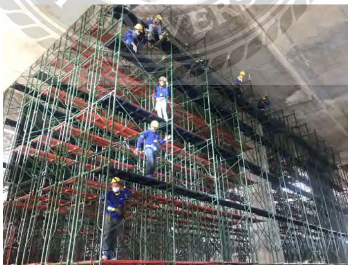
รูปที่ 4.1 การติดตั้งนั่งร้าน
