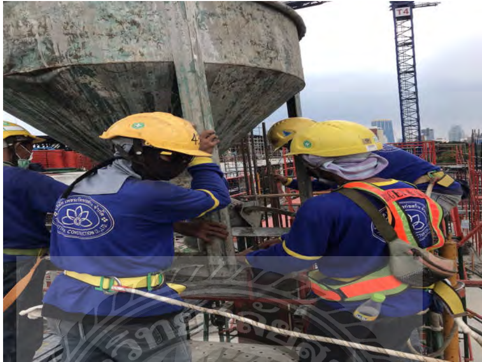
รูปการณ์เทคอนกรีตเสา
