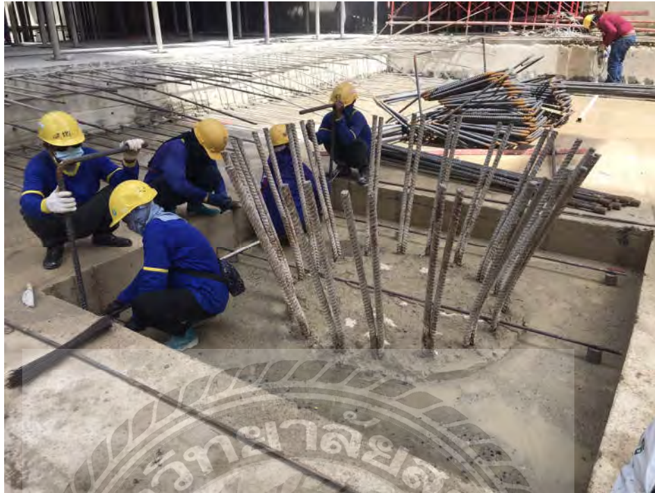
รูปแสดงโครงเหล็กของเสา
