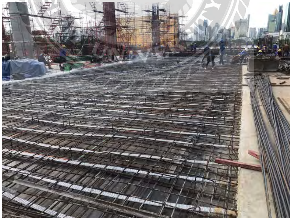
รูปแสดงการติดตั้งลวดอัดแรงเสร็จเรียบร้อย
