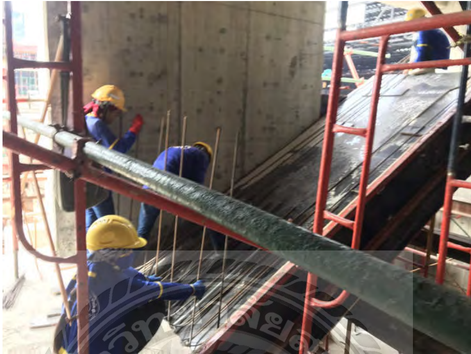
รูปแสดงการวางเหล็กกันไต
