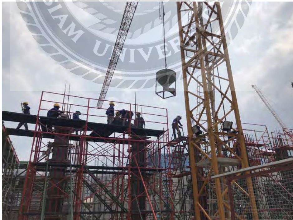
รูปแสดงการเทคอนกรีตเสา
