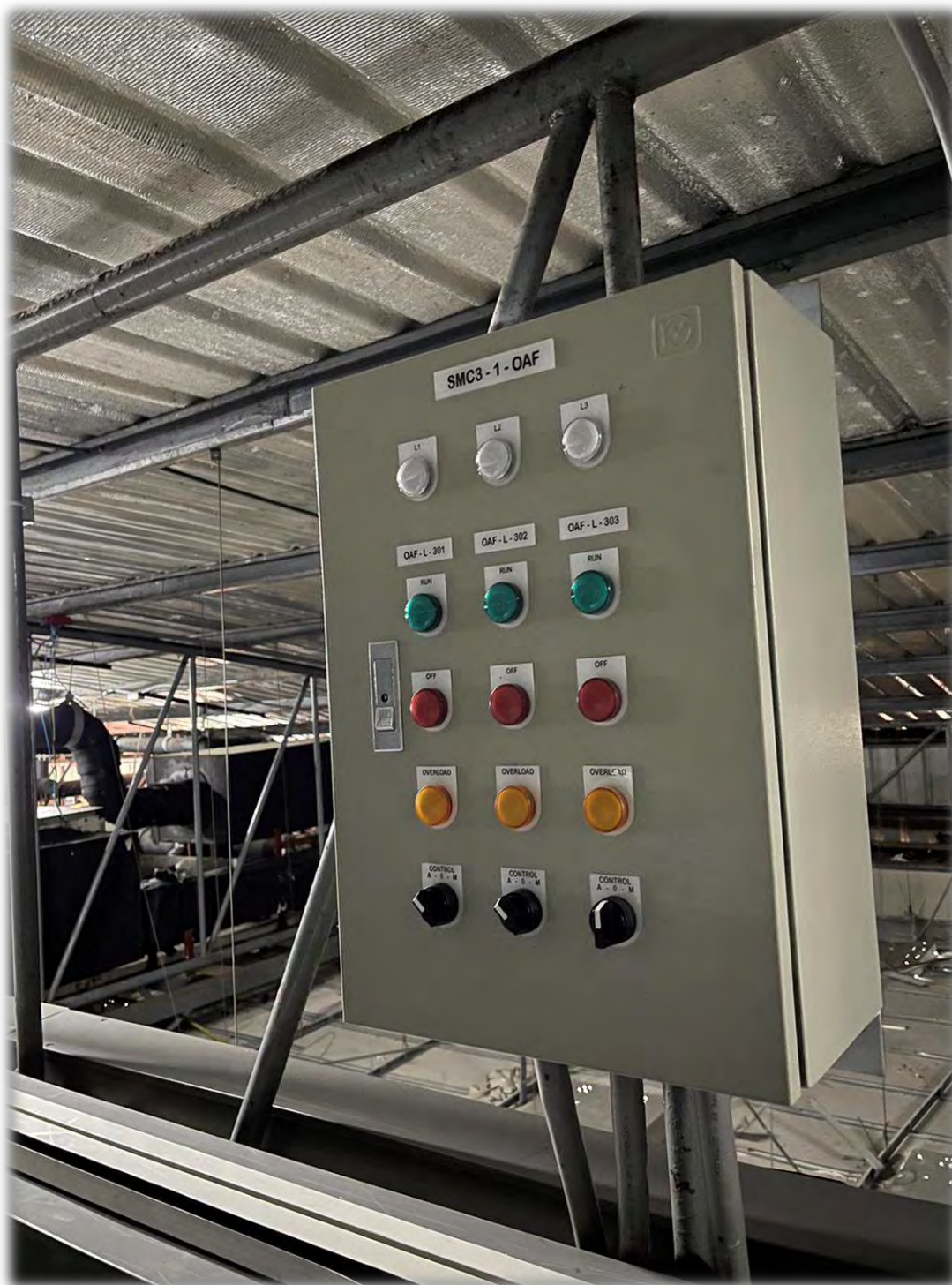
รูปที่ 4.4 ทดสอบระบบหลังการติดตั้ง
