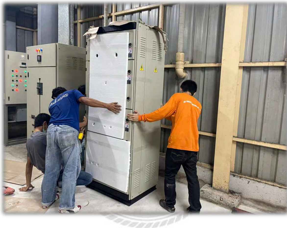
รูปที่ 4.14 เคลื่อนย้ายตู้ MDB
