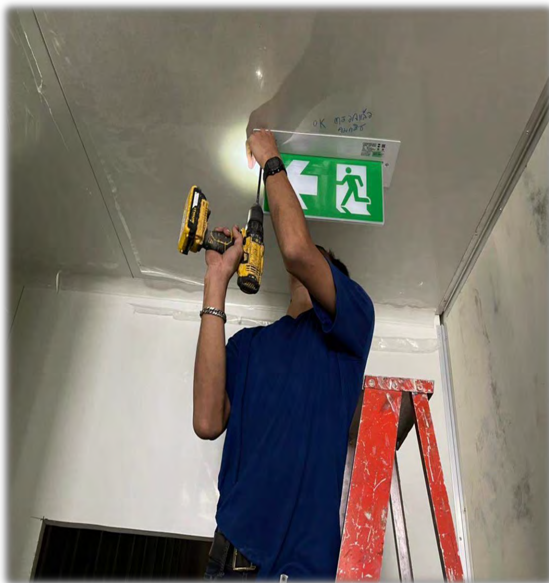
รูปที่ 4.12 ติดตั้งป้ายทางเดินหนีไฟ
