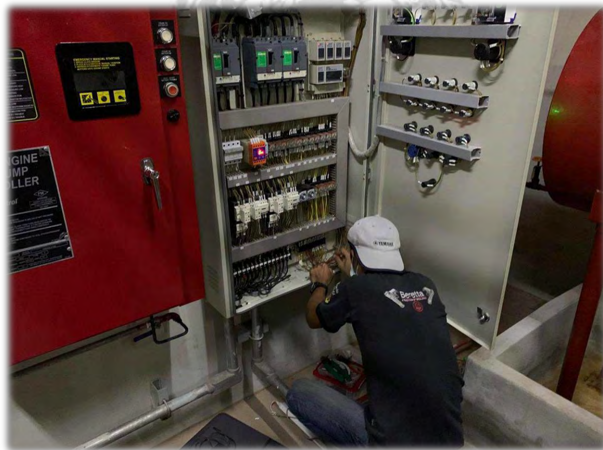
รูปที่ 4.3 ตรวจสอบหลังการติดตั้ง
