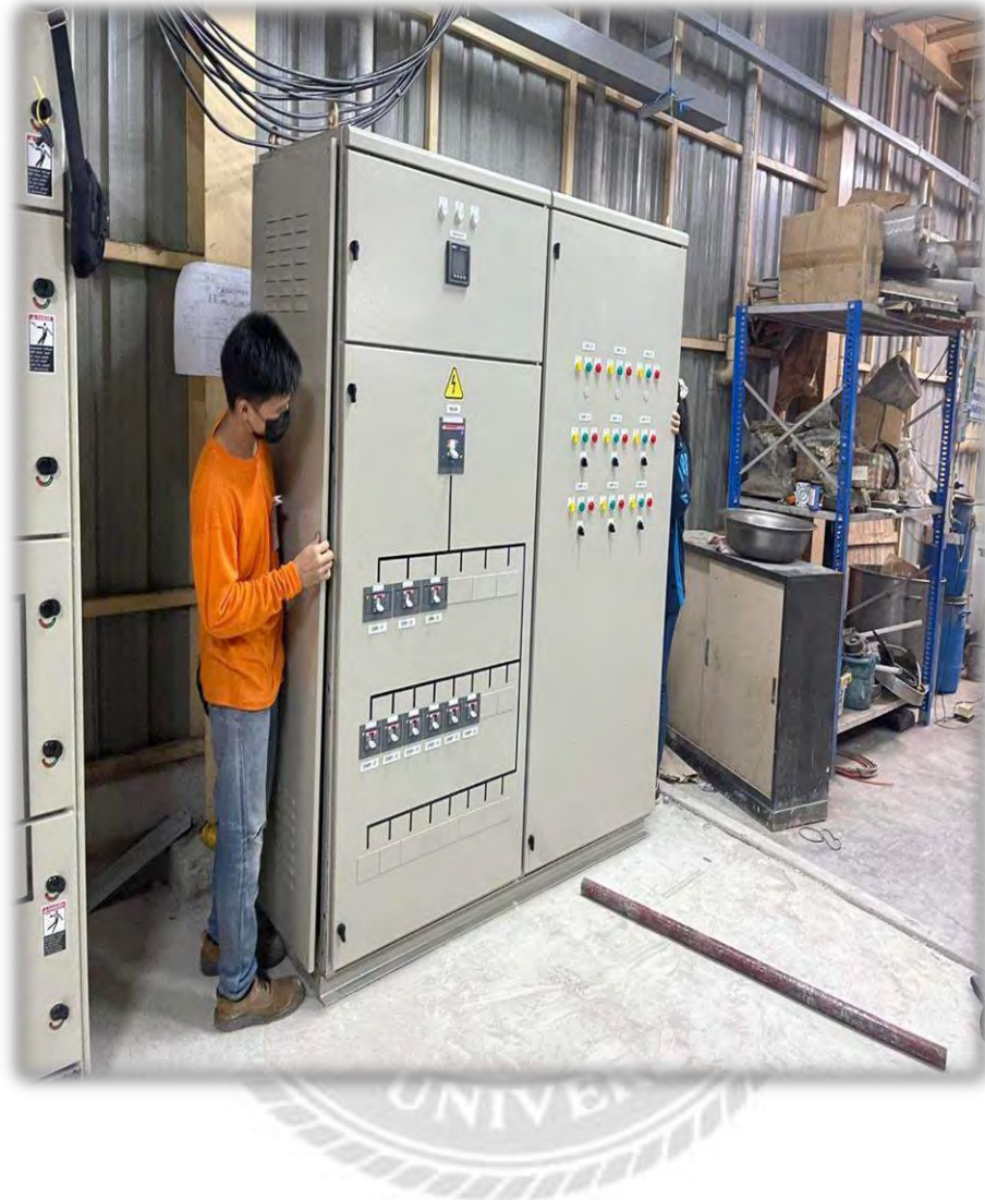
รูปที่ 3 ติดตั้งตู้ MDB
