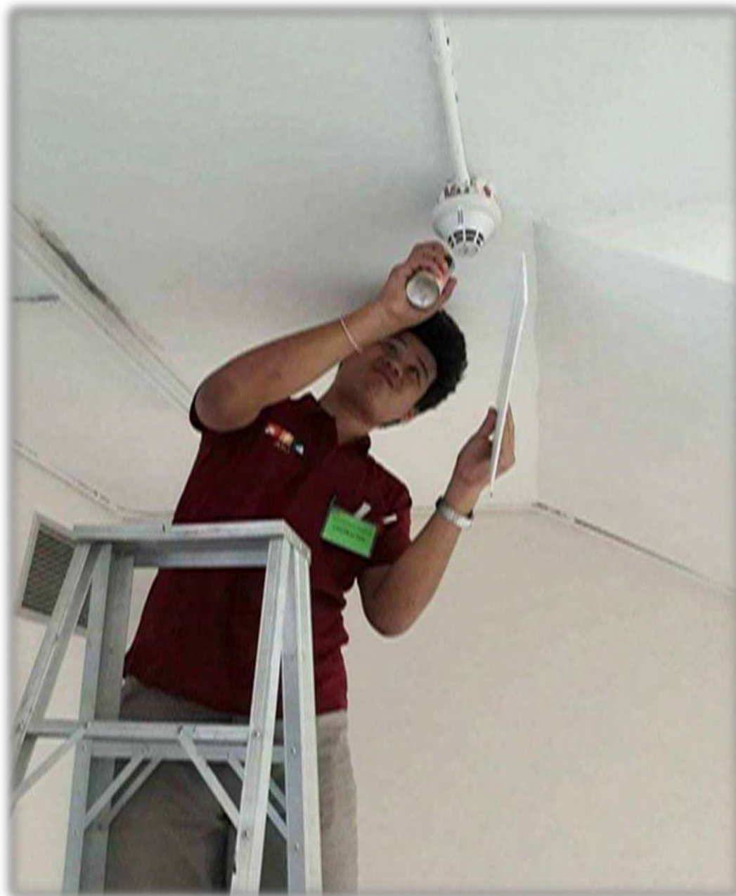
รูปที่ 4.11 การทดสอบ Smoke Detector หลังติดตั้ง
