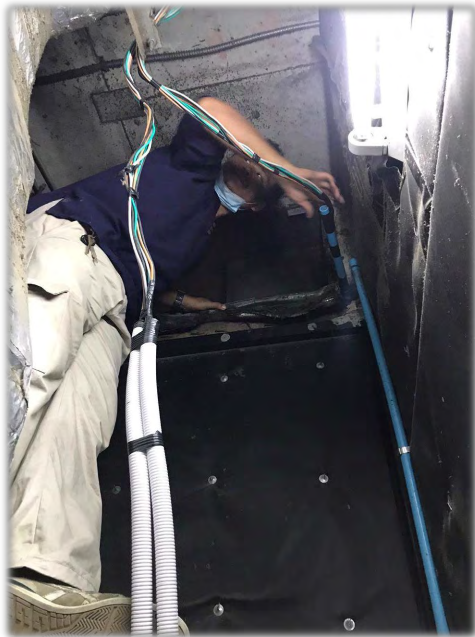
รูปที่ 4.5 การเดินท่อไฟทางเดินส่วนกลาง
