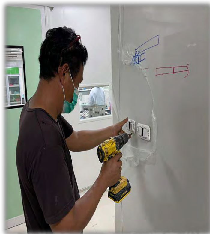
รูปที่ 4.8 ติดตั้งสวิตช์ไฟส่องสว่าง
