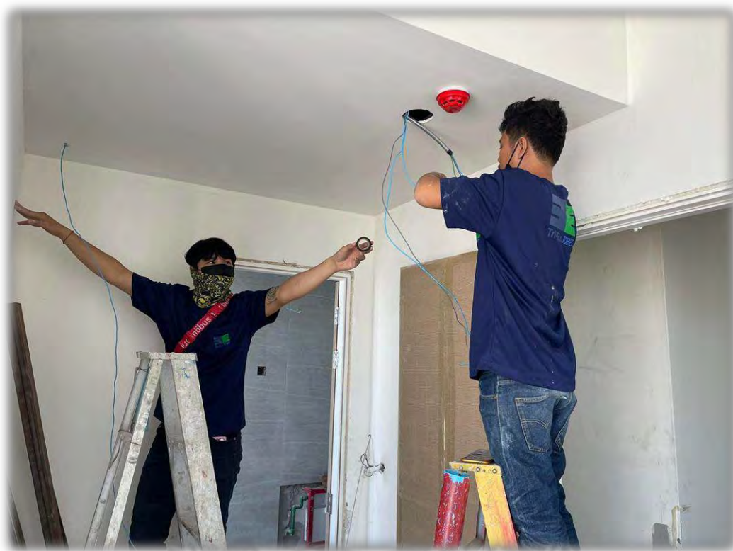
รูปที่ 4.10 การติดตั้งระบบแจ้งเหตุเพลิงไหม้
