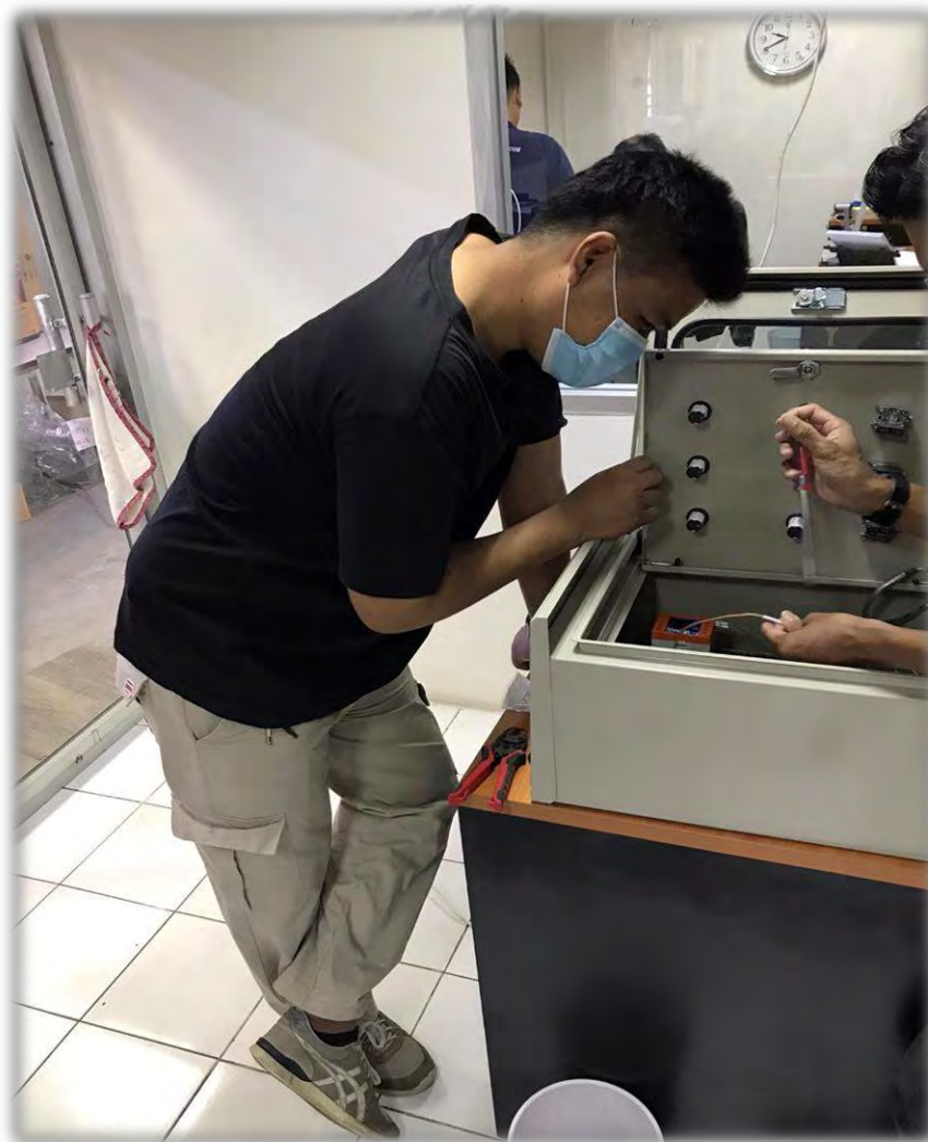
รูปที่ 4.2 ติดตั้งตู้ควบคุมระบบไฟฟ้า
