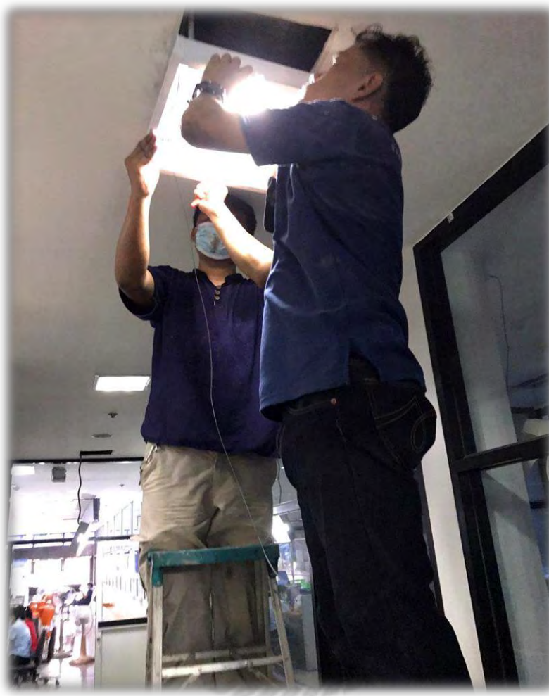
รูปที่ 4.7 ติดตั้งไฟฟ้าส่องสว่าง
