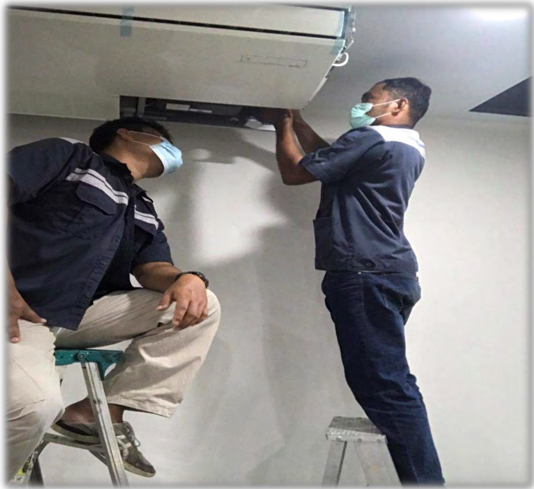
รูปที่ 2 ติดตั้งแอร์ทำความเย็น
