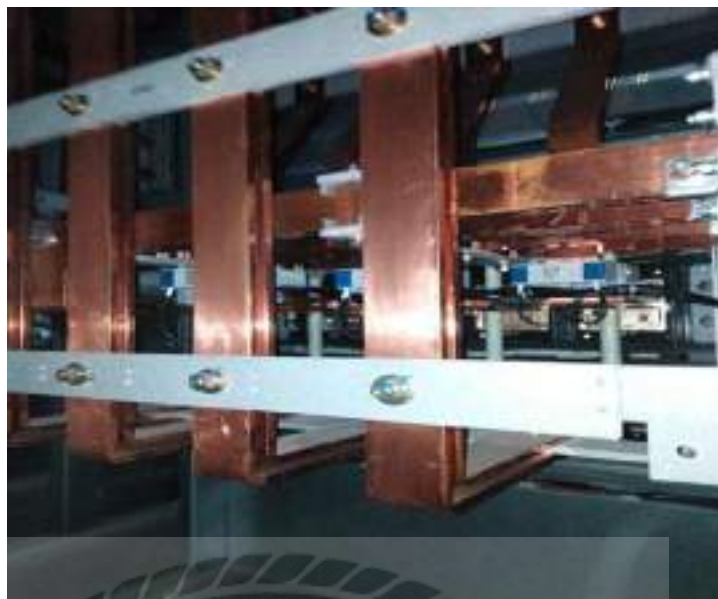
รูปที่ 2.3 บัสบาร์ (Busbar)
