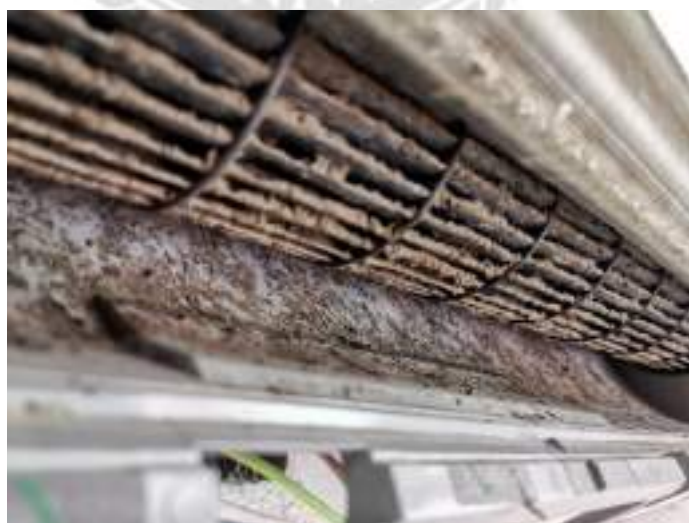
รูปที่ 4.9 แอร์มีเสียงดังที่เกิดจากโบร์เวอร์แอร์ตัน/ลมออกไม่สม่ำเสมอ
