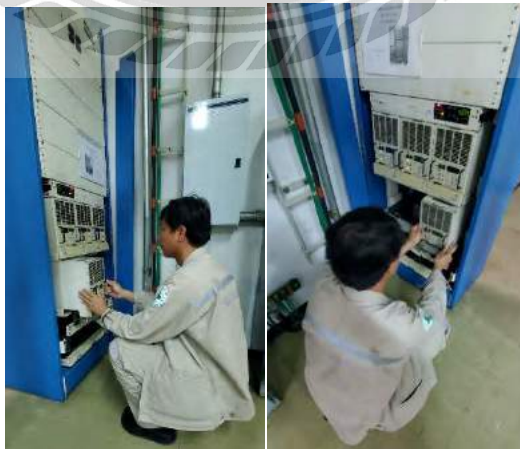
รูปที่ 4.2 ใส่โมดูล Rectifier
