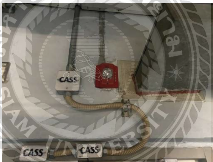
รูปที่ 4.7 Honstroke Light เตือนด้วยเสียงและแสง
