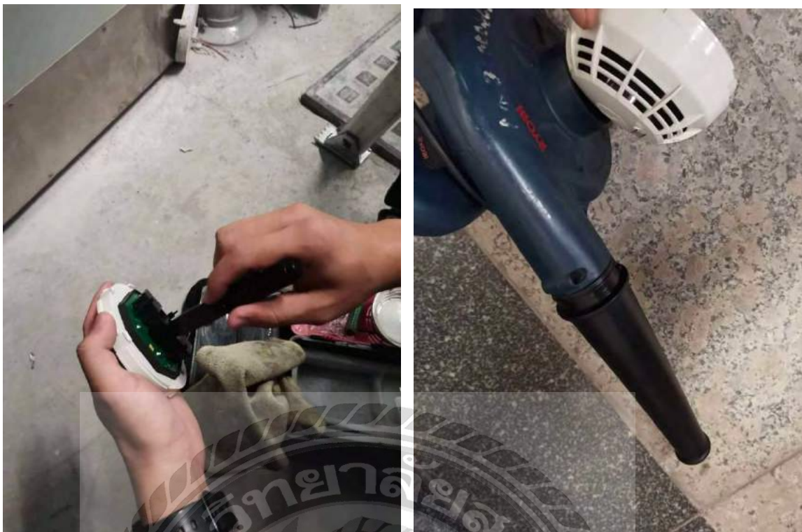
รูปที่ 4.12 ทำการถอดทำความสะอาดหัว Smoke เนื่องจากหัวสโมคจับค่าฝุ่นหรือกลุ่มควันได้ จึงต้องทำการทำความสะอาดให้ค่า Dirty ลดลง
