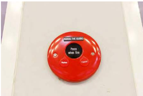
รูปที่ 2.14 อุปกรณ์เริ่มสัญญาณแบบมือดึง (Manual Pull Station) แบบกด
