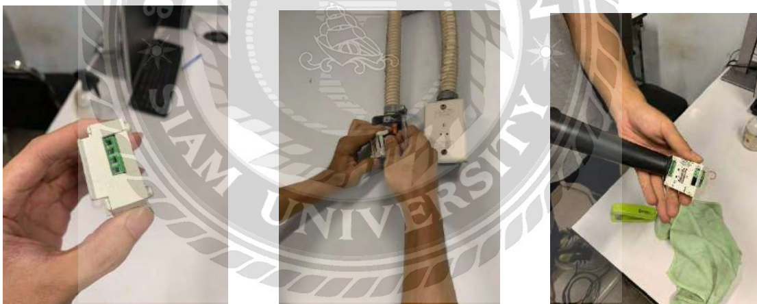
รูปที่ 4.12 ทำการถอดทำความสะอาดหัว Smoke เนื่องจากหัวสโมคจับค่าฝุ่นหรือกลุ่มควันได้ จึงต้องทำการทำความสะอาดให้ค่า Dirty ลดลง
