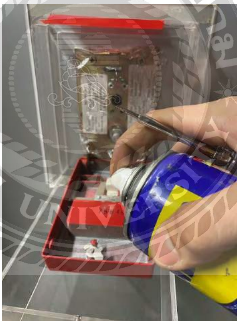
รูปที่ 5.6 การPMอุปกรณ์manualstation อุปกรณ์กรแจ้งเตือนอพยพด้วยมือ
