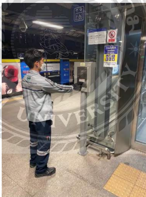
รูปที่ 5.4 อีเมอร์เจนซีเพื่อให้ผู้โดยสารกดหรือโทรมาที่ตู้ fireAlarmcontrolpanel
