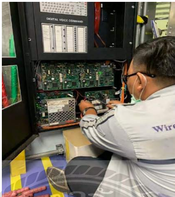
รูปที่ 4.11 ได้ทำการตรวจเช็คหรือซ่อมบำรุงเชิงแก้ไขที่ขั้วแบตเตอรี่ของตู้ FCP ทำการขันสายให้แน่น
