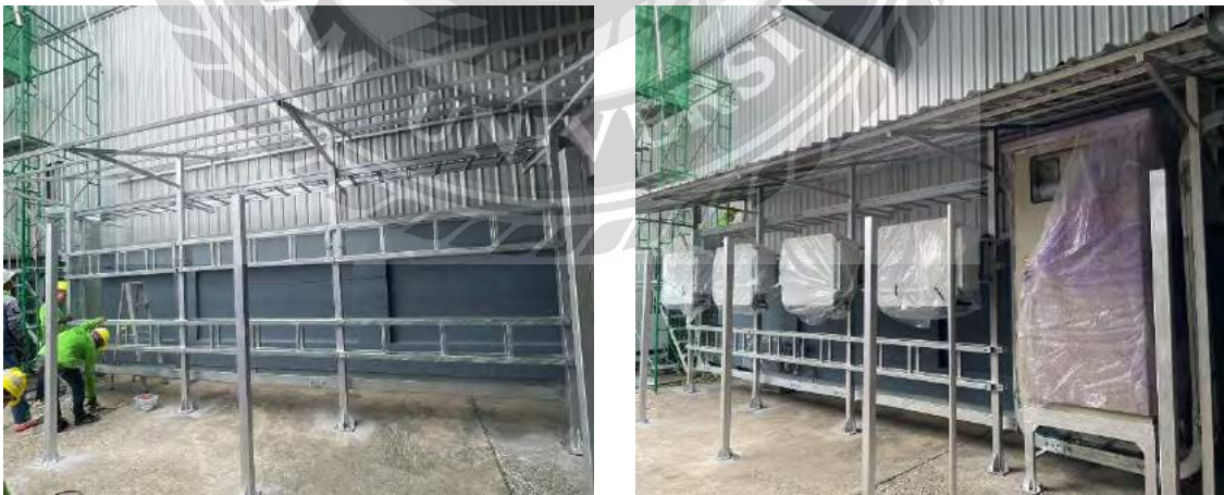
รูปที่ 4.9 ติดตั้งห้อง Inverter
