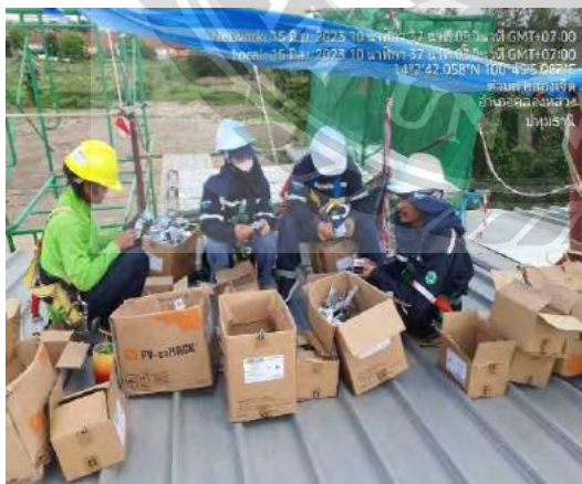
รูปที่ 4.5 การติดตั้ง L-Feet ยึดหลังคา
