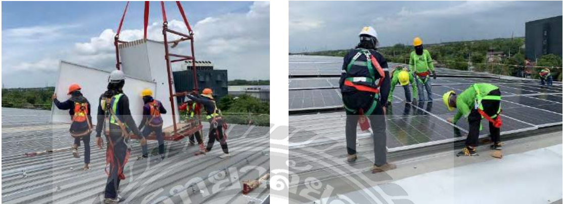
รูปที่ 4.10 การวางแผงโซล่าเซลล์เตรียมก่อนติดตั้ง
