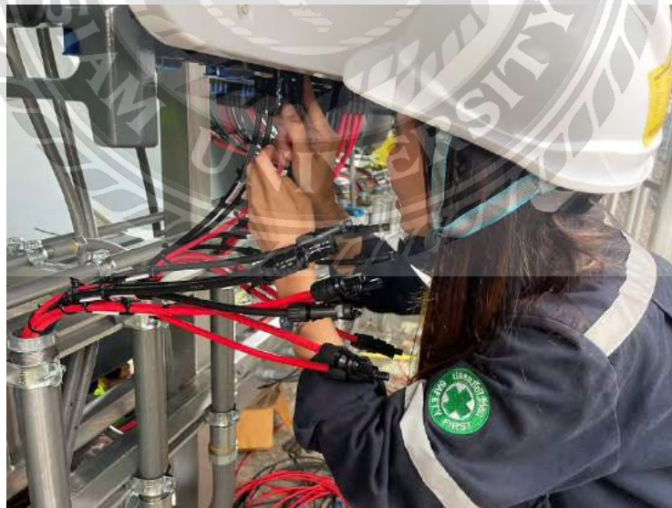
รูปที่ 20 เข้าสายไฟ DC ที่ Inverter ของแต่ละสตริง
