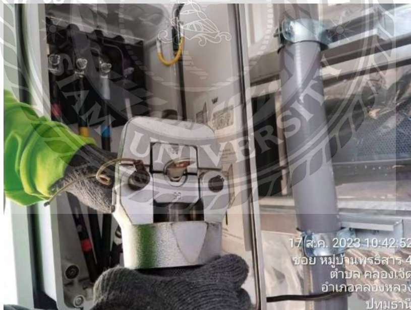
รูปที่ 18 เข้าสายไฟของตู้ Inverter
