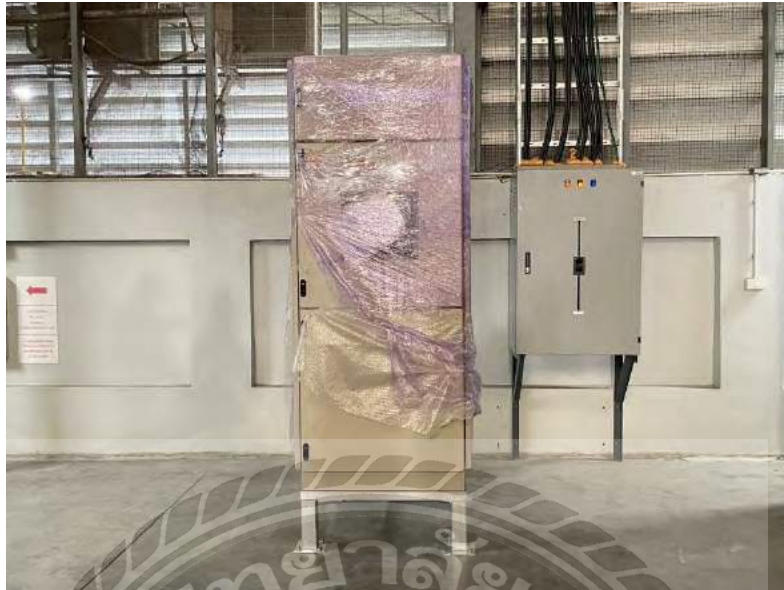
รูปที่ 5 ติดตั้งตู้ CB BOX Panel
