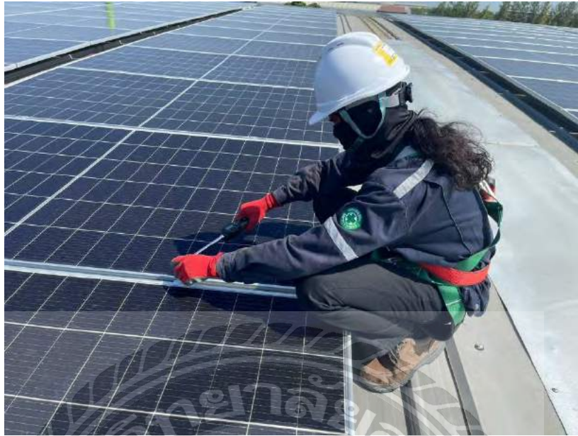
รูปที่ 17 Torque น็อตจับยึดแผงโซลาร์เซลล์
