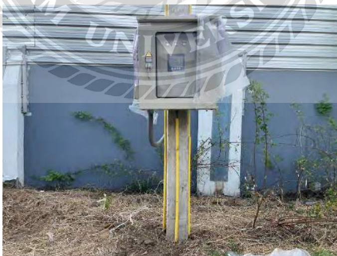
รูปที่ 4.21 การเดินท่อกราวด์ลงหลักดิน
