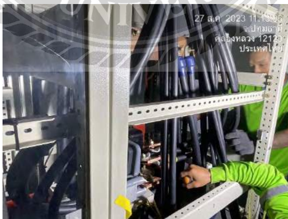
รูปที่ 4.17 ต่อสายจากตู้ CB BOX ไปยังตู้ MDB
