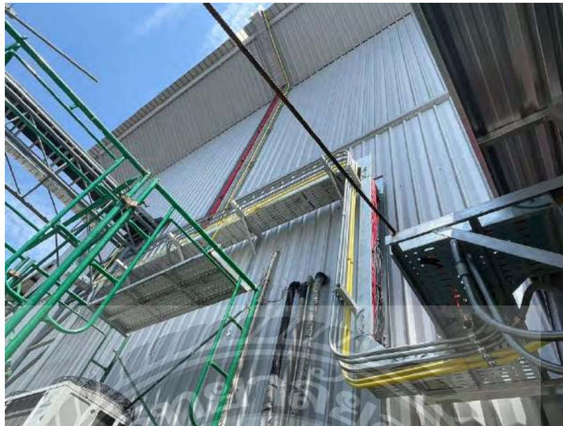
รูปที่ 22 เดินท่อ IMC
