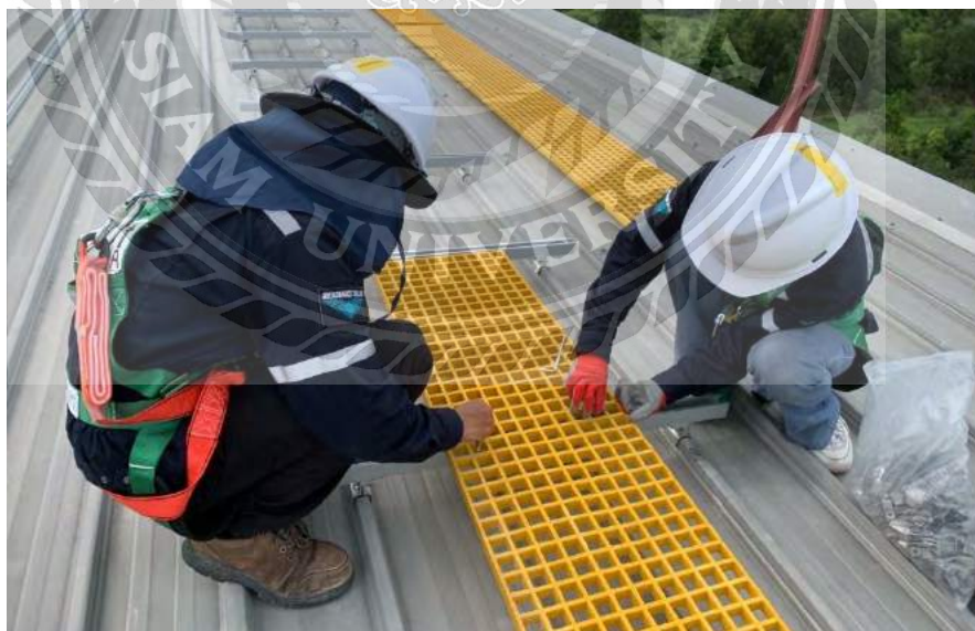
รูปที่ 2 การติดตั้ง Walkway
