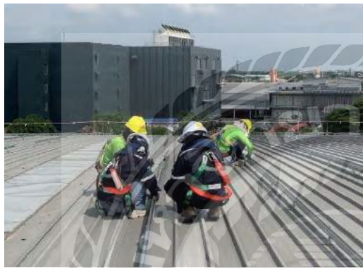
รูปที่ 4.6 การติดตั้งรางอลูมิเนียม ( Rail ) ยึดเข้ากับ L-Feet
