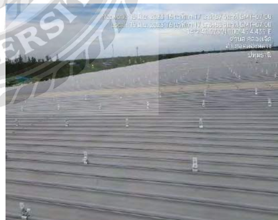
รูปที่ 4.5 การติดตั้ง L-Feet ยึดหลังคา
