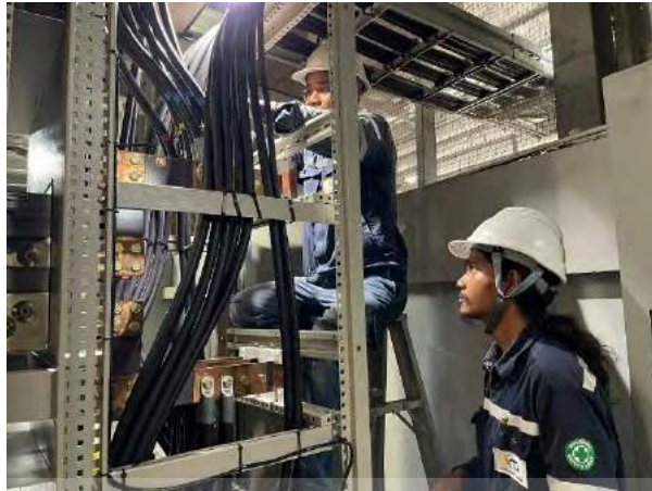
รูปที่ 4.16 ต่อสายจากตู้ ACS ไปยังตู้ CB BOX
