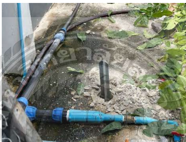
รูปที่ 4.20 การต่อแท่งหลักดิน ( กราวด์ร็อดตะมะเฟือง )
