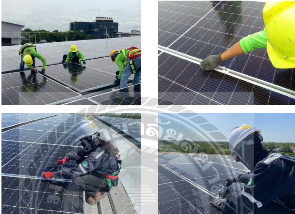
รูปที่ 4.12 จับยึดแผงโซล่าเซลล์
