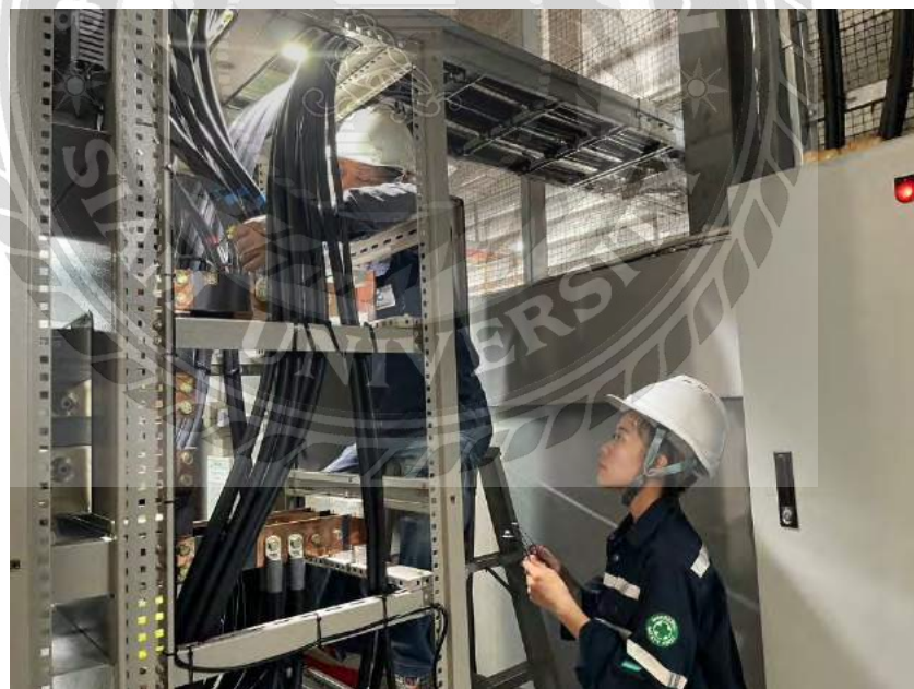
รูปที่ 9 เดินสายไฟ AC เข้าตู้
