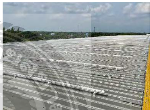
รูปที่ 4.6 การติดตั้งรางอลูมิเนียม ( Rail ) ยึดเข้ากับ L-Feet
