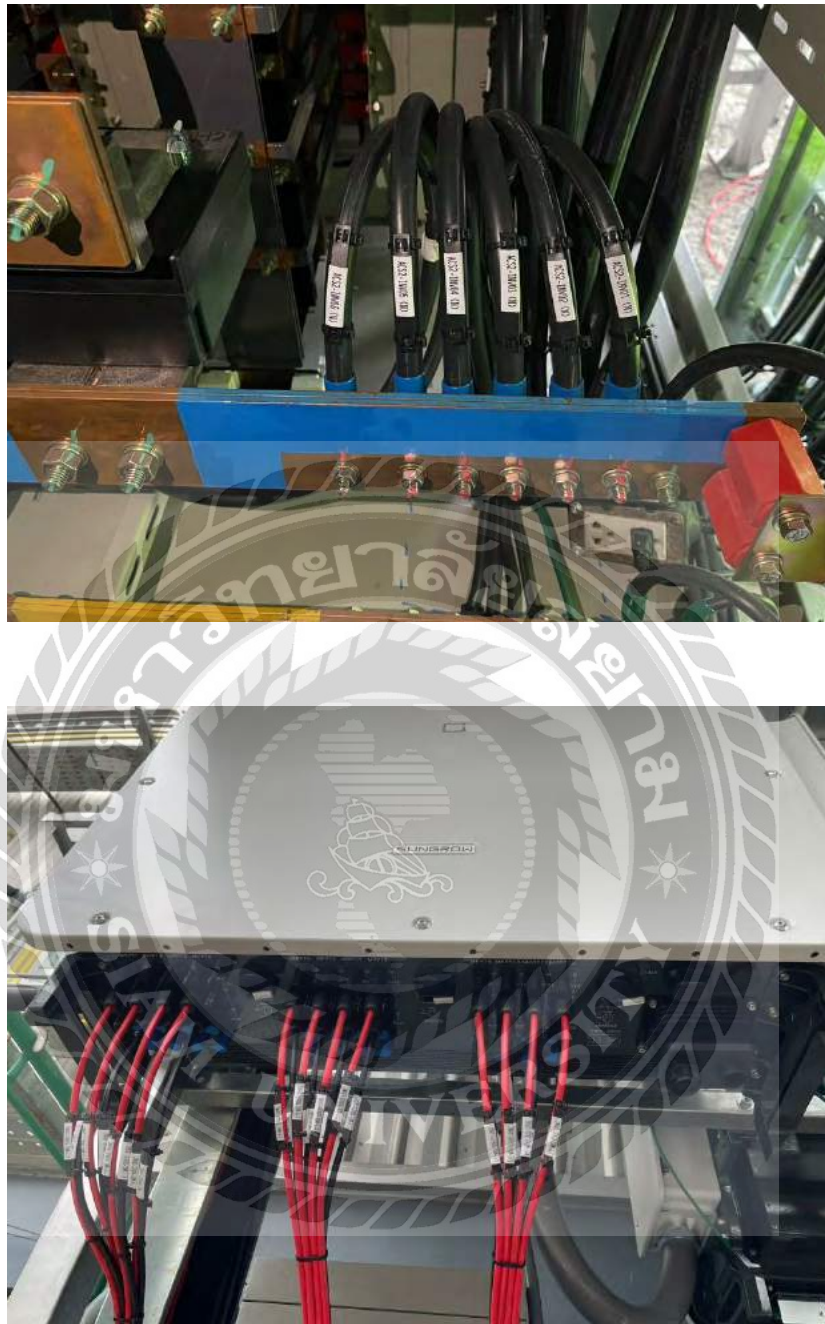
รูปที่ 21 มาร์คสายไฟทั้งของ DC และ AC
