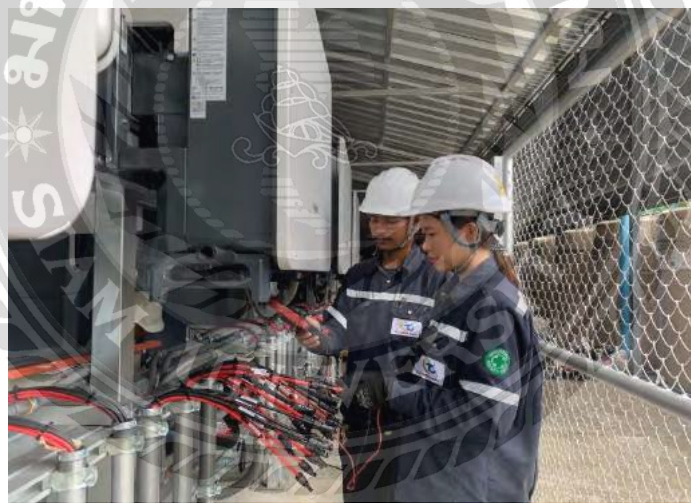
รูปที่ 4.24 ตรวจเช็คค่ากำลังไฟฟ้าจากแผงของแต่ละอินเวอร์เตอร์
