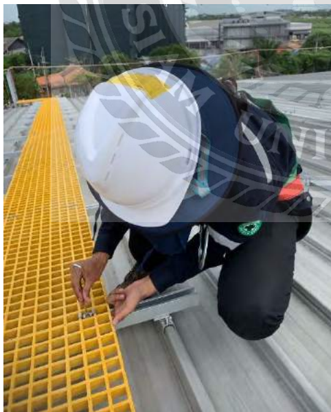
รูปที่ 4.7 การติดตั้ง Walkway
