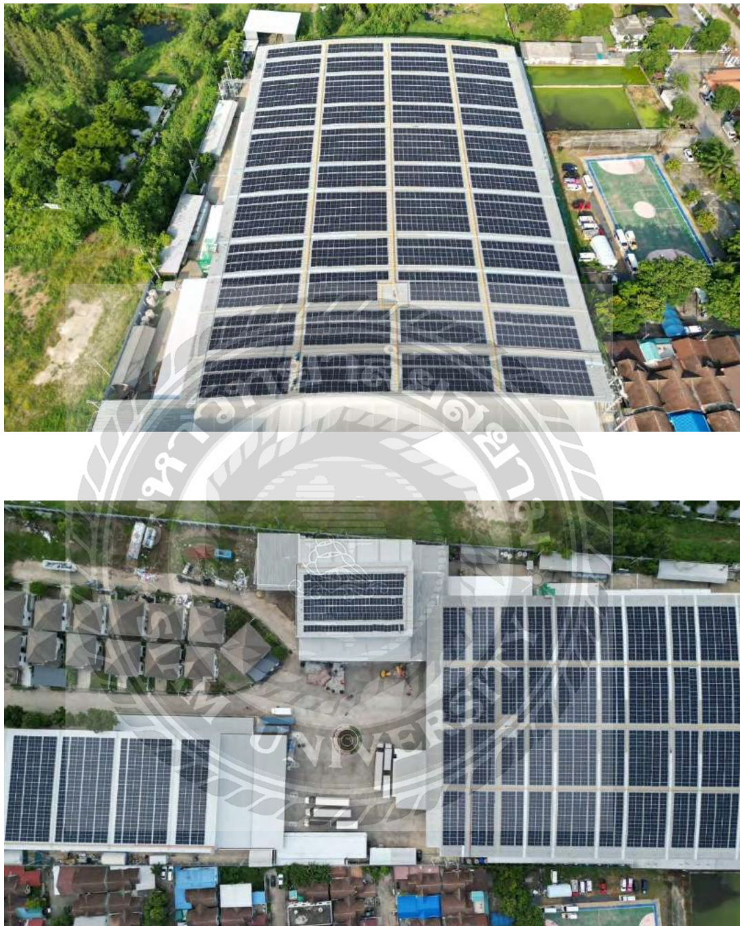
รูปที่ 24 ภาพการติดตั้งแล้วเสร็จ Solar Rooftop 1,998.99 kWp.
