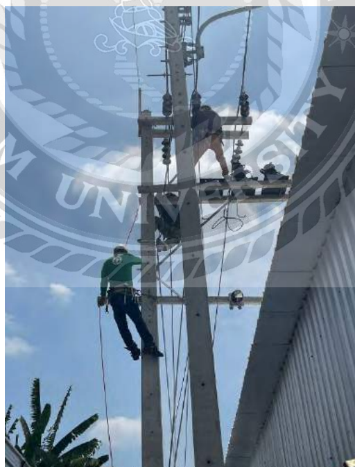
รูปที่ 4.19 ติดตั้งคล้อง CT และ PT
