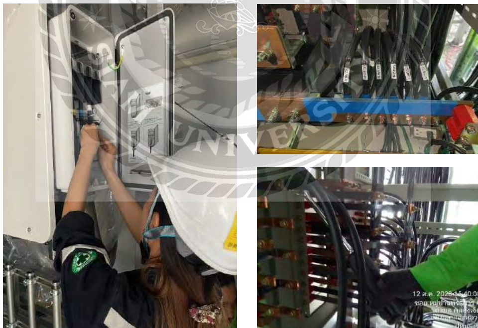
รูปที่ 4.15 ต่อสายจากอินเวอร์เตอร์ไปยังตู้ ACS
