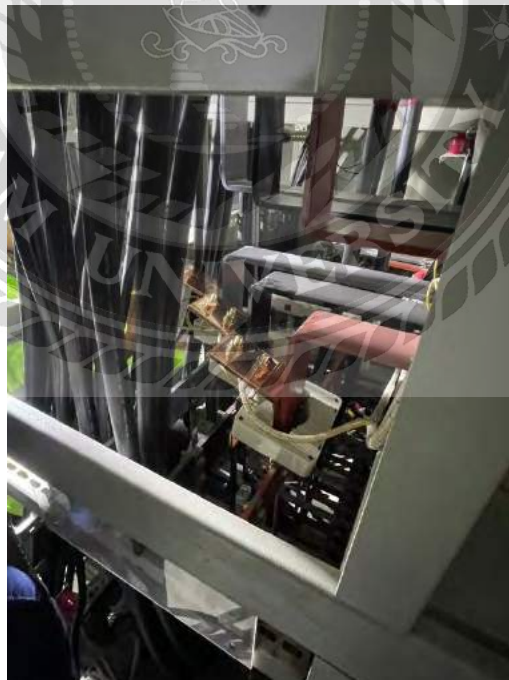
รูปที่ 11 Modify Busbar ตู้ MDB
