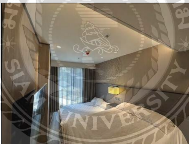
รูปที่ 4.18 บริเวณห้องนอนห้อง Type 2B1 ประกอบด้วยคอมไฟชนิด AJ2 และ AJ1 และระบบฉุกเฉินภายในห้องนอน ประกอบด้วย Smoke, Sprinkler Head and Heat Detector
