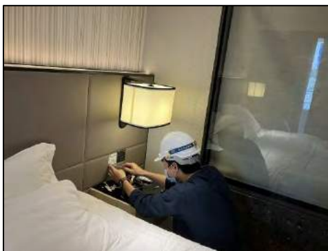
รูปที่ 4.8 การติดตั้งสวิตช์เปิด-ปิด ดวงโคมสำหรับไฟหัวเตียงของห้อง Type SK1 ชนิดโคมไฟ AJ2
