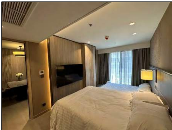
รูปที่ 4.17 บริเวณห้องนอนห้อง Type 2B1 ประกอบด้วยคอมไฟชนิด AJ2 และ AJ1 และระบบฉุกเฉินภายในห้องนอน ประกอบด้วย Smoke, Sprinkler Head and Heat Detector และ room thermostat ควบคุมอุณหภูมิของเครื่องปรับอากาศภายในห้อง
