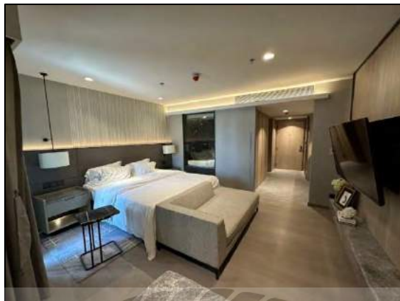
รูปที่ 4.9 ห้อง Type SK1 บริเวณห้องนอน ประกอบด้วย โคมไฟชนิด AJ1 และ AJ3 รวมถึงระบบฉุกเฉินภายในห้อง ประกอบด้วย Smoke, Sprinkler Head and Heat Detector.
