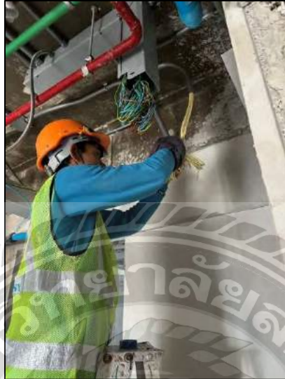
รูปที่ 4.3 การร้อยสาย TIEV for Telephone. (In rooms)
