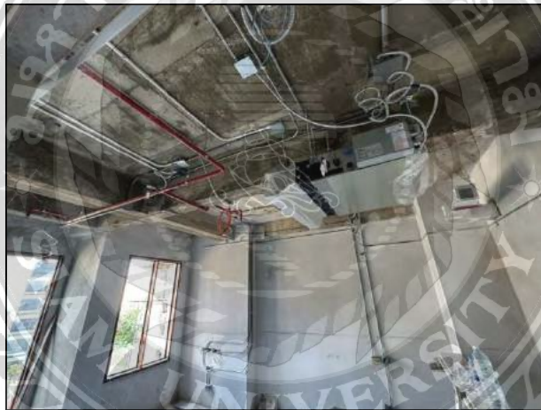
รูปที่ 4.1 การเดินท่อห้องพื้นและเดินลอยผนังของระบบ Power Lighting and Power for AC
