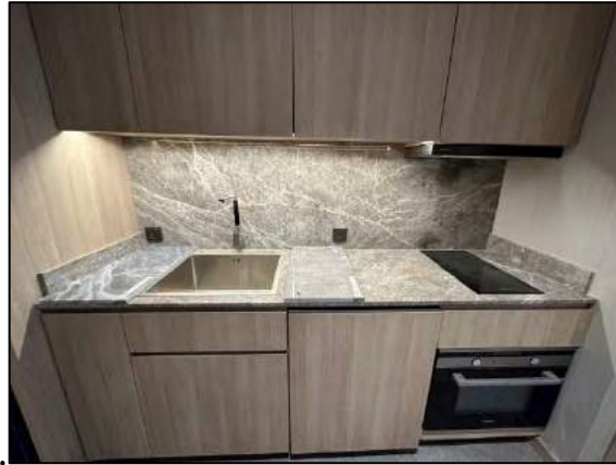
รูปที่ 4.11 ห้องครัว Type SK1 ระบบแสงสว่างประกอบด้วยโคมไฟชนิด AJ3 และ ระบบปลั๊กสำหรับ เครื่องใช้ไฟฟ้า
