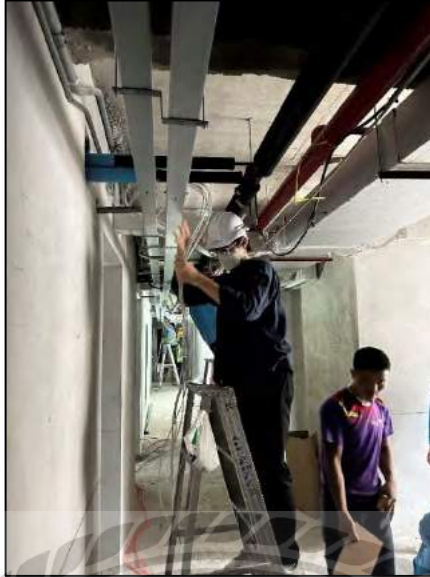
รูปที่ 4.5 การร้อยสาย CAT-6 for Internet, CCTV, Communication System. (Corridor)
