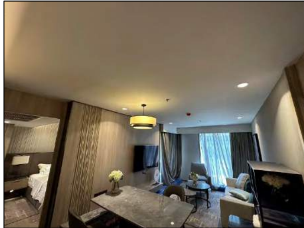
รูปที่ 4.19 บริเวณห้องรับแขกห้อง Type 2B1 ระบบแสงสว่างประกอบด้วย โคมไฟ Pendent Light and AJ1 รวมถึงมีระบบฉุกเฉินภายในห้องรับแขก Smoke, Sprinkler Head and Heat Detector
