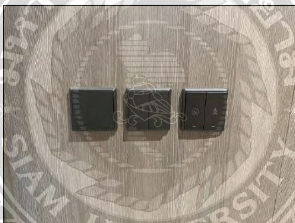
รูปที่ 4.14 ปลั๊กและสวิตช์บริเวณทางเดิน ห้อง Type 2B1 เป็นสวิตช์ควบคุมแสงสว่างส่วนกลางภายในห้องพักและสวิตช์สามารถเปิด-ปิดระบบไฟฟ้าทั้งหมดภายในห้อง
