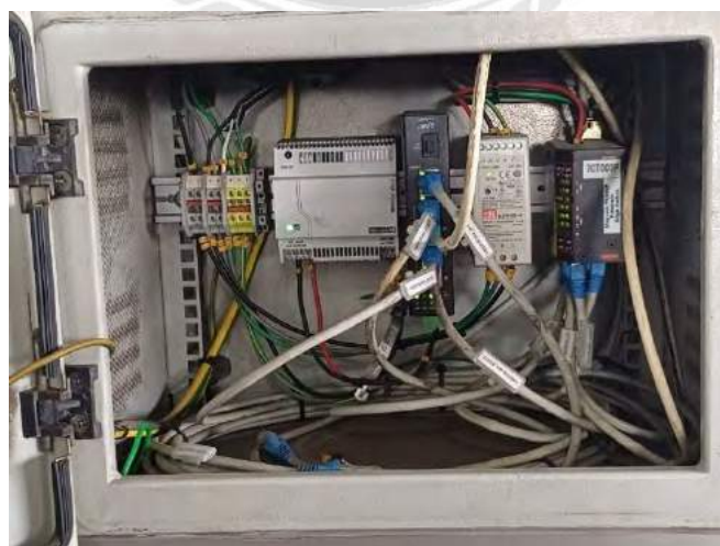
รูปที่ 4.4 อุปกรณ์เชื่อมต่อกับกล่องวงจรปิด
