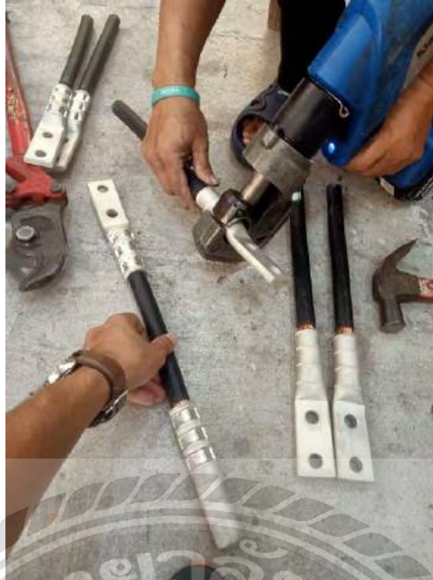
รูปที่ 4.8 ขั้นตอนการย้ำหางปลาเข้ากับสายทองแดง
