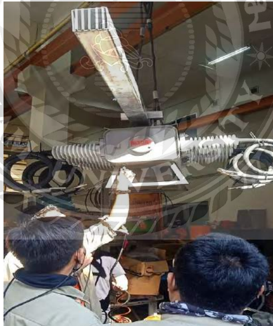
รูปที่ 4.3 อุปกรณ์สำหรับตัดต่อระบบไฟฟ้าแรงสูง (Load Break Switch)
