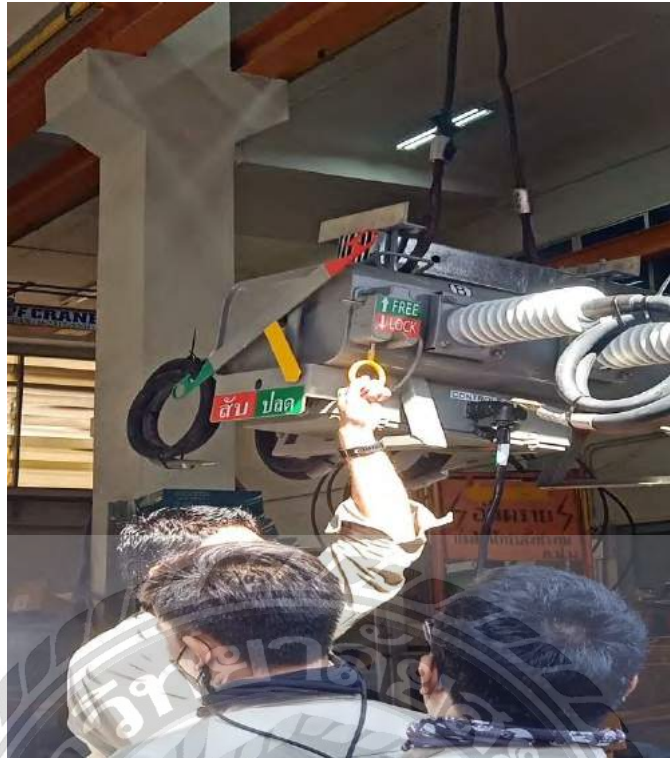
สถิติระบบ safety ของอุปกรณ์สำหรับตัดต่อระบบไฟฟ้าแรงสูง (Load Break Switch)
