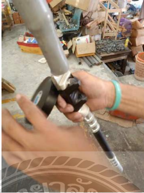
รูปที่ 4.10 ขั้นตอนการพัน High Volt Tape ทางปลาเข้ากับอุปกรณ์สำหรับตัดต่อระบบ ไฟฟ้าแรงสูง (Load Break Switch)
