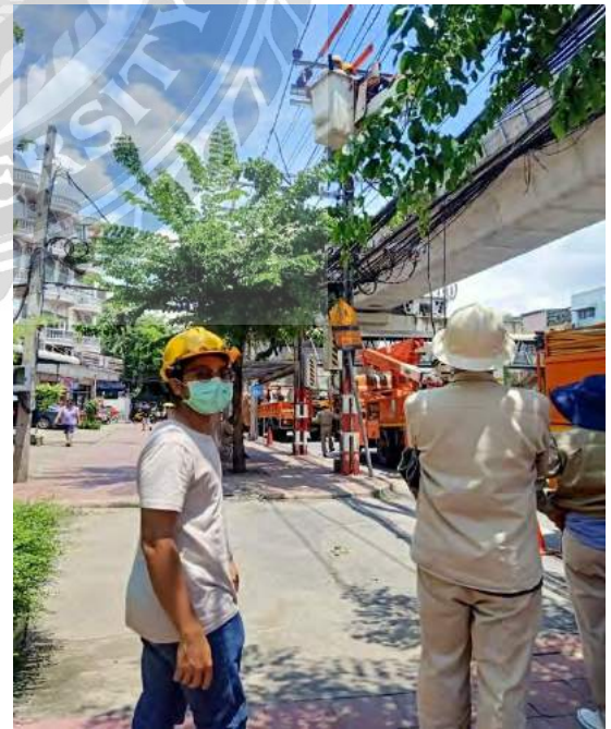
ควบคุมงานการติดตั้งอุปกรณ์สำหรับตัดต่อระบบไฟฟ้าแรงสูง (Load Break Switch)
