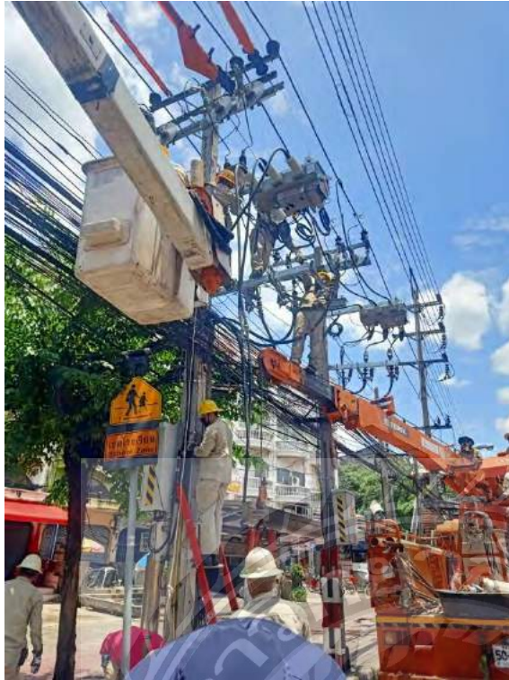
การติดตั้งอุปกรณ์สำหรับตัดต่อระบบไฟฟ้าแรงสูง (Load Break Switch) หน่วยงานจริง
