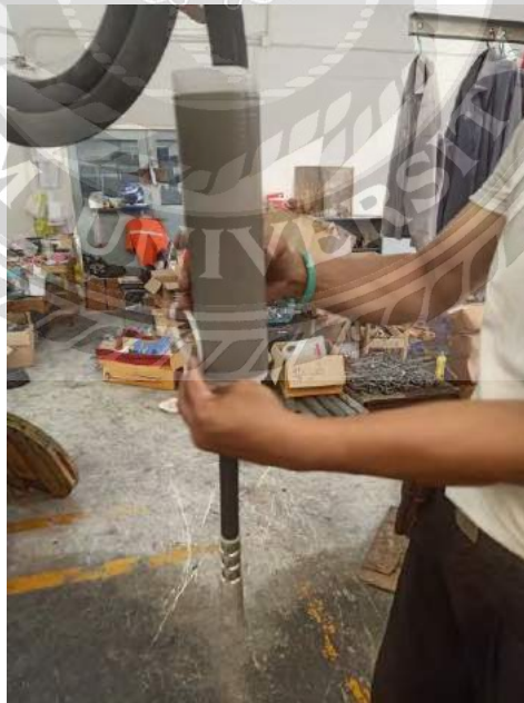
รูปที่ 4.11 ขั้นตอนการหุ้มฉนวน Cool shrink ซิลิโคน ระหว่างรอยต่อของทางปลา
