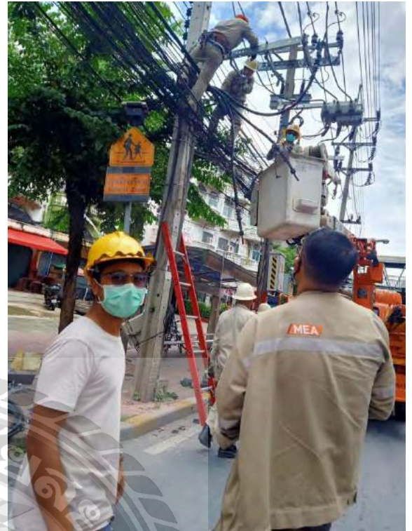
การติดตั้งอุปกรณ์สำหรับตัดต่อระบบไฟฟ้าแรงสูง (Load Break Switch) หน่วยงานจริง
