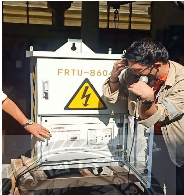
สาธิตการใช้งานตู้ FRTU (Feeder Remote Terminal Unit)
