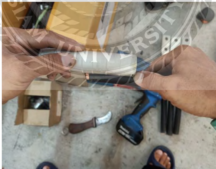
รูปที่ 4.7 วัดระยะก่อนทำการย้่า SLEEVE กับสายทองแดง
