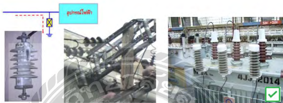
รูปที่ 2.18 ตรวจสอบกับดักฟ้าผ่า
