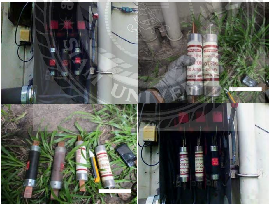
รูปที่ 4.11 เปลี่ยนฟิวส์ที่ตู้ Disconnecting switch
