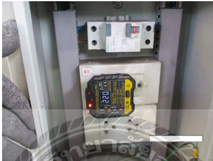
รูปที่ 4.33 ภาพเต้ารับที่ไม่พบการต่อสาย G
