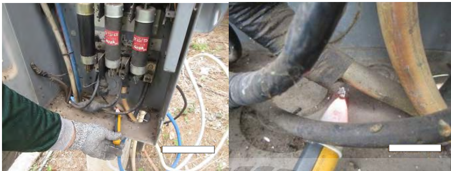
รูปที่ 4.16 สายที่ถูกตัดแล้วไม่มีการพันเทป
