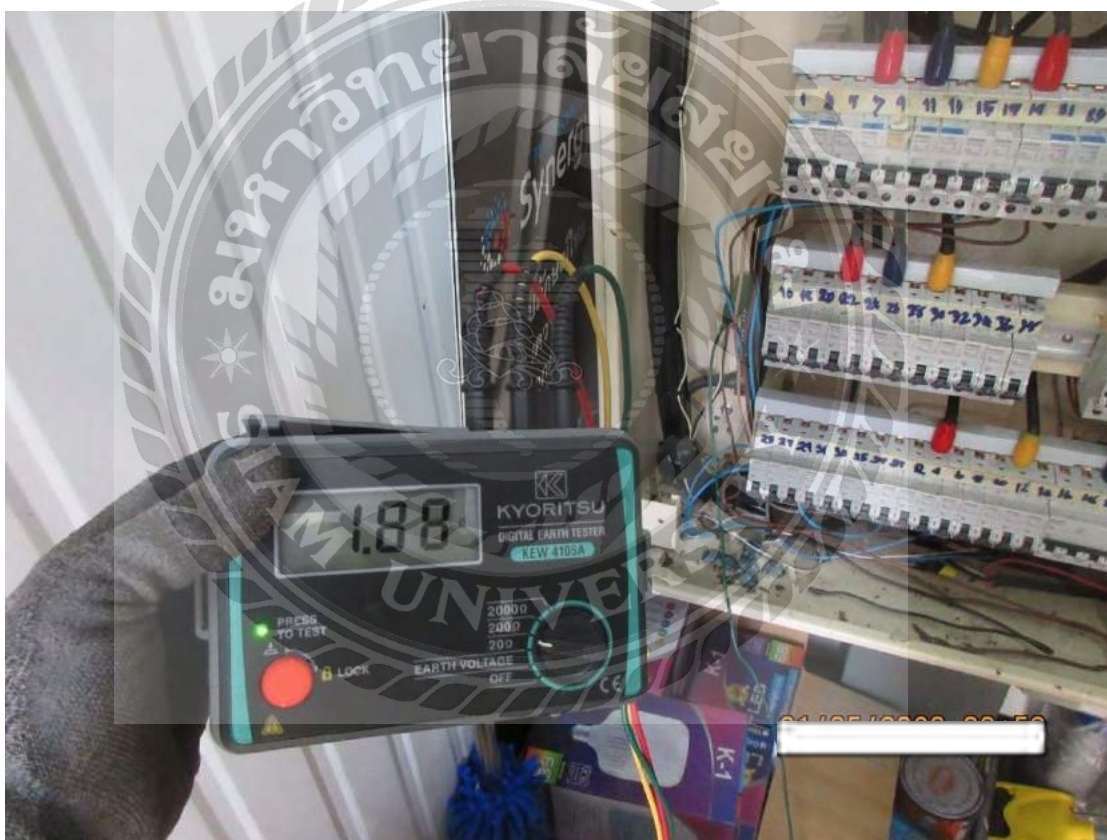
รูปที่ 4.20 ภาพการวัดแรงดันทั้ง 3 เฟสของตู้ MDB
