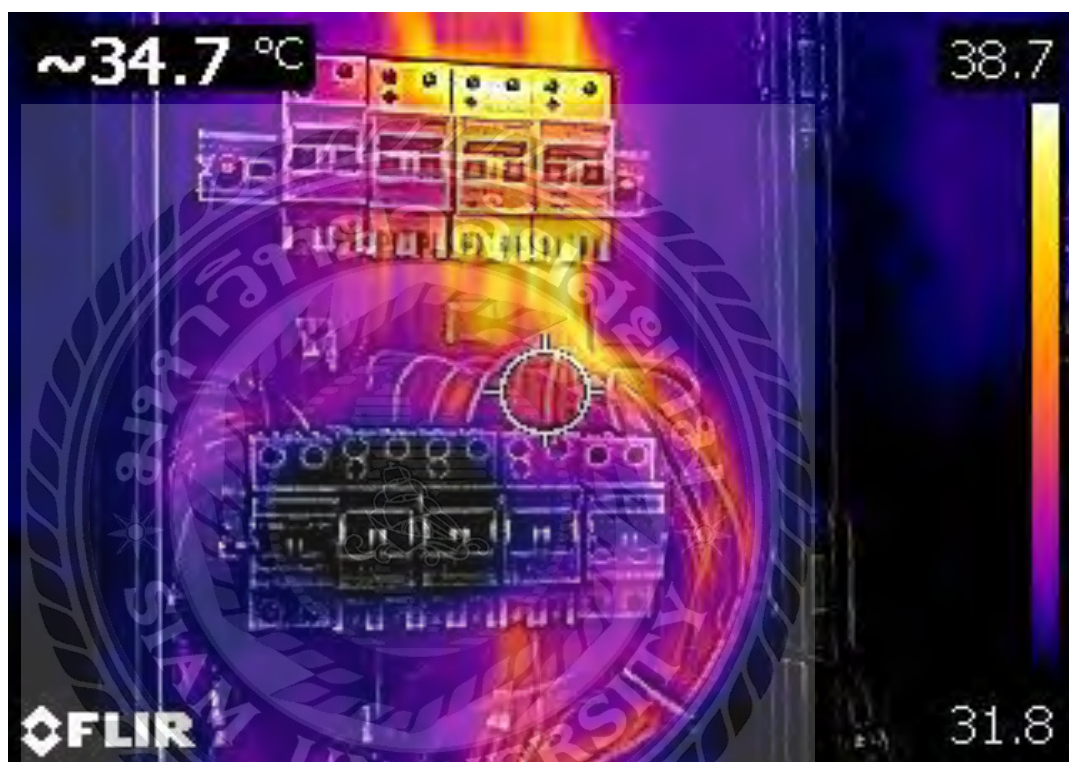
รูปที่ 4.23 ภาพถ่ายความร้อนของตู้ LP
