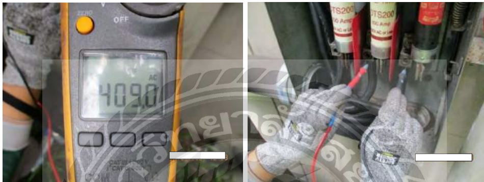
รูปที่ 4.12 วัดแรงดันทั้ง 3 เฟส
