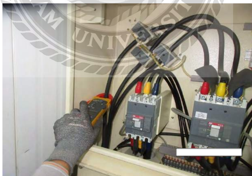
รูปที่ 4.19 ภาพการวัดกระแสทั้ง 3 เฟส ของตู้ MDB
