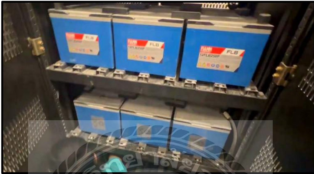
รูปที่ 4.10 งานติดตั้งและตรวจสอบแบตเตอรี่
