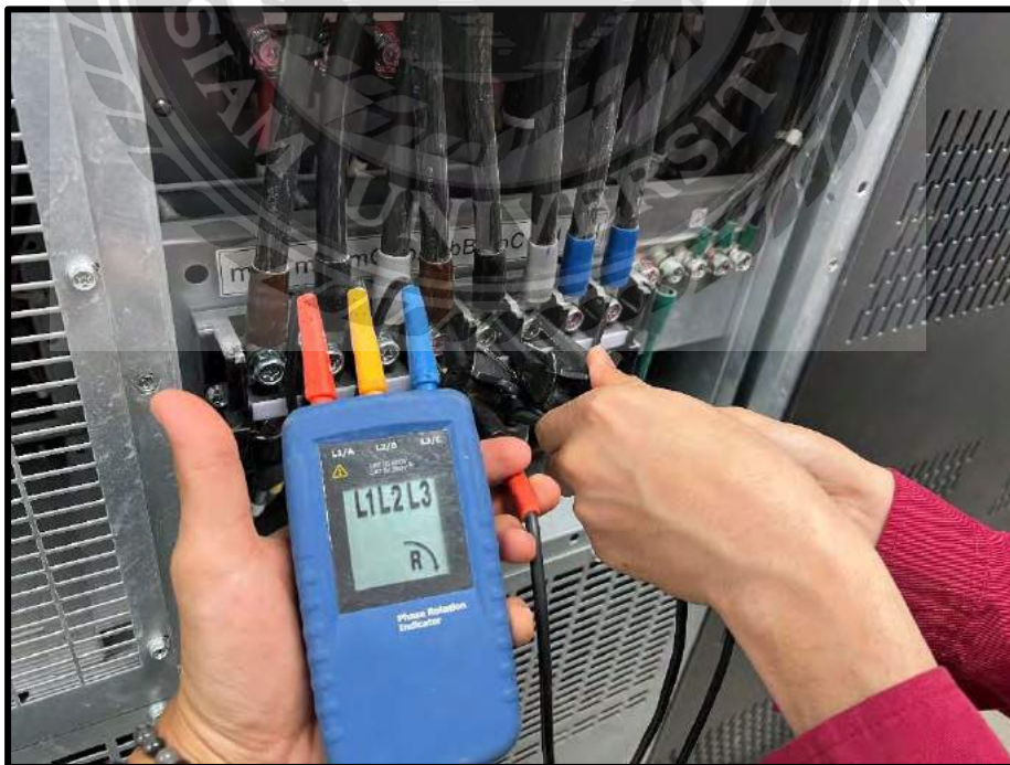
รูปที่ 4.13 งานทดสอบวงจรโดยใช้เครื่องวัดเฟสไฟฟ้า
