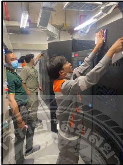
รูปที่ 4.14 ตรวจสอบการติดตั้งระบบ UPS
