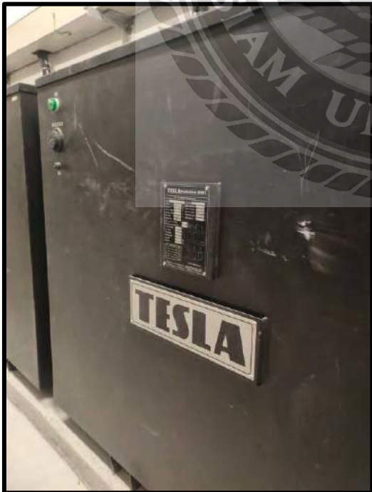
รูปที่ 4.9 งานติดตั้ง Isolation Transformer
