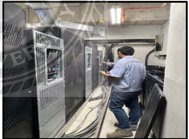
รูปที่ 4.5 งานเดินรางและร้อยสายเข้าสู่ตู้ไฟฟ้า
