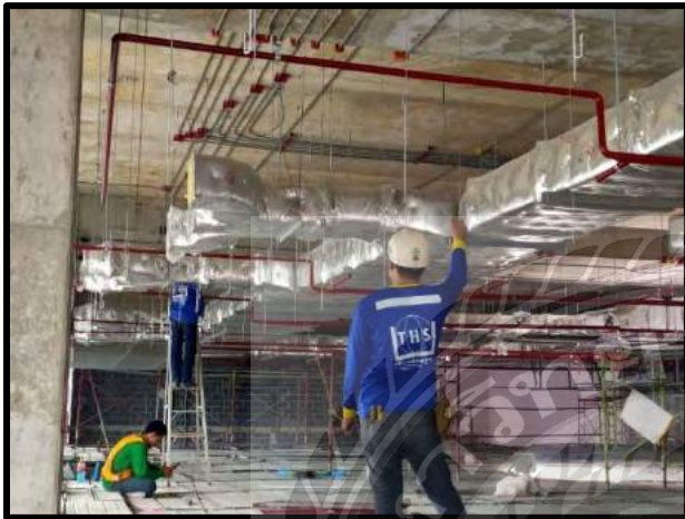
รูปที่ 4.4 งานเดินท่อและร้อยสาย
