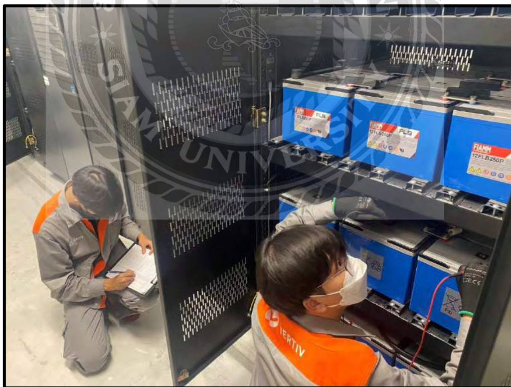
รูปที่ 4.11 งานติดตั้งและตรวจสอบแบตเตอรี่
