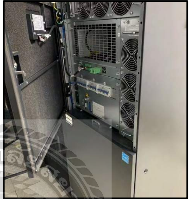
รูปที่ 4.8 งานติดตั้งเครื่อง UPS
