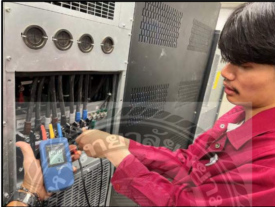
รูปที่ 4.12 งานทดสอบวงจรโดยใช้เครื่องวัดเฟสไฟฟ้า
