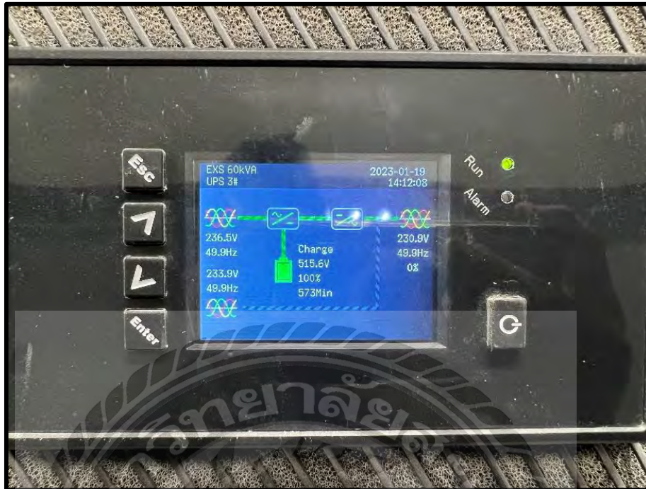
รูปที่ 4.16 หน้าจอแสดงการทำงานของระบบภายในเครื่อง UPS
