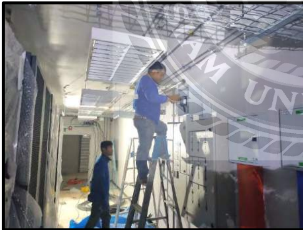
รูปที่ 4.5 งานเดินรางและร้อยสายเข้าสู่ตู้ไฟฟ้า
