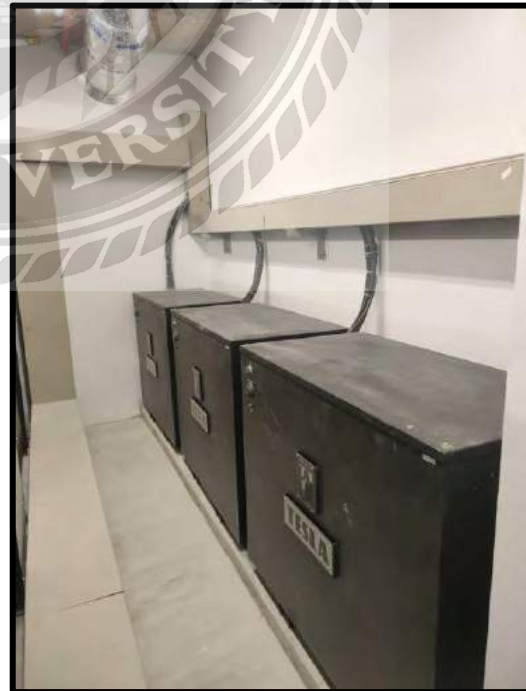
รูปที่ 4.9 งานติดตั้ง Isolation Transformer
