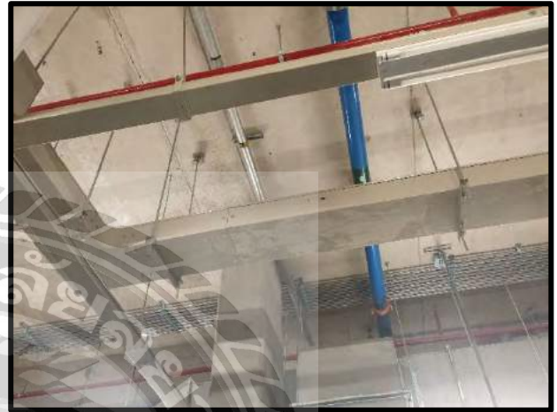
รูปที่ 4.4 งานเดินท่อและร้อยสาย
