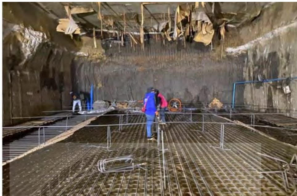
รูปที่ 7 งานลงเหล็กพื้นตามขวางบน
