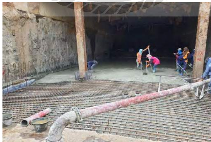
ภาพที่ 4-22 เทคอนกรีต ช่วง DEEP
