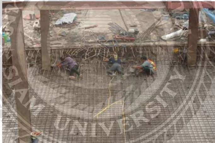
ภาพที่ 4-19 ผูกเหล็กเสริมพื้น ช่วง DEEP
