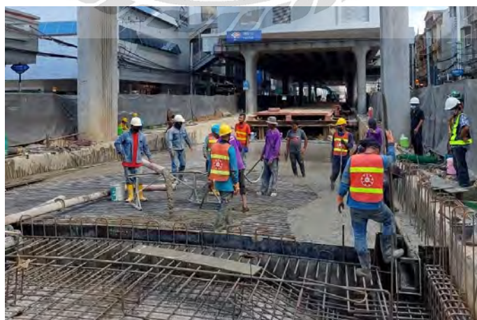
ภาพที่ 4-12 เทคอนกรีต ช่วง SHALLOW
