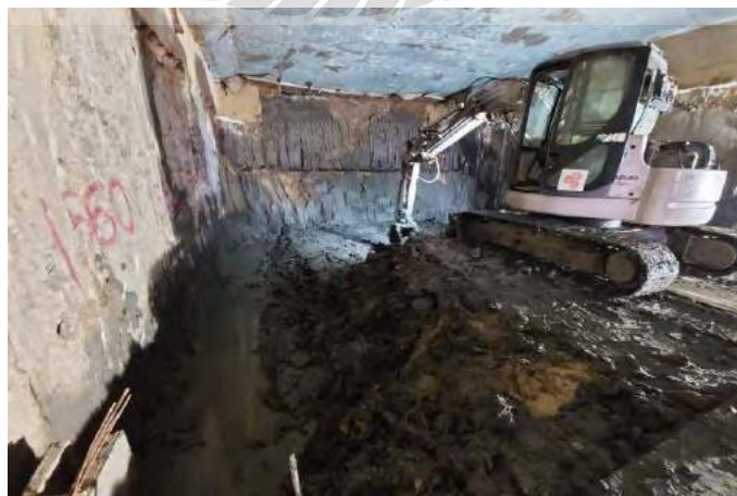
ภาพที่ 4-24 งานขุดดินทางลอด ช่วง TUNNEL
