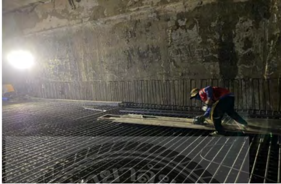
รูปที่ 9 งานเข้าแบบวางน้ำ
