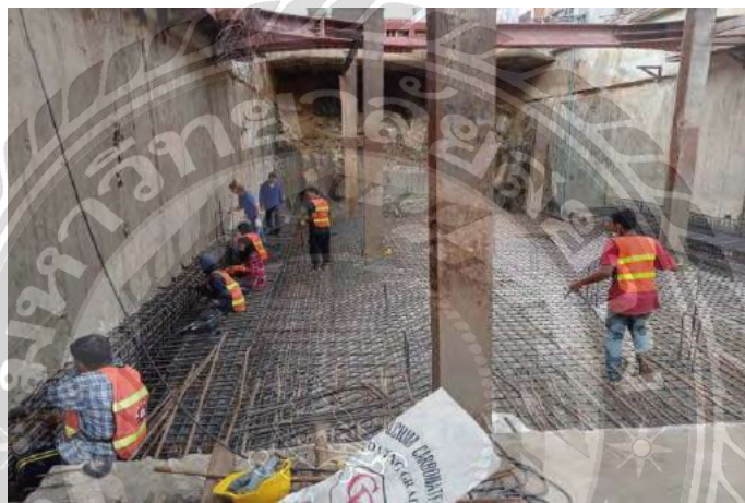
ภาพที่ 4-21 ผูกเหล็กเสริมพื้น ช่วง DEEP (3)
