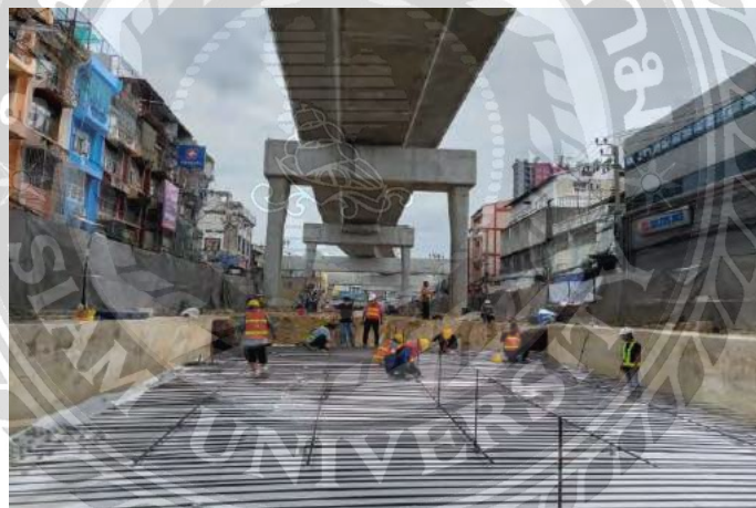
ภาพที่ 4-9 ผูกเหล็กเสริมพื้น ช่วง SHALLOW
