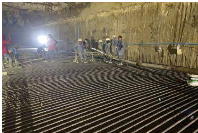
ภาพที่ 4-36 เทคอนกรีต ช่วง TUNNEL (2)
