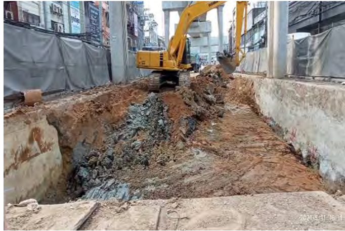
ภาพที่ 4-6 งานขุดดินทางลอด ช่วง SHALLOW (2)
