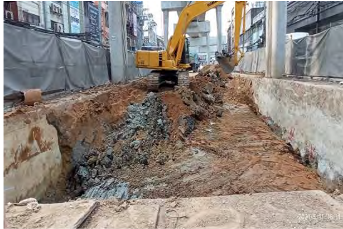
ภาพที่ 4-15 งานขุดดินทางลอด ช่วง DEEP
