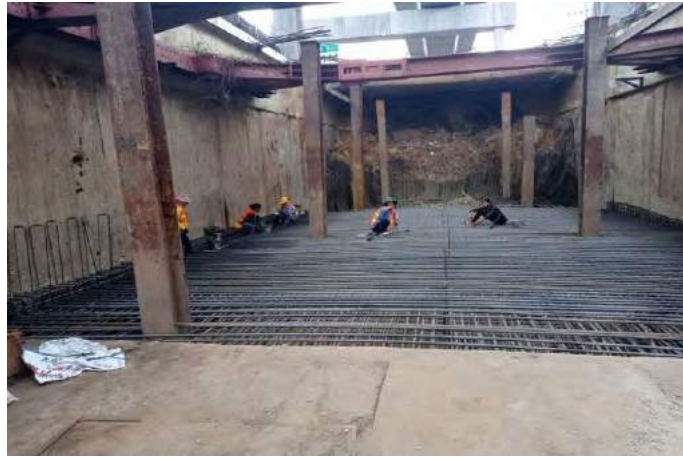
ภาพที่ 4-20 ผูกเหล็กเสริมพื้น ช่วง DEEP (2)
