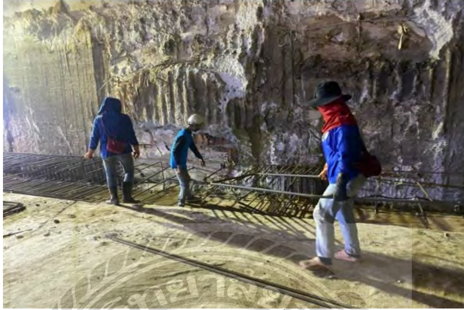
รูปที่ 5 งานลงเหล็กรองรับรางน้ำด้านบน
