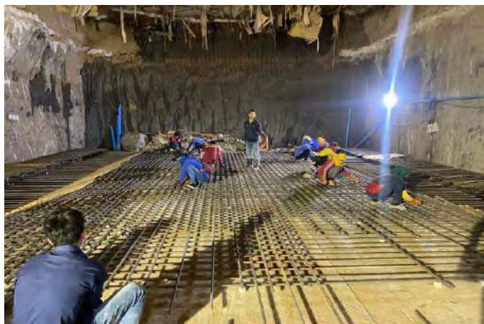
ภาพที่ 4-33 ผูกเหล็กเสริมพื้น ช่วง TUNNEL (4)
