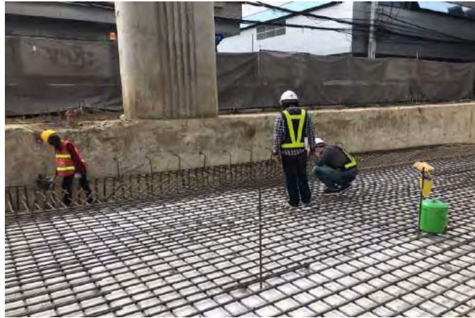
ภาพที่ 4-10 ผูกเหล็กเสริมพื้น ช่วง SHALLOW (2)
