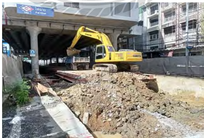
ภาพที่ 4-5 งานขุดดินทางลอด ช่วง SHALLOW
