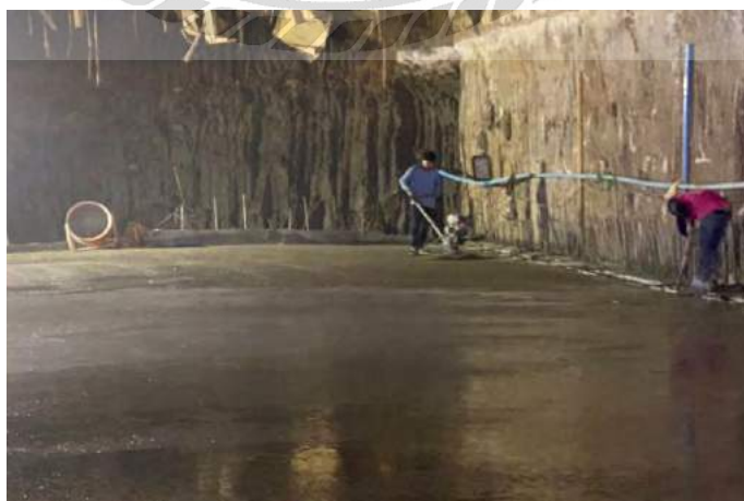
ภาพที่ 4-38 ชัดหน้าปูน ช่วง TUNNEL (2)
