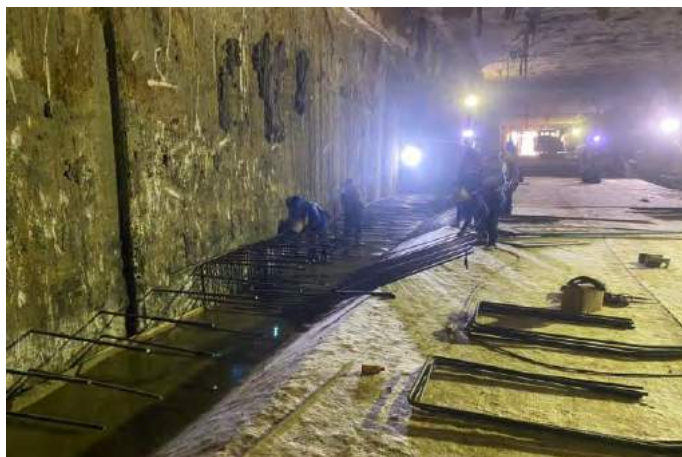
ภาพที่ 4-30 ผูกเหล็กเสริมพื้น ช่วง TUNNEL
