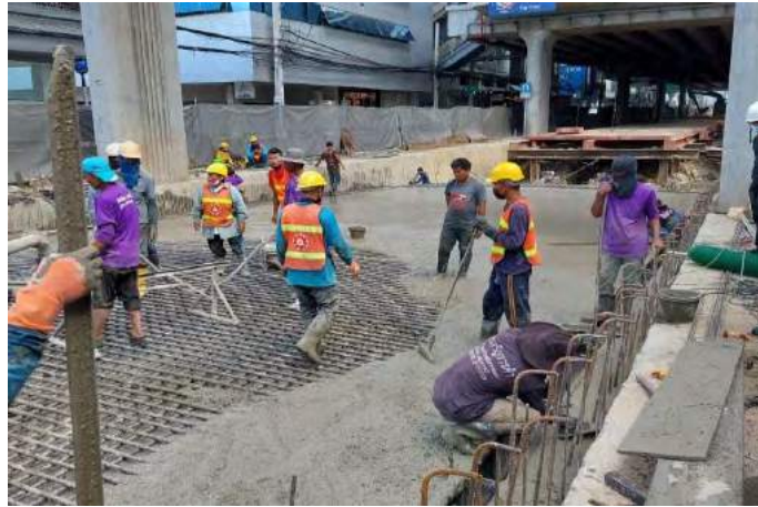
ภาพที่ 4-13 เทคอนกรีต ช่วง SHALLOW (2)
