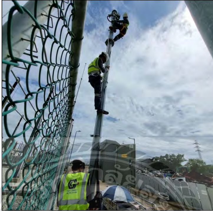
รูปที่ 4.4 ตรวจสอบเช็คกล่องวงจรปิดในเบื้องต้น
