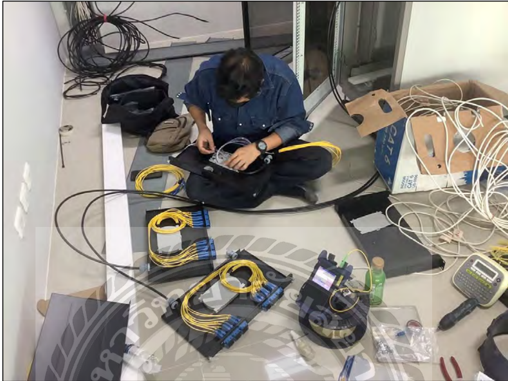
รูปที่ 4.6.2 การเชื่อมต่อสาย Fiber Optic
