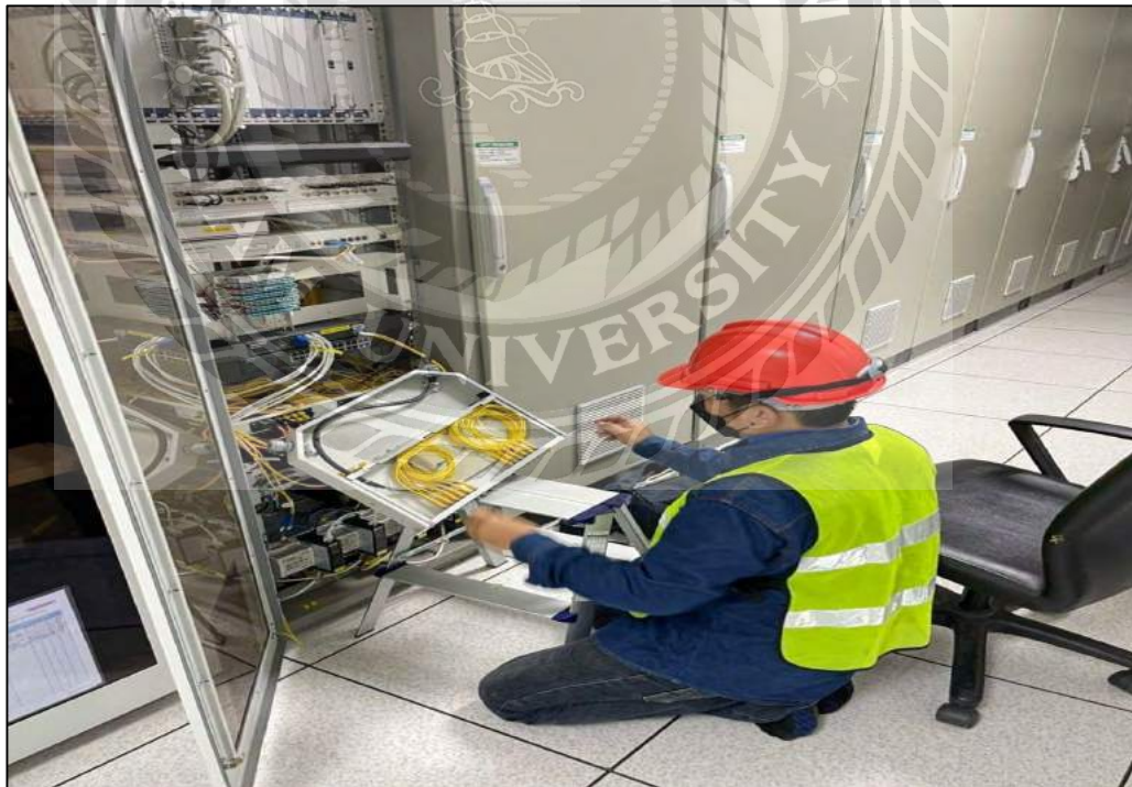
รูปที่ 4.4.1 เช็คสาย Fiber Optic
