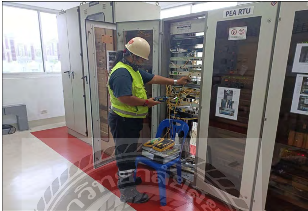
รูปที่ 4.4.3 ทดสอบสายสัญญาณ OTDR Test Report
