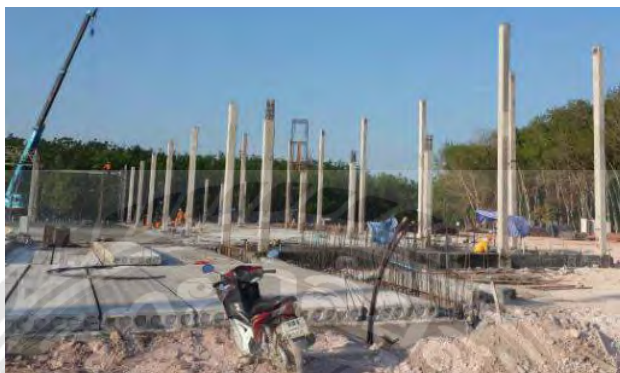
รูปที่ 2.14 อาคารบิ๊กซี นาทวี ที่ก่อสร้างด้วยระบบพรีคาสท์ ที่มา : https://app.builk.com/tekata/n/projects/2022957?lang=th
