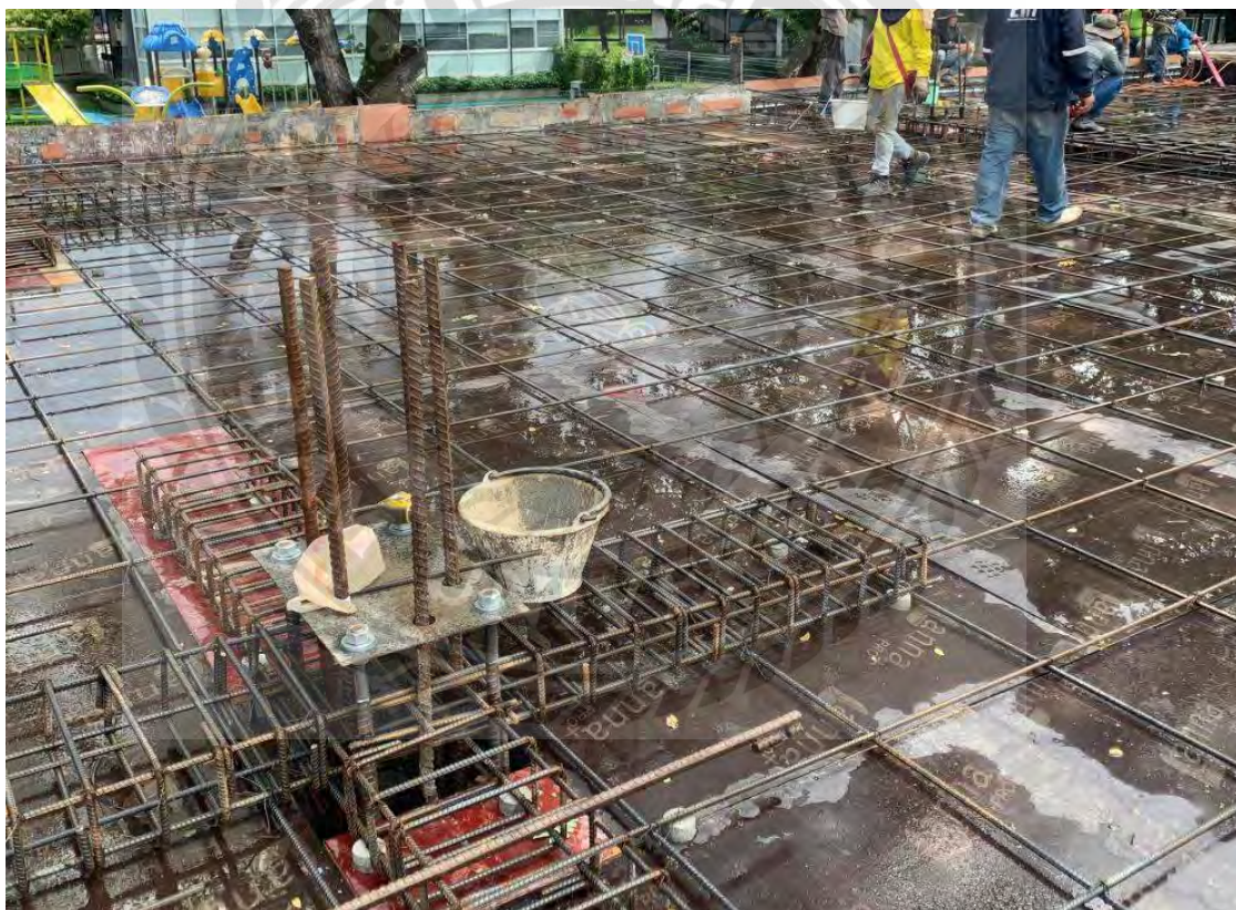
รูปที่ 4.48 การเตรียมเหล็ก Dowel สำหรับเสาก่อเทพื้น โครงสร้าง
