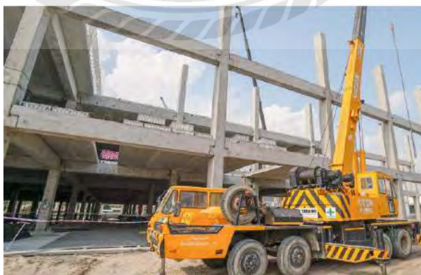
รูปที่ 2.13 อาคารพรีคาสท์โรงงานหรืออาคารคลังสินค้า
