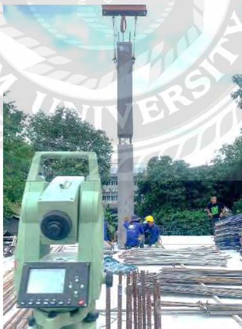
รูปที่ 4.53 ใช้กล้องสำรวจตรวจสอบการติดตั้งทุกครั้ง
