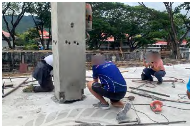
รูปที่ 4.52 การขันน็อตยึดแน่นเสา Column Shoes
