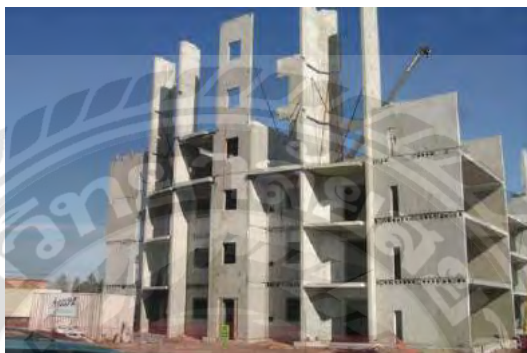
รูปที่ 2.12 อาคารพรีคาสท์ที่กำลังก่อสร้างในระบบพรีคาสท์
