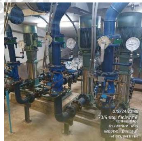
รูปที่ 4.5 การตรวจเช็คระบบปั้มน้ำดี
