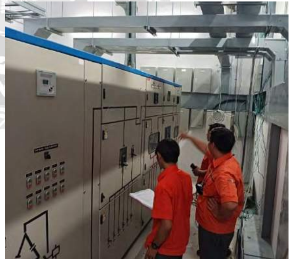
รูปที่ 4.3 การตรวจเช็คระบบไฟฟ้าแรงต่ำ
