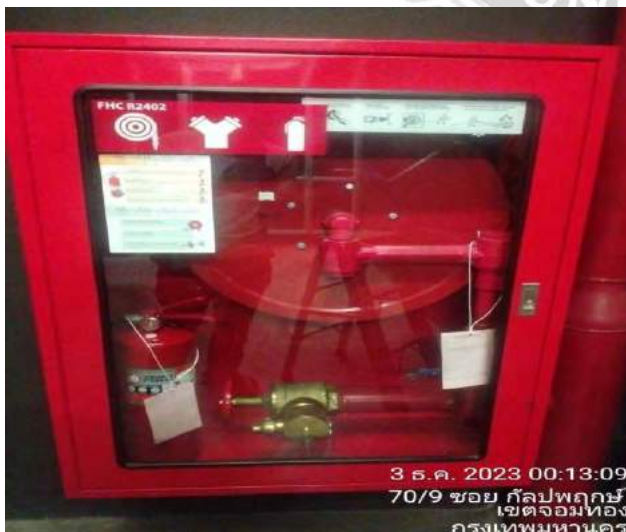
รูปที่ 4.11 การตรวจเช็คตู้ Firehose
