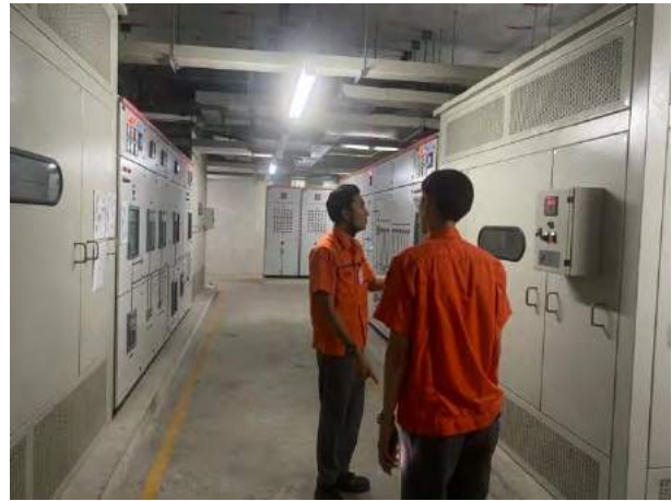
รูปที่ 4.2 การตรวจเช็คหม้อแปลงไฟฟ้า
