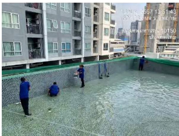
รูปที่ 2.12 การขัดสระว่ายน้ำ
