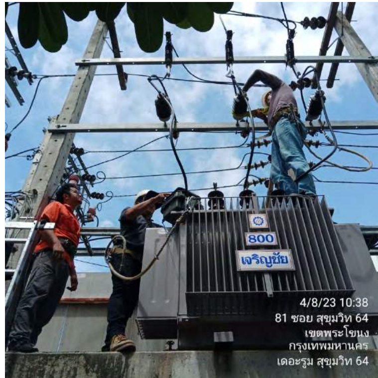
รูปที่ 1 สังกะสีผู้รับเหมาเข้าตรวจสอบหม้อแปลง
