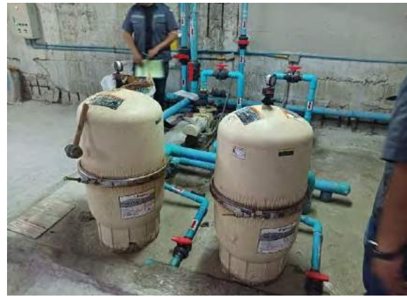
รูปที่ 2.11 ระบบปั๊มส่งน้ำของสระว่ายน้ำและถังกรองตะกอน
