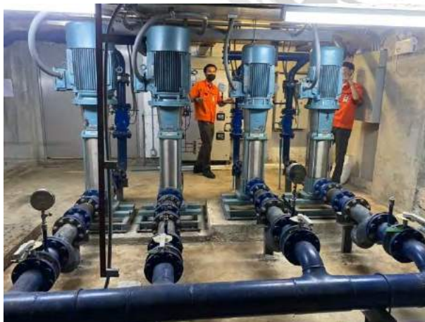
รูปที่ 4.5 การตรวจเช็คระบบปั้มน้ำดี
