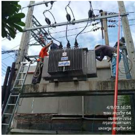
รูปที่ 4.2 การตรวจเช็คหม้อแปลงไฟฟ้า
