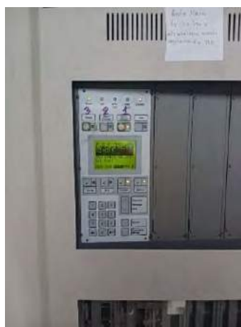
รูปที่ 2.9 ตู้ควบคุมและตู้แสดง สถานะของระบบแจ้งเตือนอัคคีภัย
