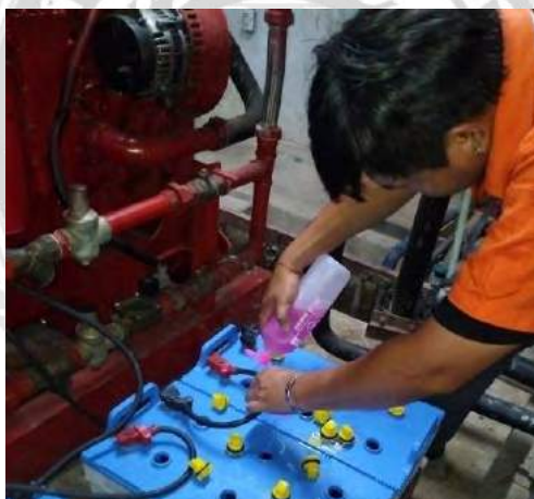
รูปที่ 2.7 การเติมน้ำกลั่น
