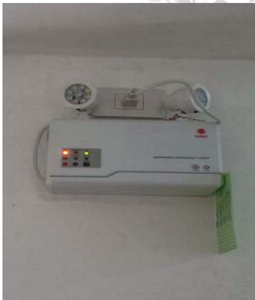
รูปที่ 4.9 การตรวจเช็คระบบแสงสว่างฉุกเฉิน
