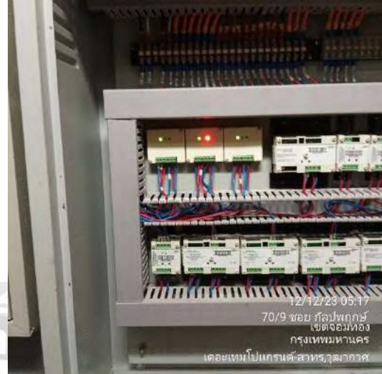
รูปที่ 4.8 การตรวจเช็คระบบสัญญาณเตือนเพลิงไหม้
