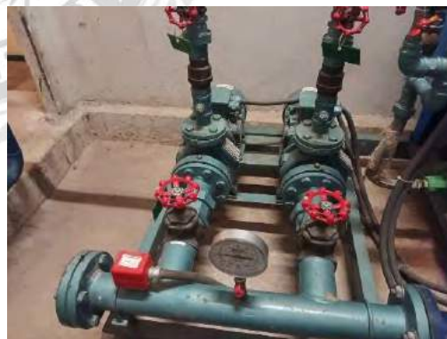
รูปที่ 2.5 ระบบปั้มน้ำเพิ่มแรงดัน
