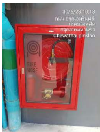
รูปที่ 2.13 ตู้ Firehose และถังดับเพลิง
