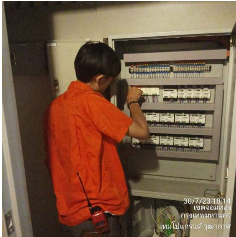
รูปที่ 7 เช็คแผงวงจรของสัญญาณแจ้งเตือน Alarm บนชั้นอาคาร
