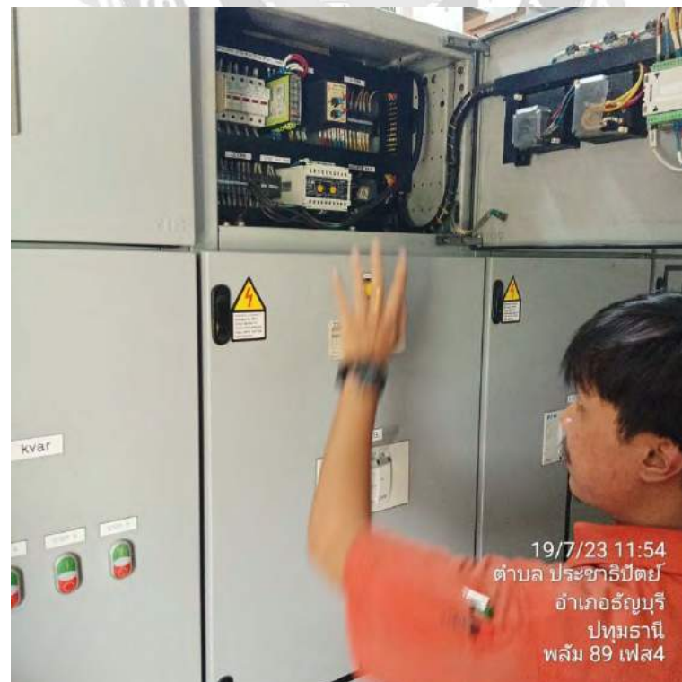
รูปที่ 2 เช็คจุดลัดไฟฟ้ากับเฟสโปรเทคชั่นของตู้ MDB
