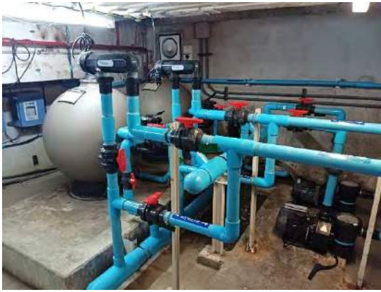
รูปที่ 2.11 ระบบปั๊มส่งน้ำของสระว่ายน้ำและถังกรองตะกอน
