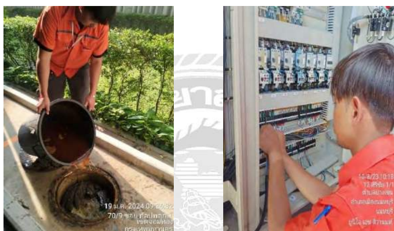
รูปที่ 2.15 การเติมน้ำหมักชีวภาพและการตรวจสอบตู้ควบคุม
