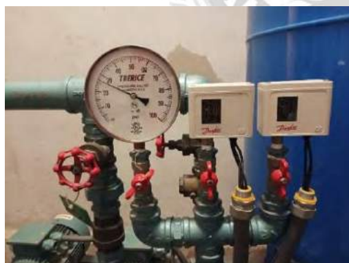
รูปที่ 2.5 ระบบปั้มน้ำเพิ่มแรงดัน
