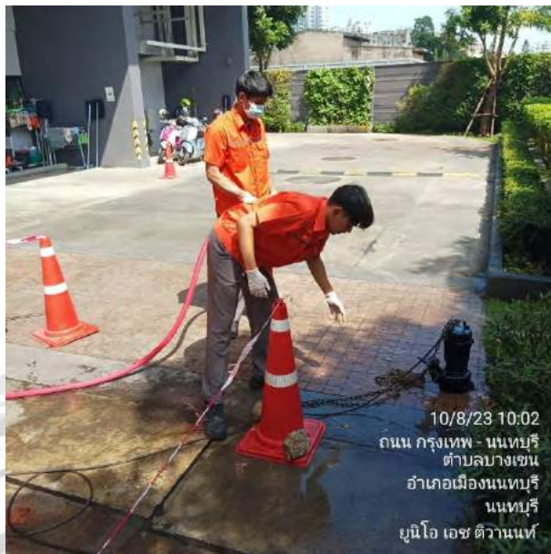
รูปที่ 4.12 การตรวจเช็คระบบบ่อบำบัด
