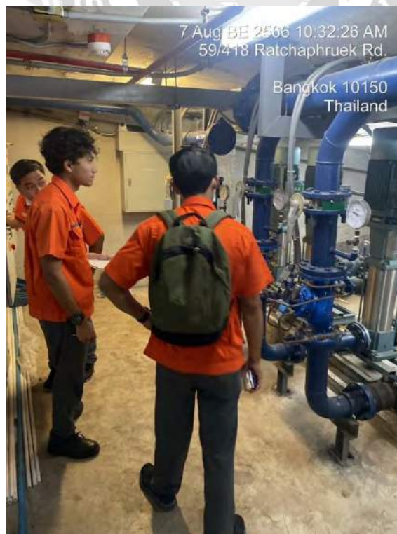
รูปที่ 4 สังกะตแรงดันก่อนและขณะทำงานของ Transfer Pump
