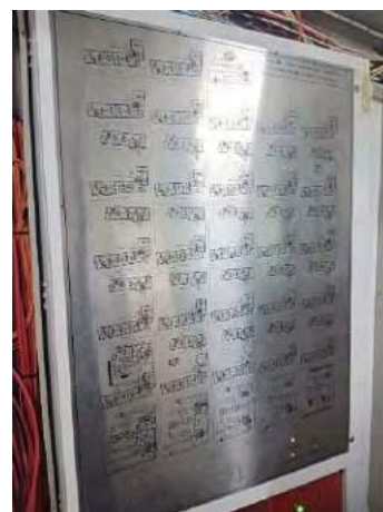
รูปที่ 2.9 ตู้ควบคุมและตู้แสดง สถานะของระบบแจ้งเตือนอัคคีภัย
