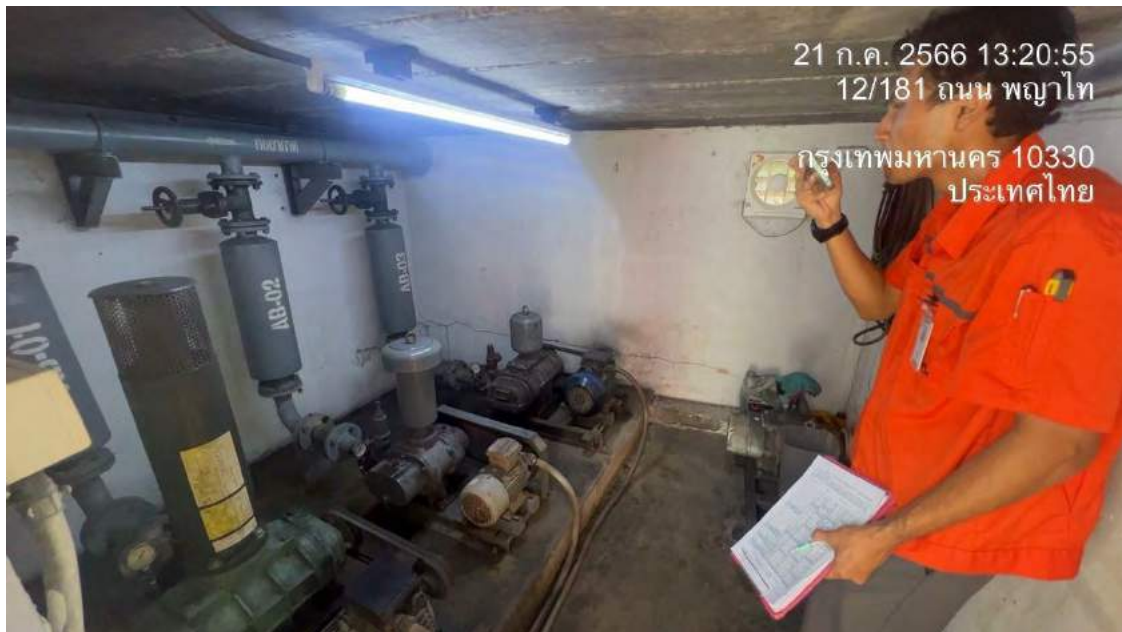
รูปที่ 5 สังกะตฤรงดันก่อนและขณะทำงานของBooster Pump
