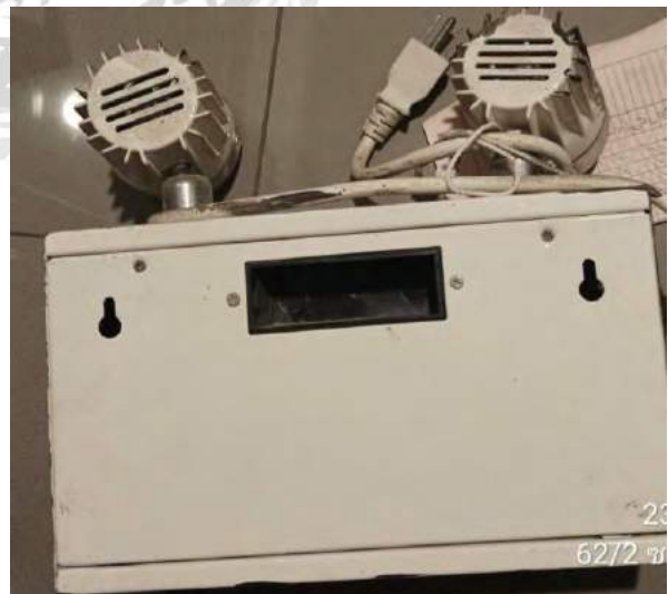
รูปที่ 4.9 การตรวจเช็คระบบแสงสว่างฉุกเฉิน
