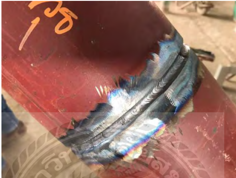
รูปที่ 3.9 ขั้นตอนการทำความสะอาดท่อ
