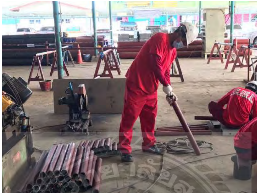
รูปที่ 3.3 ขั้นตอนการ ทำความสะอาดท่อ
