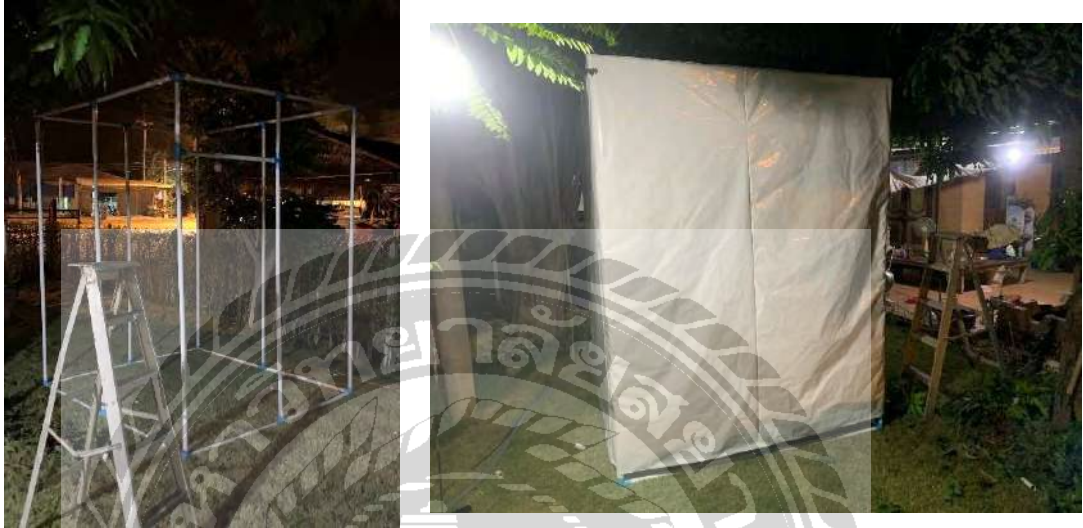
ภาพที่ 3.18 ประกอบโครงขึ้นใหม่และนำผ้าใบมาสวม
