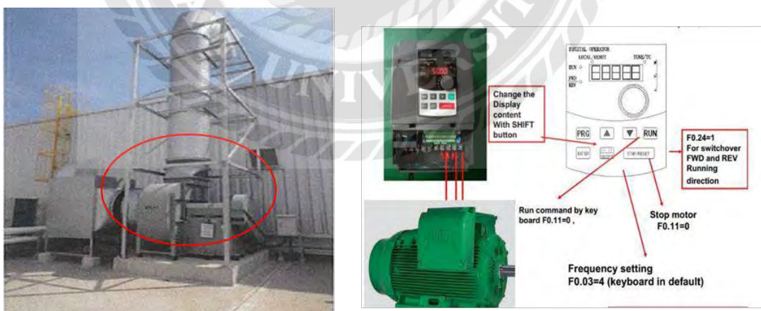
รูปที่ 4.11 แสดงตำแหน่ง BLOWER ของระบบ DUCT COLLECTOR
