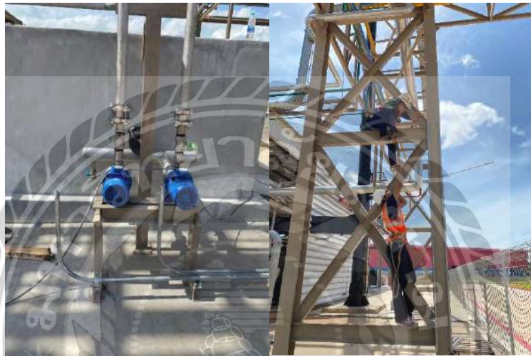
รูปที่ 4.7 การเดินท่อร้อยสายเข้ามอเตอร์และลากสายเข้าตู้คอนโทรล
