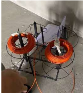
รูปที่ 4.5 การร้อยสาย FRC for Fire Alarm System. (Lift)
