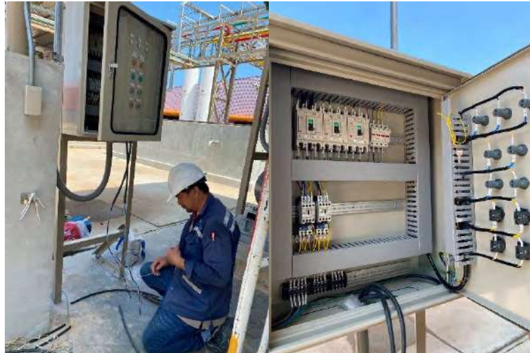
รูปที่ 4.9 จั๊มสายเข้าสู่ตู้คอนโทรล
