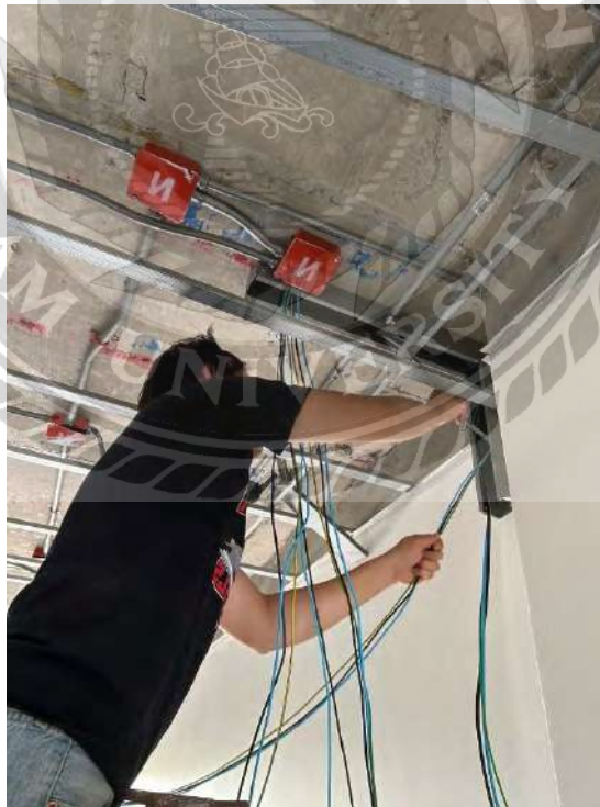
รูปที่ 4.4 การร้อยสาย IEC01 for Power and Lighting System. (In rooms)
