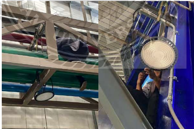
รูปที่ 4.10 เดินท่อและติดตั้งคอมไฟกันแรงระเบิด (Explosion Proof)
