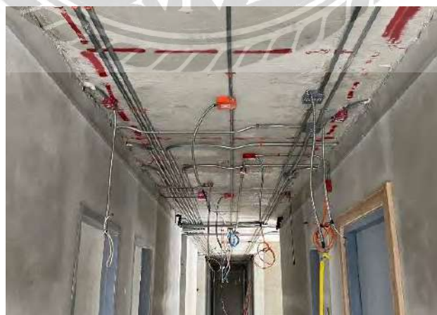
รูปที่ 4.2 การเดินท่อส่วนกลางทางเดินของหอพัก
