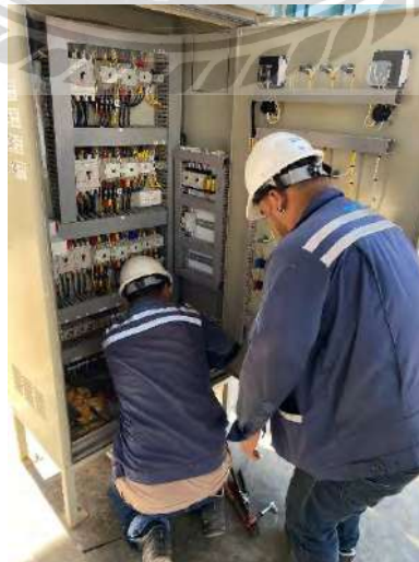
รูปที่ 4.13 จัดสายเข้าสู่ตู้คอนโทรล
