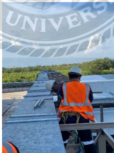
รูปที่ 4.8 ลากสายเข้าตู้คอนโทรล
