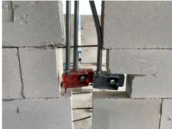
รูปที่ 4.3 การติดตั้งบ็อกเพื่อทำการร้อยสายปลั๊กและสวิตช์ไฟ
