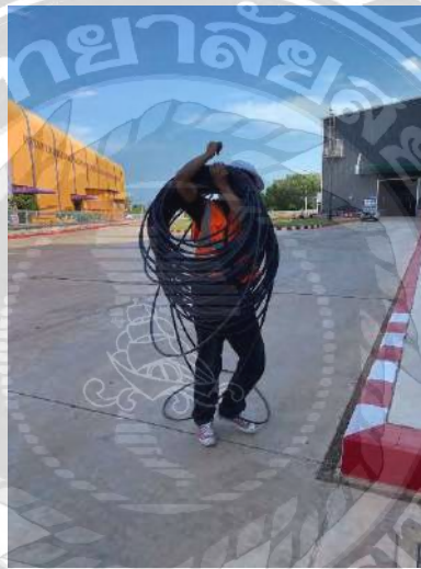
รูปที่ 4.12 เตรียมสายเพื่อลากสายเข้าสู่ตู้ คอนโทรล
