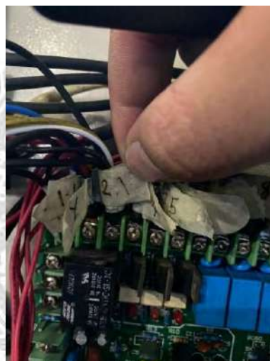
รูปที่ 4.8 ทำมาสดจุดที่ 2.1 ในบอร์ดควบคุม
