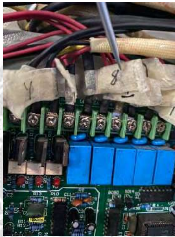
รูปที่ 4.14 ทำมาสดจุดที่ 8 ในบอร์ดควบคุม
