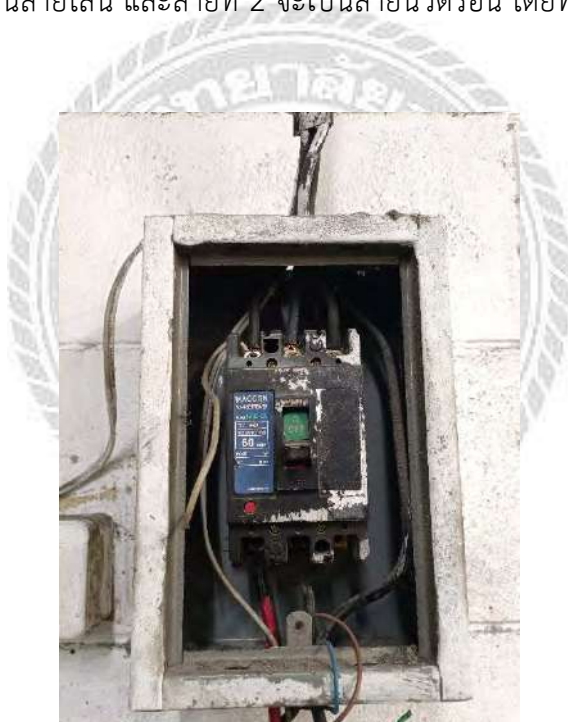
รูปที่ 4.1 เบรกเกอร์ที่เข้าเครื่องเคลือบกระดาดด้วยรังสี UV
