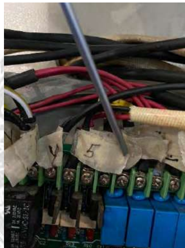
รูปที่ 4.11 ทำมาสดจุดที่ 5 ในบอร์ดควบคุม
