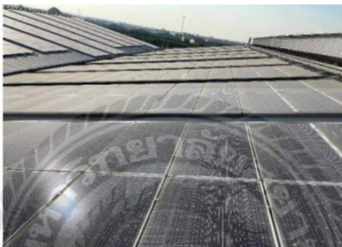
รูปที่ 3.3 แผงโซลาร์เซลล์ แบบ Polycrystalline Silicon Solar cell
