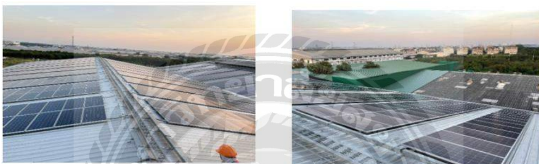
รูปที่ 3.5 ติดตั้งแผงเซลล์โซลาร์เซลล์แสงอาทิตย์บนหลังคา
