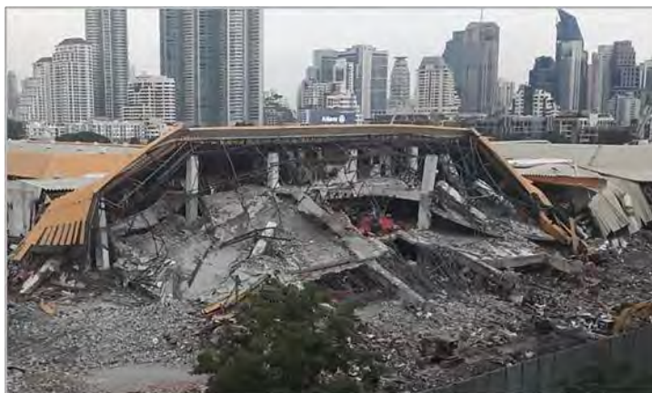
รูปที่ 2.5 : ศูนย์การประชุมแห่งชาติสิริกิติ์ขณะปรับปรุง ที่มา : https://www.thaipost.net/main/detail/47612
